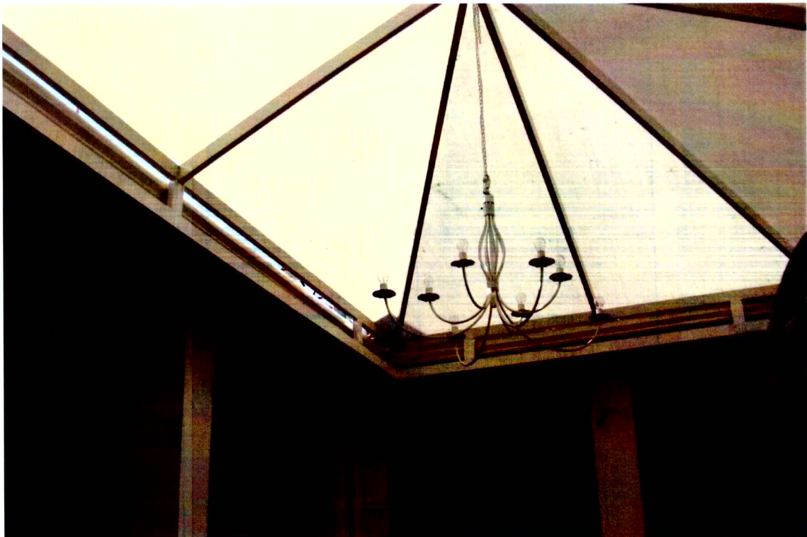
Detalhe da Cobertura do pátio interno.
