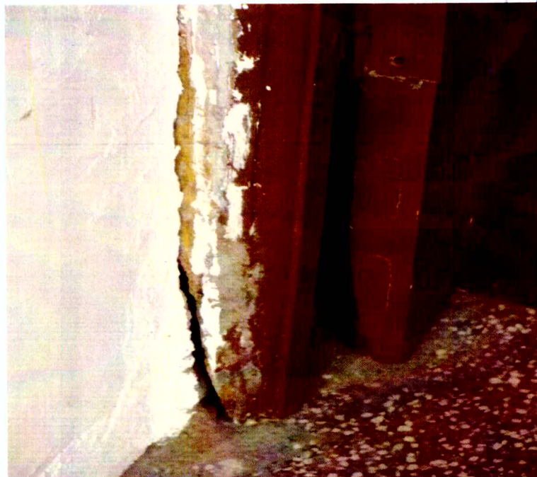
Detalhe de portal deteriorado, não recuperado (25.06.2015)
