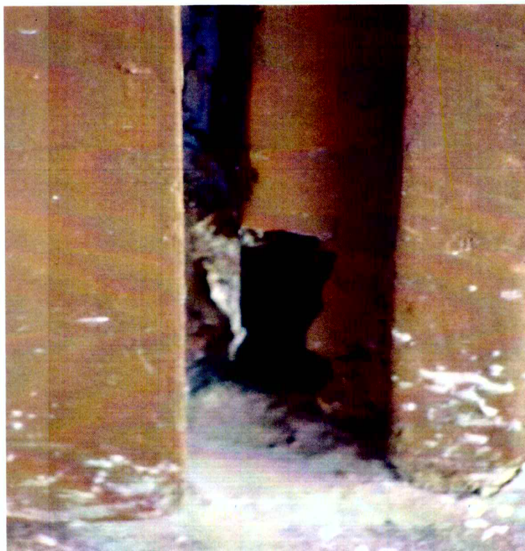
Detalhe fotográfico do marco deteriorado e dobradiça sem parafusos de fixação (25.06.2015)
