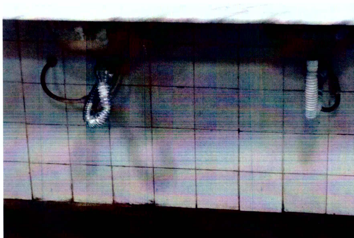
Item 11.1 / Detalhe sifão / Banheiro Feminino / Não há sinais visíveis de substituição, em total desacordo com o especificado em meta.
