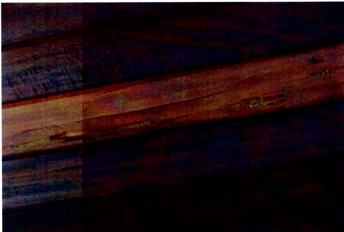
Item 9.6 – Forro deteriorado pela ação de cupins. Não há indícios da execução da meta proposta.
