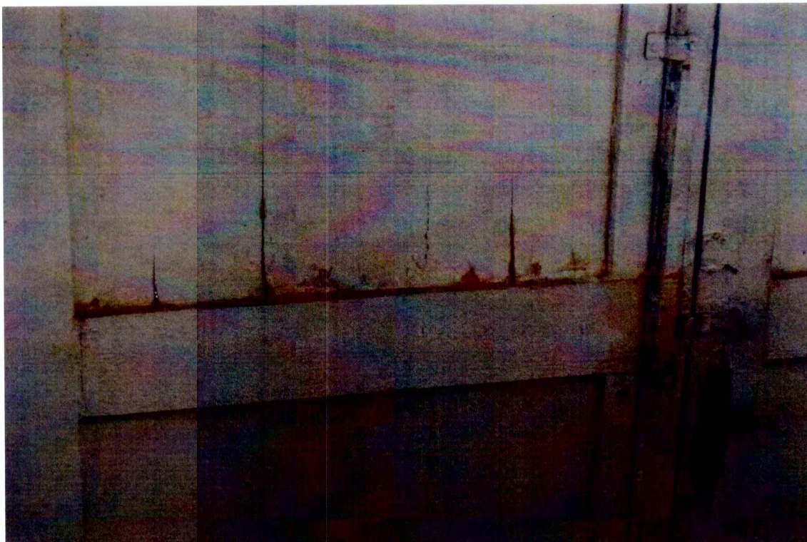
Recuperação do item 4.4, observa-se a precariedade da recuperação e o aparecimento de infiltrações, pintura indevida no ferrolho, espelho e maçaneta (26.06.15)
