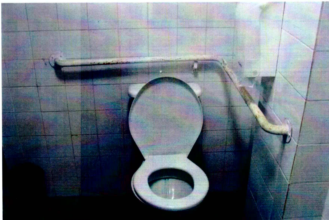
Item 11.5 – A barra de apoio não foi substituída. Este serviço foi executado na recuperação do prédio executada no ano de 2006.
