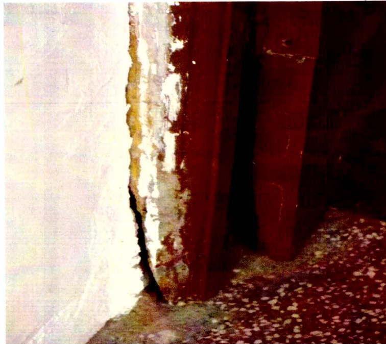
Detalhe de portal deteriorado, não recuperado (25.06.2015)
