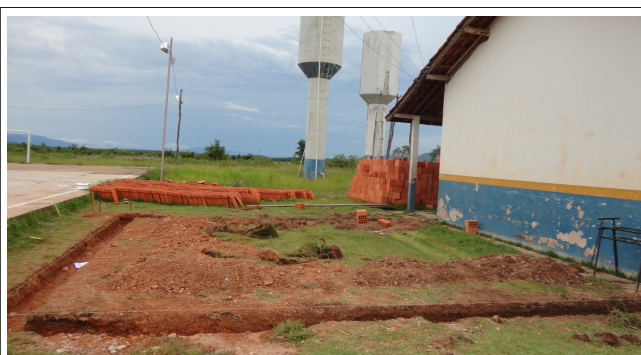
Reforma e ampliação na Escola da Comunidade Salobra Grande em março de 2012
