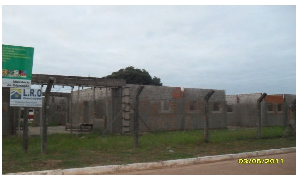
Situação da obra da creche em 03.05.2011
