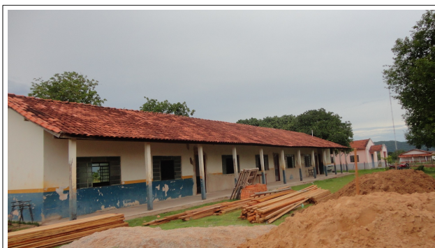
Reforma e ampliação na Escola da Comunidade Salobra Grande em março de 2012
