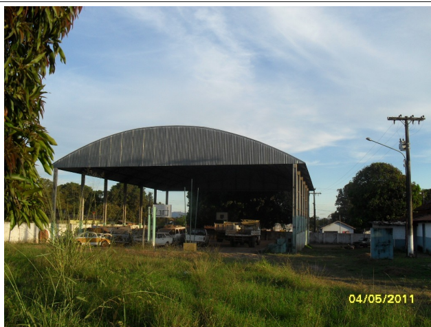
Visão do barracão onde se encontram a maioria dos veículos que não estão em funcionamento.
