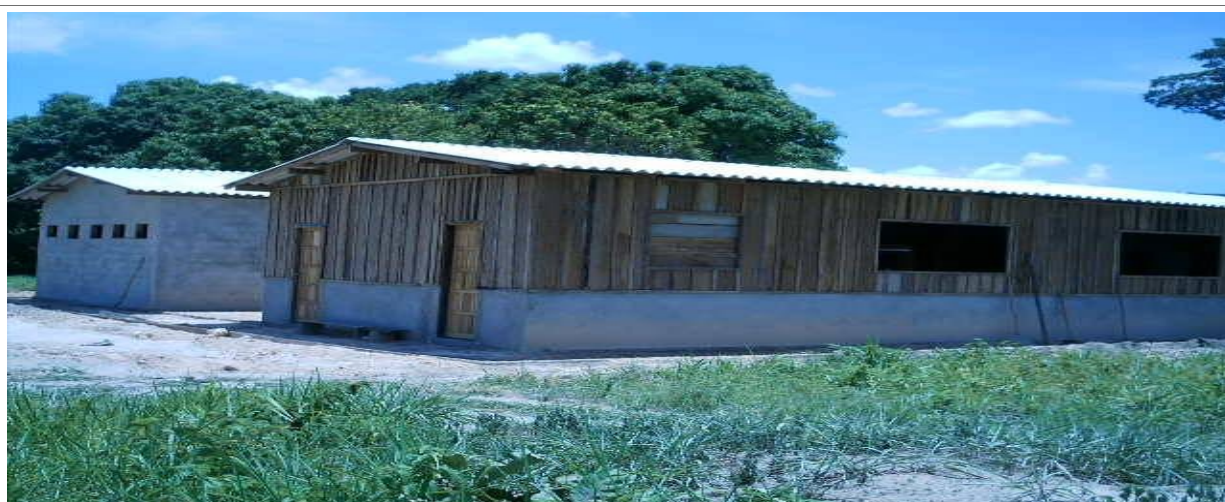
Fotos apresentadas pela Prefeitura – Escola construída em 2008 na comunidade Vãozinho
