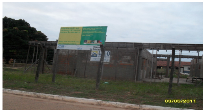
Situação da obra que está paralisada em 03.05.2011
