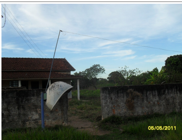
Situação de abandono em que se encontra a escola
