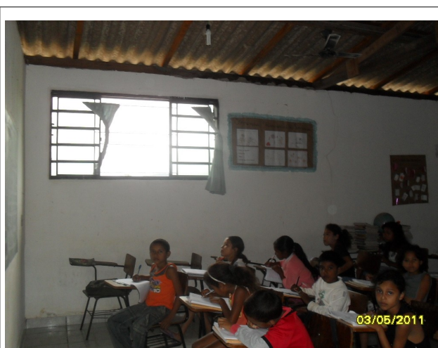
Interior da sala de aula: janelas altas e irregulares, teto baixo e de eternit causando abafamento
