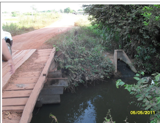
Esgoto do Bairro Planalto sendo despejado no córrego do Cavalo
