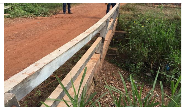
Figura 202 Detalhe do guarda corpo
