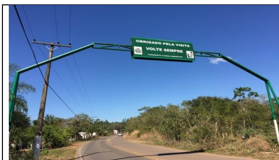
Figura 117 Vista do pórtico
