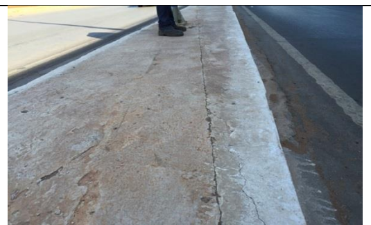
Figura 218 Detalhe do passeio em concreto
