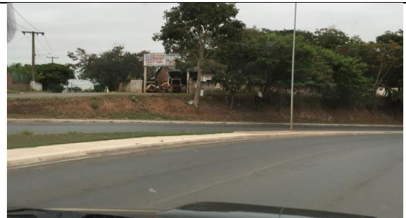
Figura 148 Passeio em concreto na avenida Ulisses Pompeu
