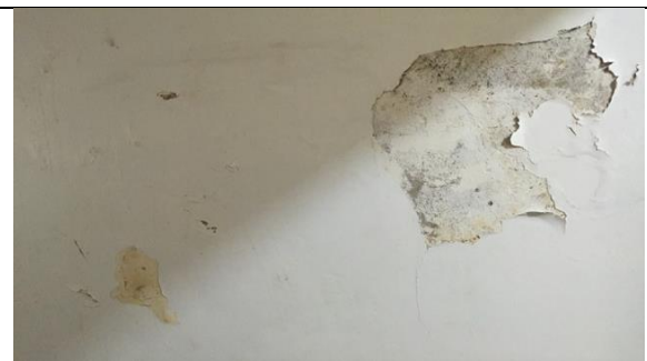
Figura 50 Detalhe da parede interna
