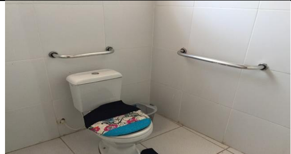
Figura 40 Instalação das barras PNE
