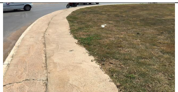
Figura 152 Detalhe passeio concreto
