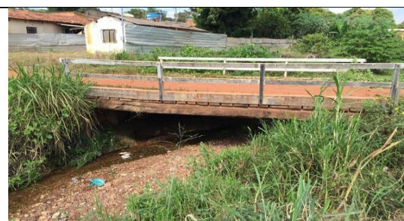
Figura 204 Vista lateral da ponte
