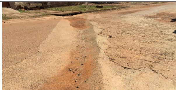
Figura 185 Valeta para coleta de água sob a pavimentação
