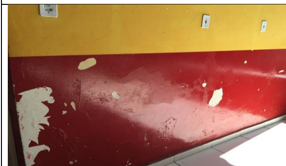
Figura 29 Detalhe da pintura externa
