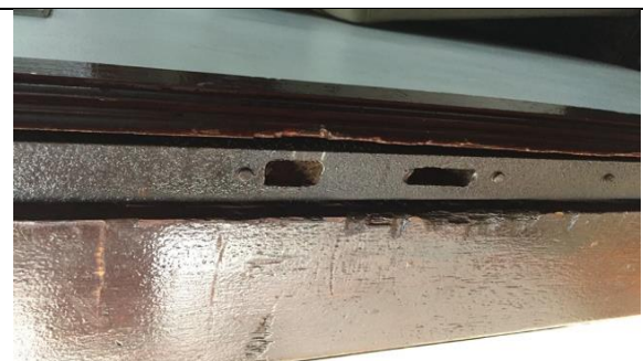
Figura 52 Detalhe da instalação da porta
