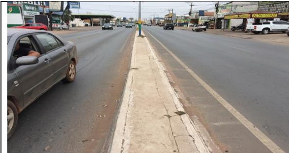
Figura 145 Detalhe do passeio em concreto
