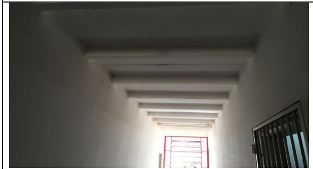
Figura 111 Detalhe da laje
