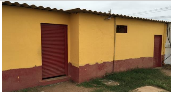
Figura 79 Fachada do vestiário 1
