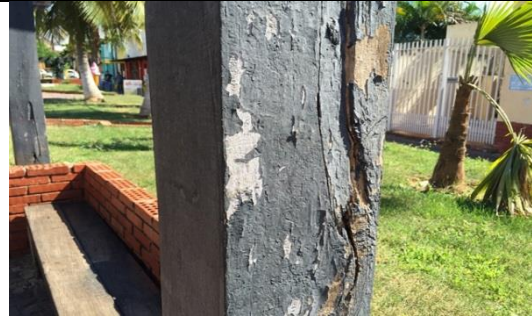
Figura 100 Detalhe do pilar de madeira
