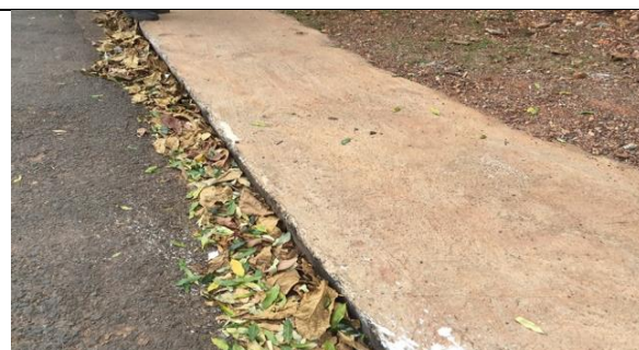
Figura 230 Detalhe do meio fio e sarjeta
