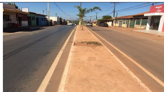
Figura 214 Detalhe do passeio em concreto
