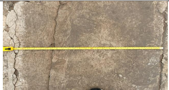
Figura 146 largura do passeio em concreto de 65 cm
