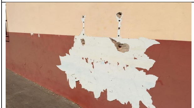
Figura 115 Detalhe da pintura exterior
