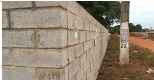
Figura 73 Muro da parte lateral
