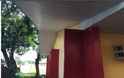
Figura 19 Detalhe do beiral em pvc
