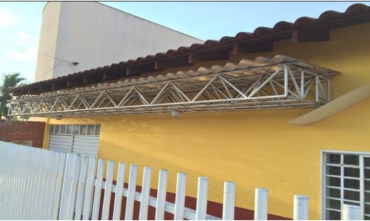
Figura 3 Instalações de telhas translúcidas
