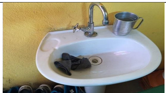
Figura 84 Detalhe da pia com torneira
