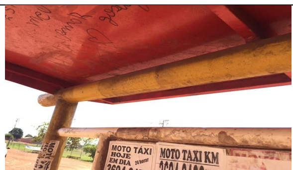
Figura 154 Detalhe da pintura em estrutura metálica
