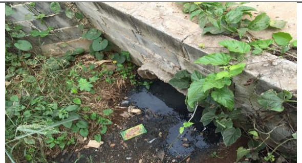
Figura 158 Detalhe da entrada do tubo de concreto
