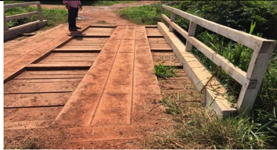
Figura 179 Vista geral da ponte de madeira
