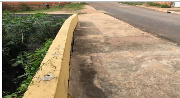
Figura 159 Alvenaria com bloco de concreto
