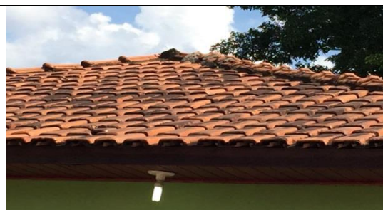
Figura 16 Detalhe do telhado
