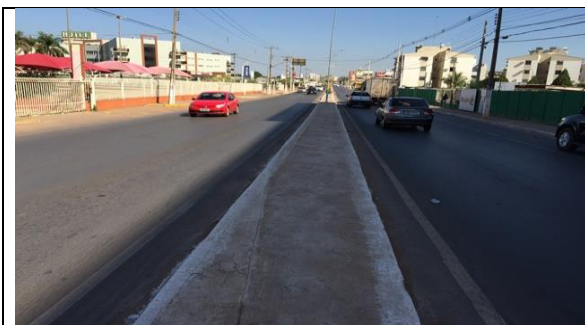
Figura 217 Vista geral do passeio em concreto
