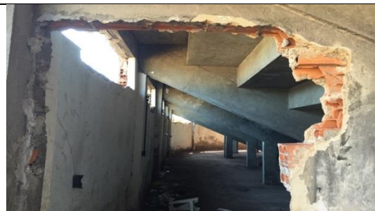
Figura 96 Detalhe sob a arquibancada
