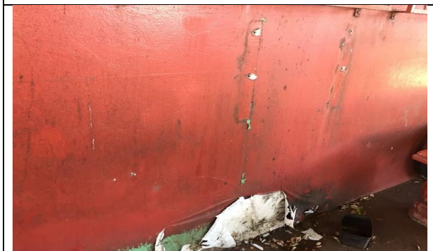
Figura 113 Detalhe da parede exterior
