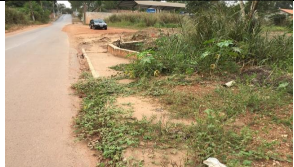
Figura 192 Detalhe do piso de concreto
