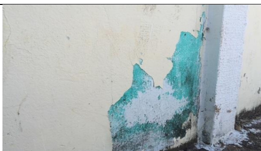
Figura 55 Detalhe da qualidade da pintura do muro lateral
