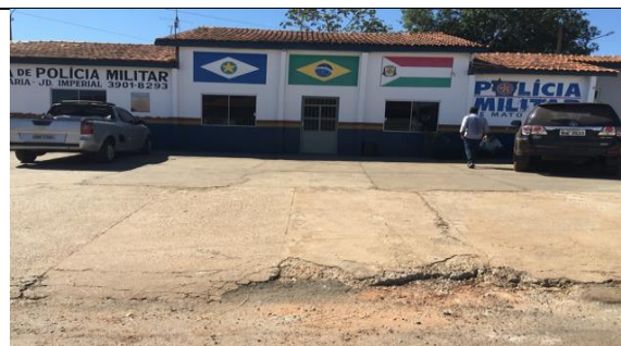
Figura 198 Detalhe da calçada
