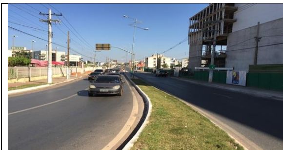
Figura 223 Vista geral da iluminação pública
