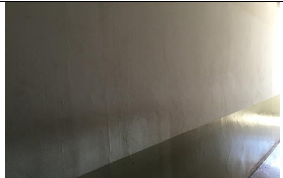
Figura 110 Detalhe pintura interior
