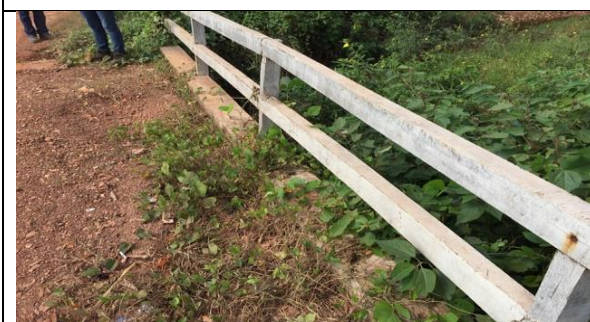
Figura 203 Detalhe do guarda corpo
