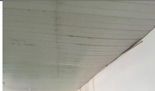
Figura 21 Detalhe do forro de PVC
