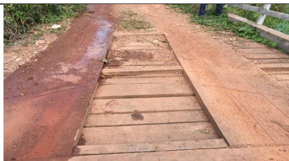
Figura 205 Visão geral da ponte
