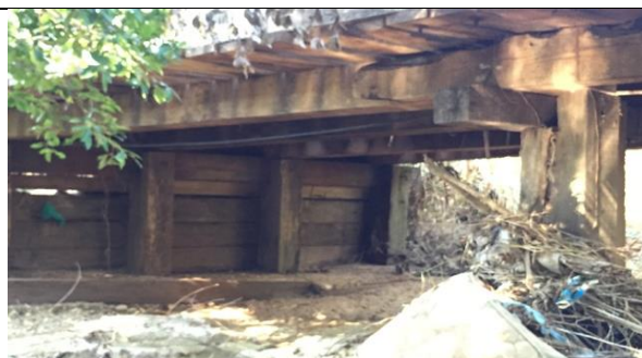
Figura 169 Detalhe do pilar de madeira
