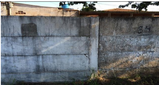
Figura 61 Detalhe das placas de concreto substituídas
