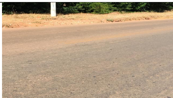
Figura 163 Detalhe da sinalização horizontal
