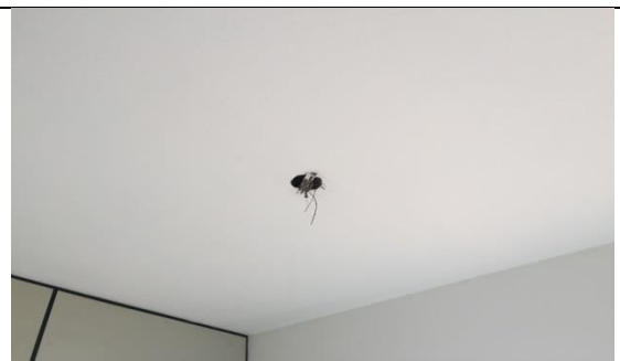
Figura 106 Detalhe da laje
