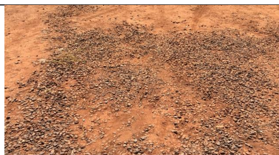
Figura 126 Detalhe da imprimação
