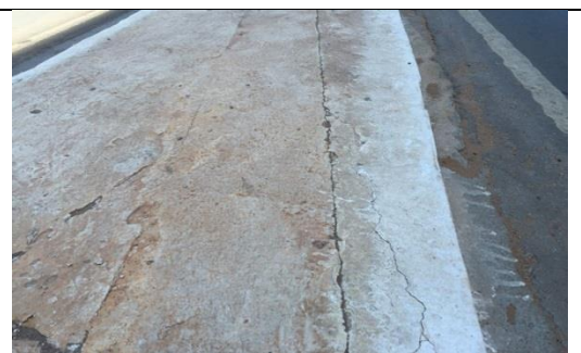
Figura 220 Detalhe do passeio em concreto
