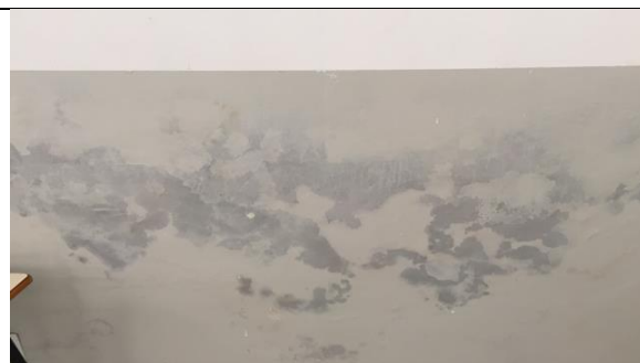
Figura 28 Detalhe da pintura interna
