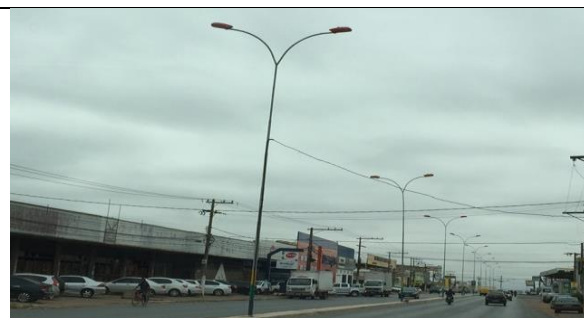
Figura 222 Detalhe do poste de iluminação
