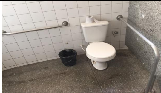
Figura 4 Barras para PNE
