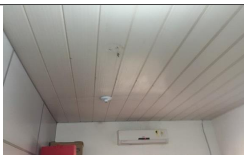
Figura 12 Detalhe instalação do forro e luminária tipo spot
