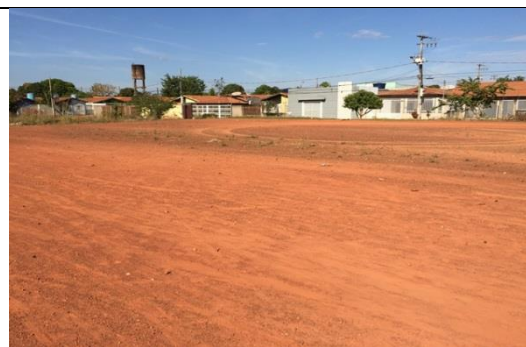
Figura 122 Vista do terreno
