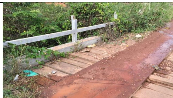
Figura 206 Detalhe do guarda corpo
