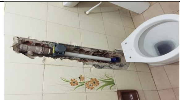
Figura 48 Detalhe da instalação do vaso
