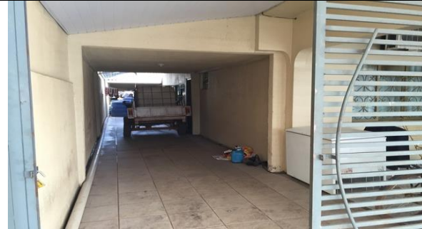
Figura 45 Fachada da casa
