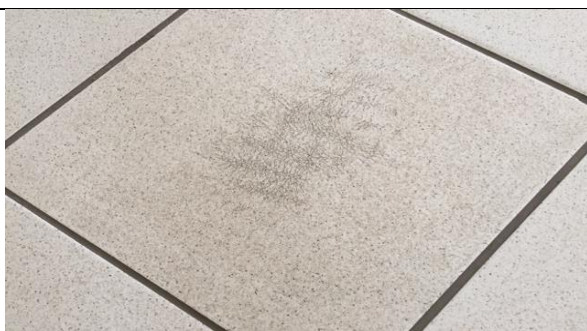
Figura 35 Detalhe do piso
