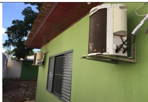
Figura 14 Instalação do ar condicionado
