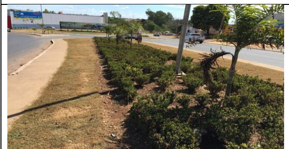
Figura 151 Detalhe canteiro central
