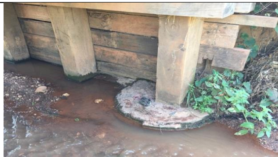
Figura 181 Detalhe da fundação dos pilares
