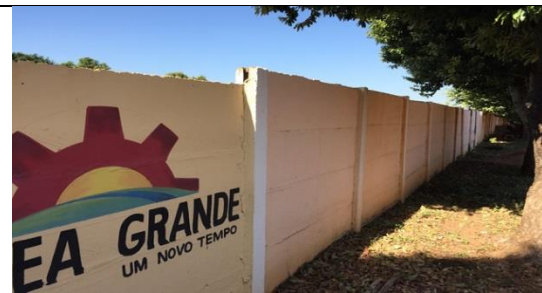
Figura 62 Detalhe da pintura externa
