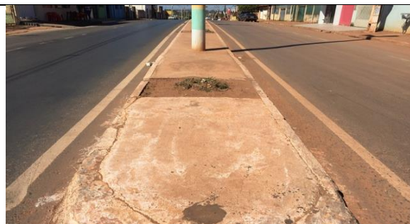
Figura 215 Detalhe do passeio em concreto
