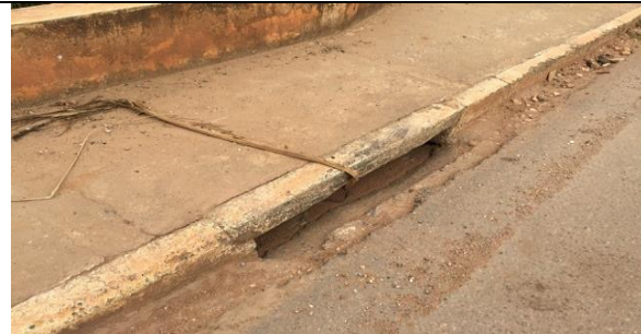
Figura 194 Detalhe da boca para bueiro
