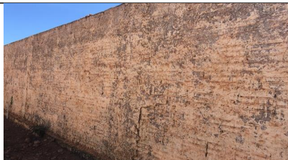
Figura 89 Detalhe muro sem reboco
