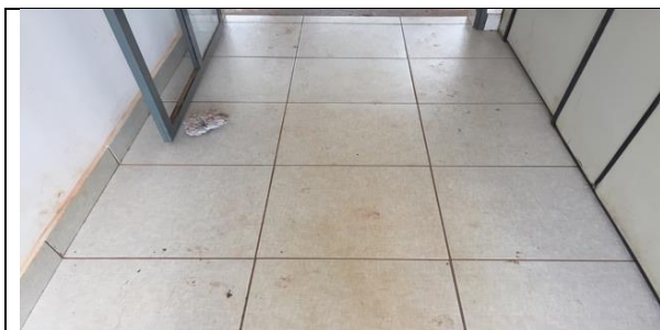
Figura 107 Detalhe do piso
