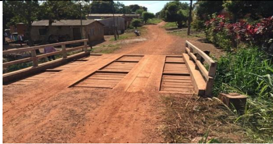
Figura 175 Vista geral da ponte de madeira
