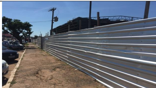
Figura 93 Tapume de telha zincada
