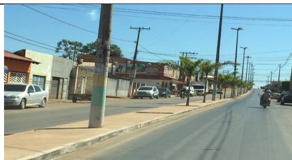
Figura 213 Vista geral do passeio em concreto
