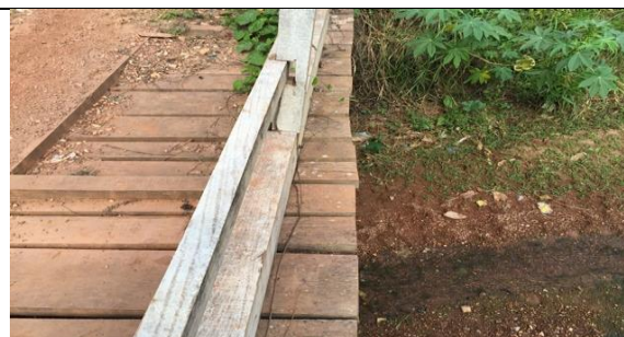
Figura 208 Detalhe do guarda corpo
