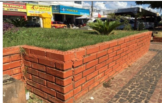
Figura 102 Detalhe da alvenaria de tijolo aparente
