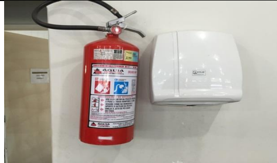
Figura 6 Instalação de extintores
