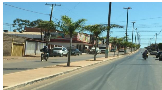
Figura 216 Detalhe do meio fio
