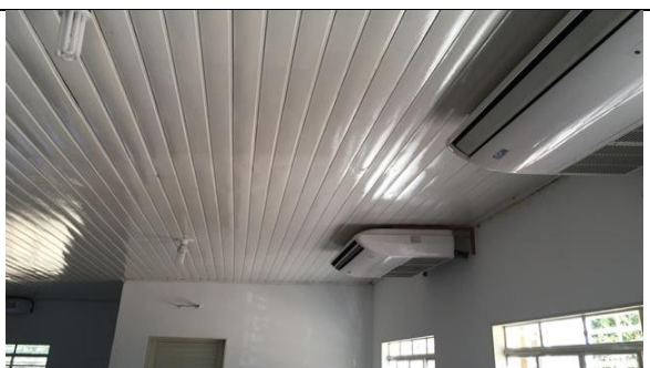
Figura 37 Detalhe do forro
