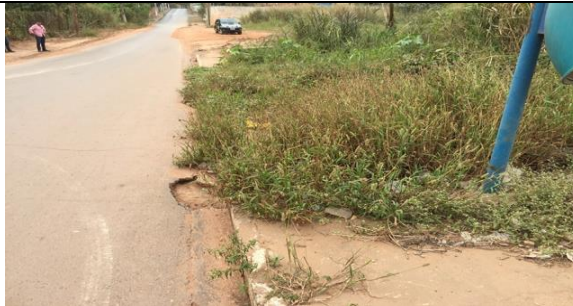
Figura 193 Detalhe do piso de concreto
