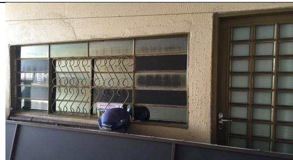
Figura 47 Detalhe da esquadria e vidros
