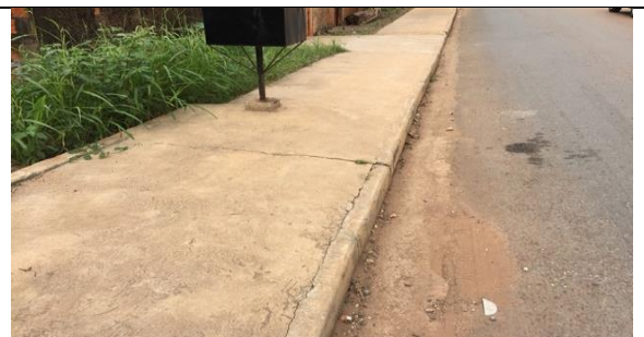
Figura 156 Detalhe da calçada
