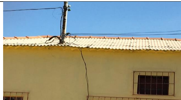
Figura 42 Detalhe do telhado de fibrocimento
