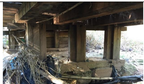
Figura 168 Detalhe da longarina de madeira
