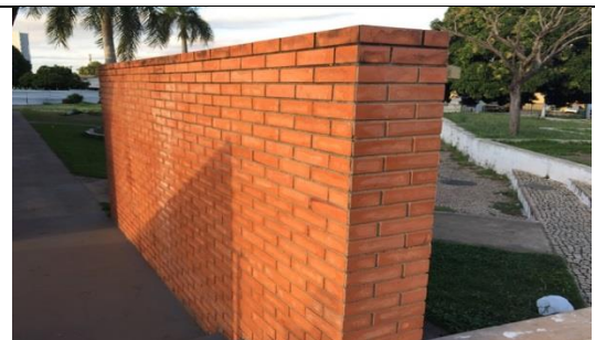
Figura 8 Mureta de tijolinho aparente
