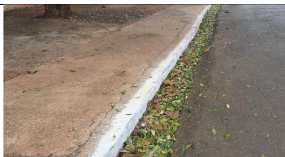
Figura 229 Detalhe do meio fio
