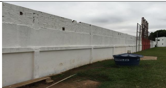
Figura 81 Muro ao redor do campo
