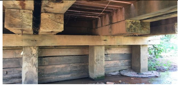
Figura 180 Detalhe dos pilares
