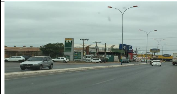
Figura 147 Passeio em concreto na avenida Ulisses Pompeu
