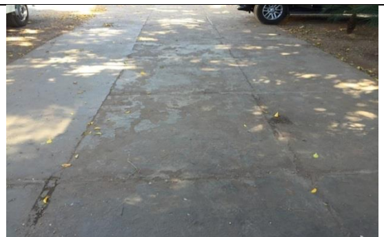
Figura 116 Detalhe da calçada
