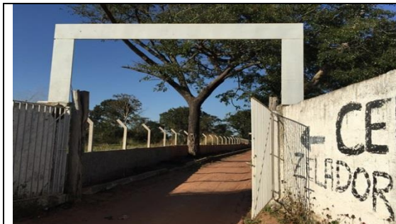
Figura 97 Vista do pórtico metálico
