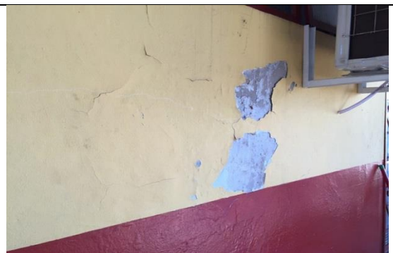
Figura 114 Detalhe da parede exterior
