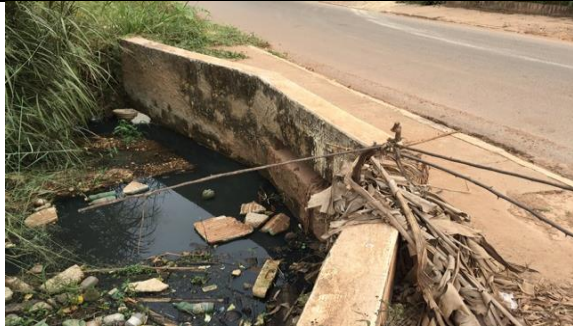
Figura 191 Detalhe do bueiro
