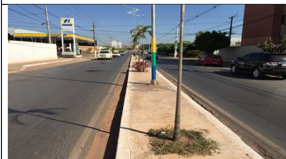
Figura 219 Detalhe do meio fio
