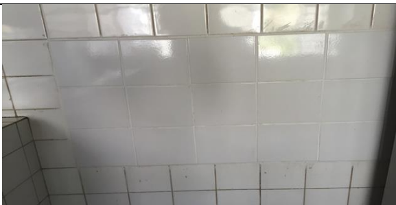
Figura 43 Detalhe do azulejo banheiro
