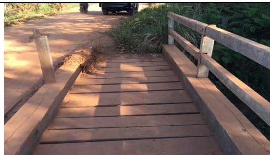
Figura 172 Detalhe de guarda corpo de madeira
