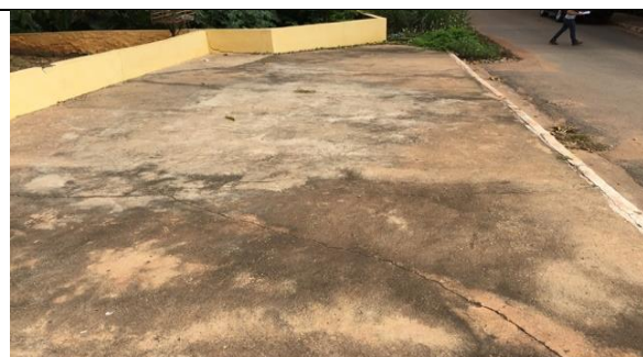
Figura 162 Piso de concreto acabamento rústico
