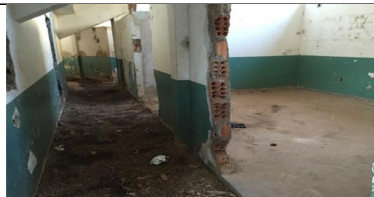
Figura 92 Detalhe de alvenaria demolida
