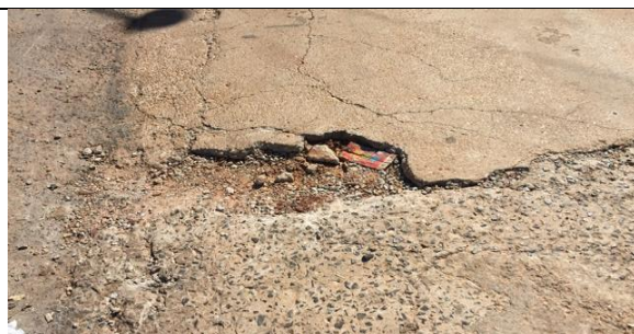
Figura 199 Detalhe da calçada
