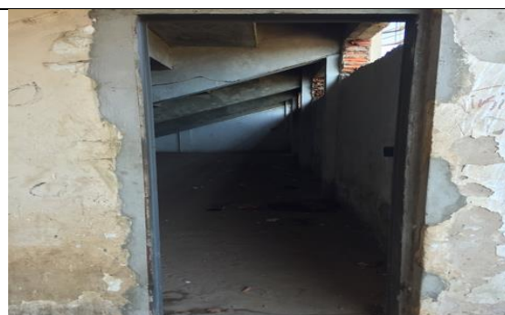
Figura 144 Detalhe do portal metálico sem portas
