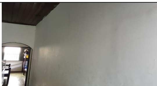
Figura 15 Instalação da parede de gesso cartonado
