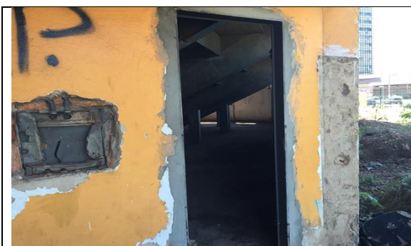
Figura 143 Detalhe do portal metálico sem portas
