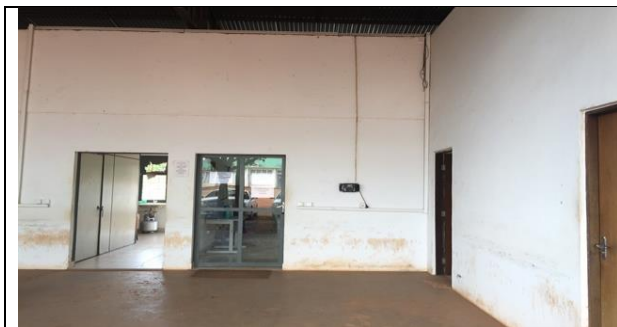
Figura 105 Vista frontal do prédio
