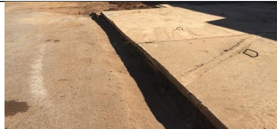
Figura 66 Tampa de acesso aos filtros
