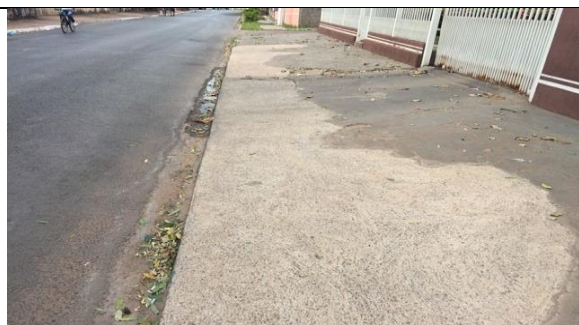
Figura 227 Detalhe da calçada
