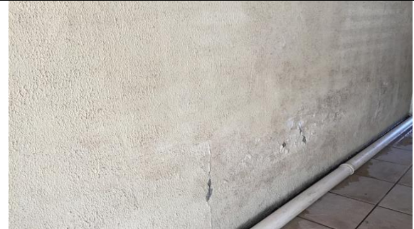
Figura 46 Detalhe da parede
