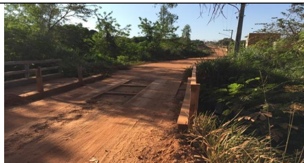
Figura 171 Vista geral da ponte de madeira de 6,0 metros
