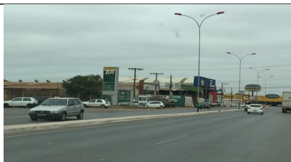
Figura 221 Vista geral da iluminação pública
