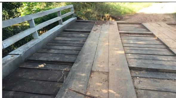
Figura 167 detalhe do assoalho e rodeiro
