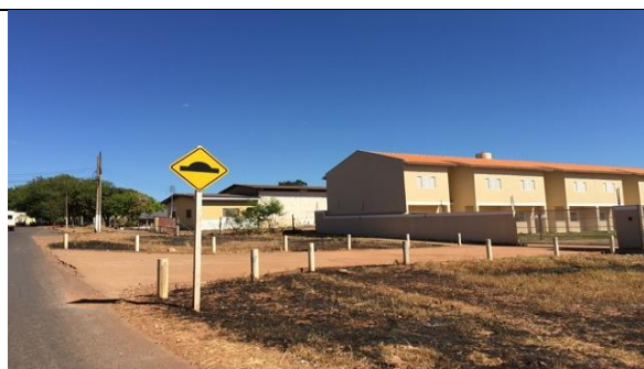
Figura 165 Detalhe da sinalização vertical
