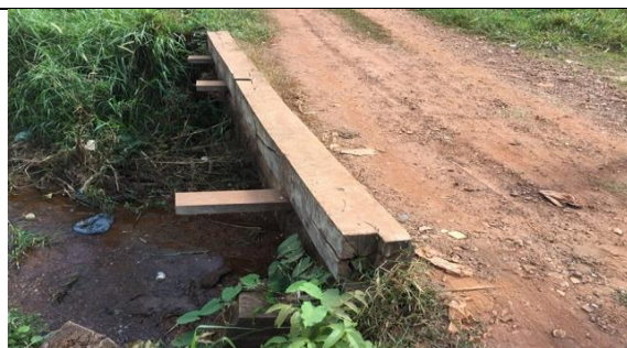
Figura 209 Vista geral da ponte
