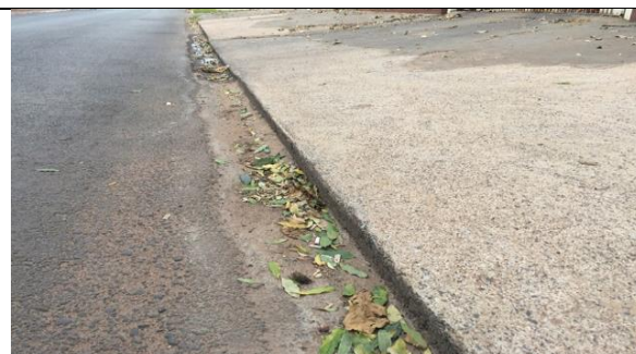
Figura 228 Detalhe da calçada
