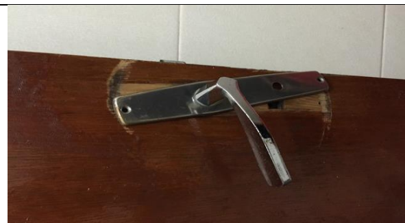
Figura 49 Detalhe da fechadura
