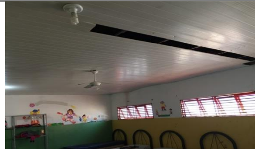
Figura 24 Detalhe do forro de PVC
