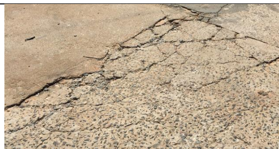
Figura 200 Detalhe da calçada
