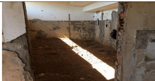
Figura 91 Banheiro onde foram retirados os aparelhos sanitários
