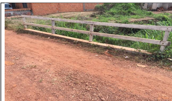
Figura 201 Vista geral da ponte de madeira
