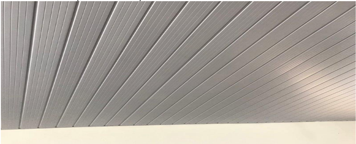
Telhado reformado (Sala do Pré II A)
