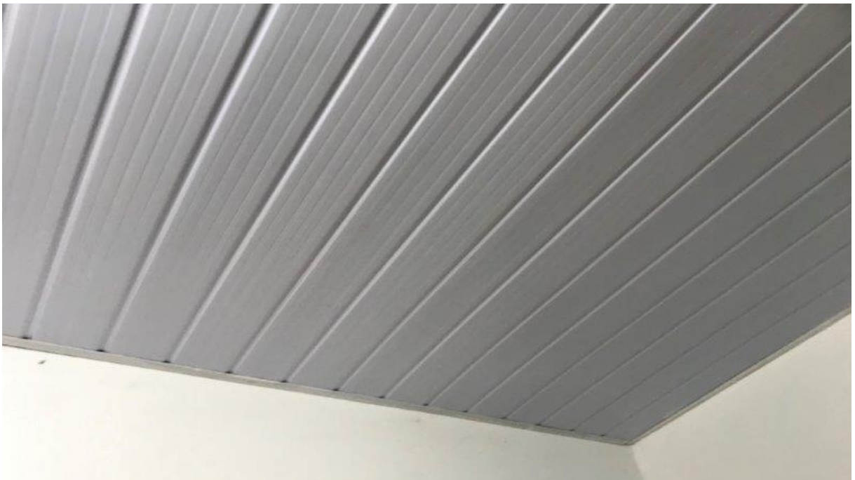
Forro trocado (sala do Pré I B)
