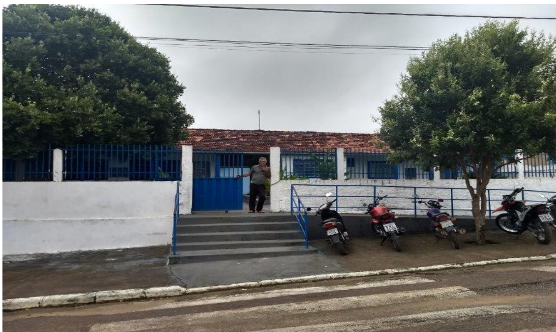
Foto 65: Faixa de pedestre em frente à escola.
