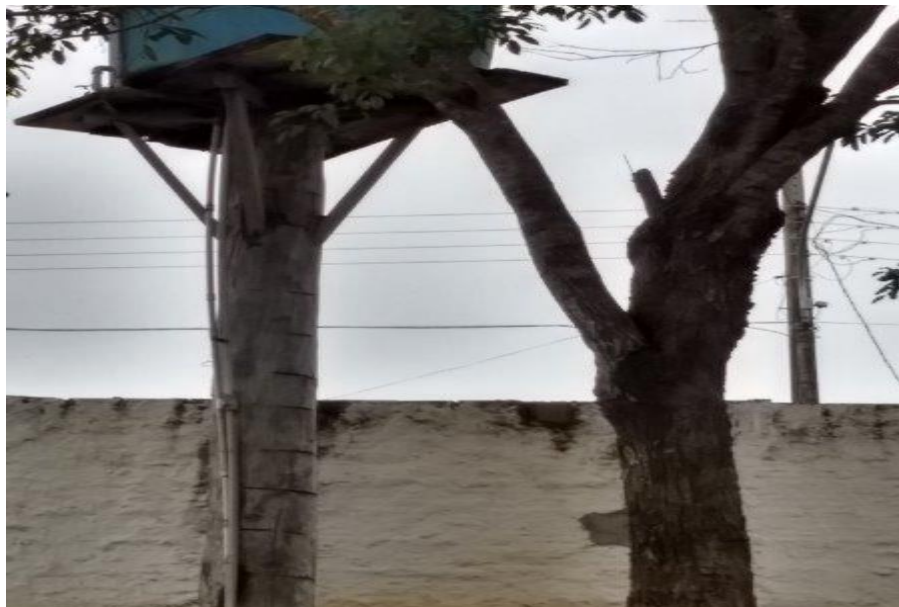
Foto 63: Estrutura da caixa d'água.
