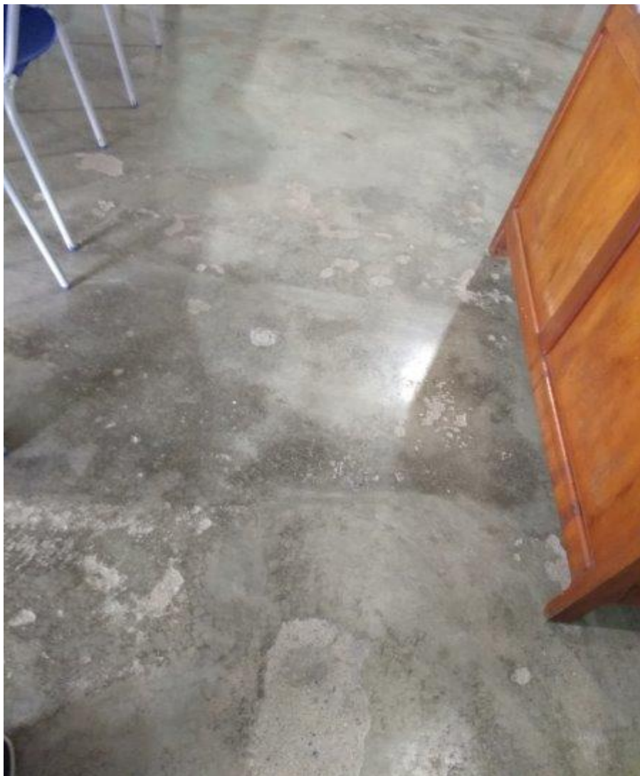
Foto 6: Piso da sala de aula.
