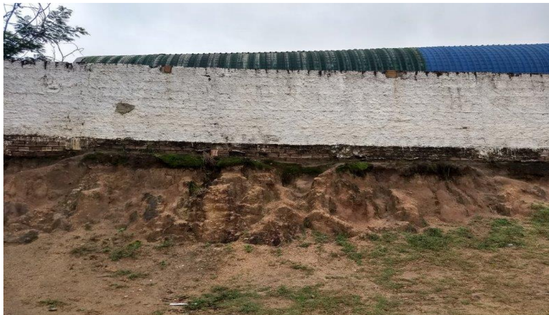
Foto 18: Muro da escola.
