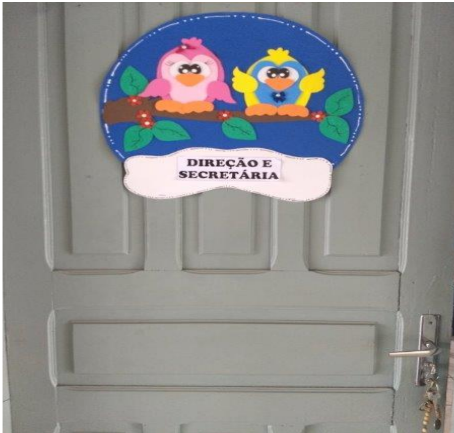
Foto 13: Porta funcionando normalmente.
