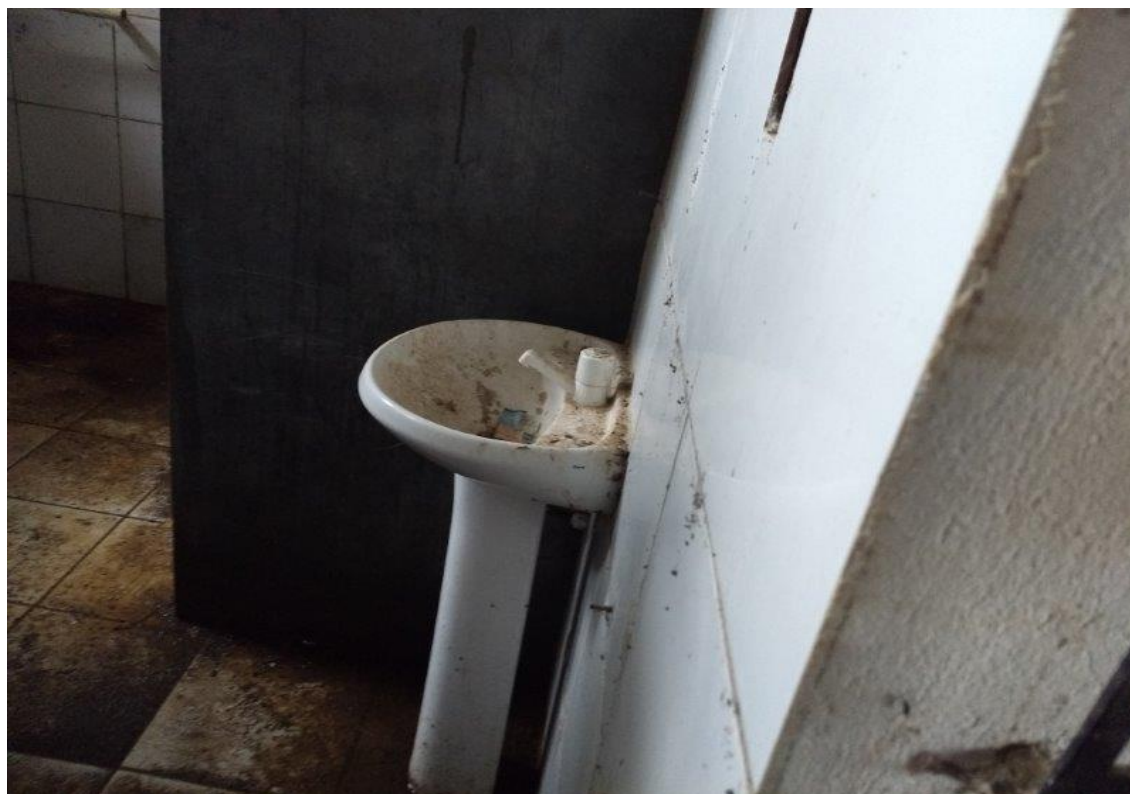
Foto 28: sanitários do ginásio de esportes.
