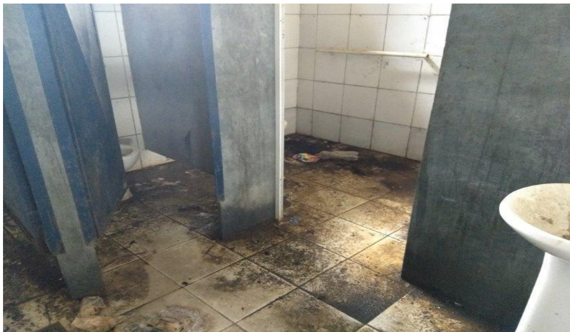
Foto 27: sanitários do ginásio de esportes.
