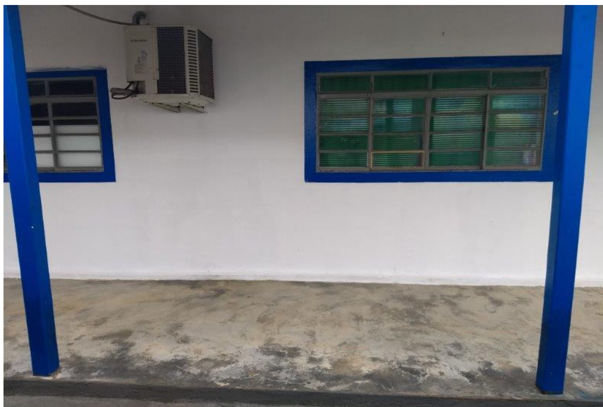
Foto 7: parede externa da escola.
