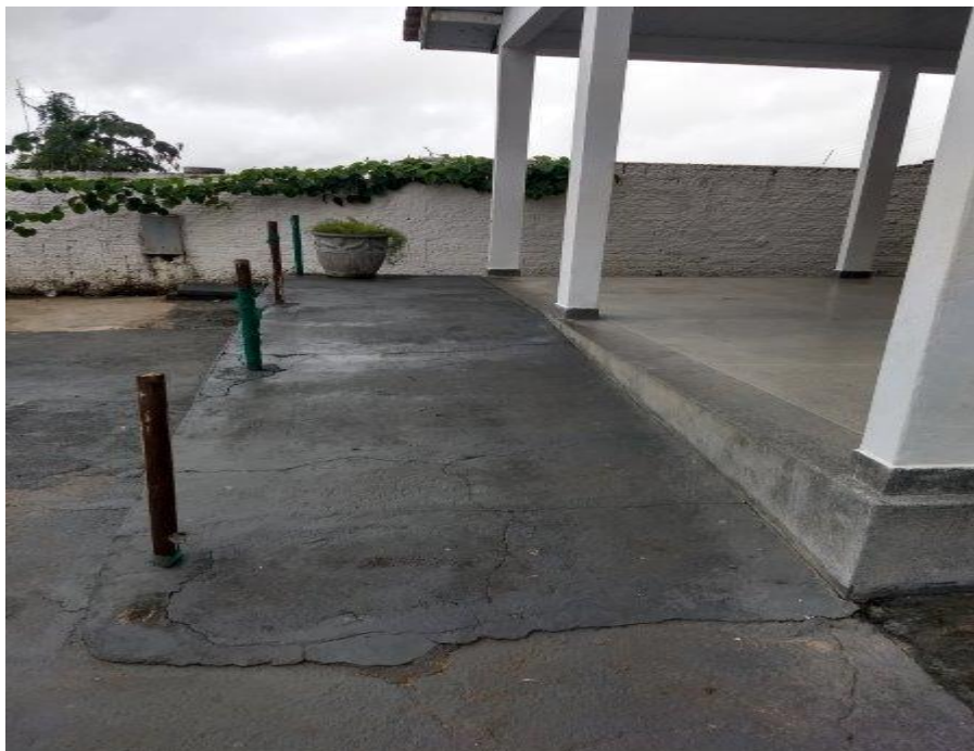
Foto 60: Rampa de acesso ao refeitório.
