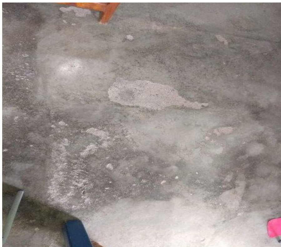
Foto 5: Piso da sala de aula.
