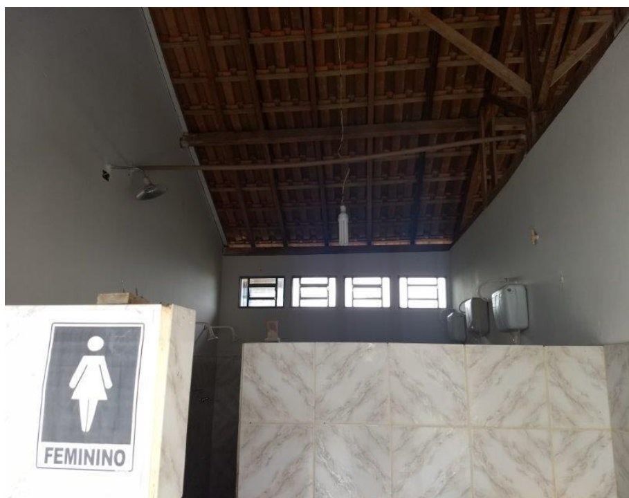
Foto 12: Janelas com vidros nos sanitários.
