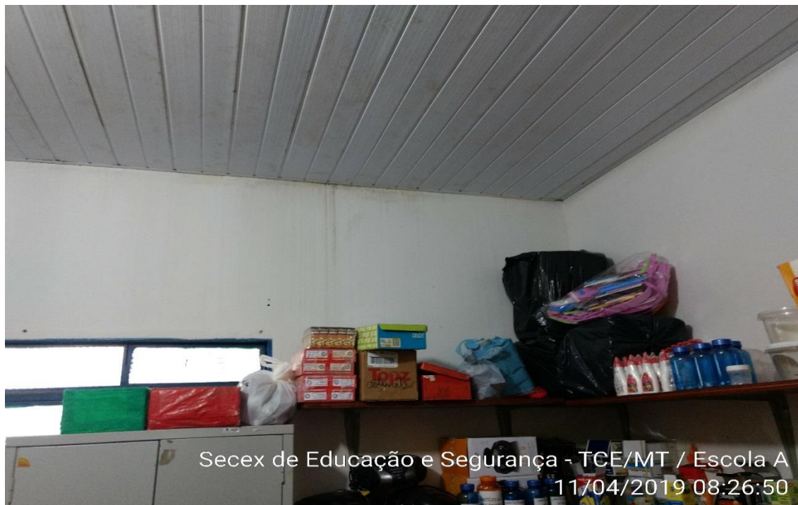
Foto 03: Forro do almoxarifado continua com goteiras.
