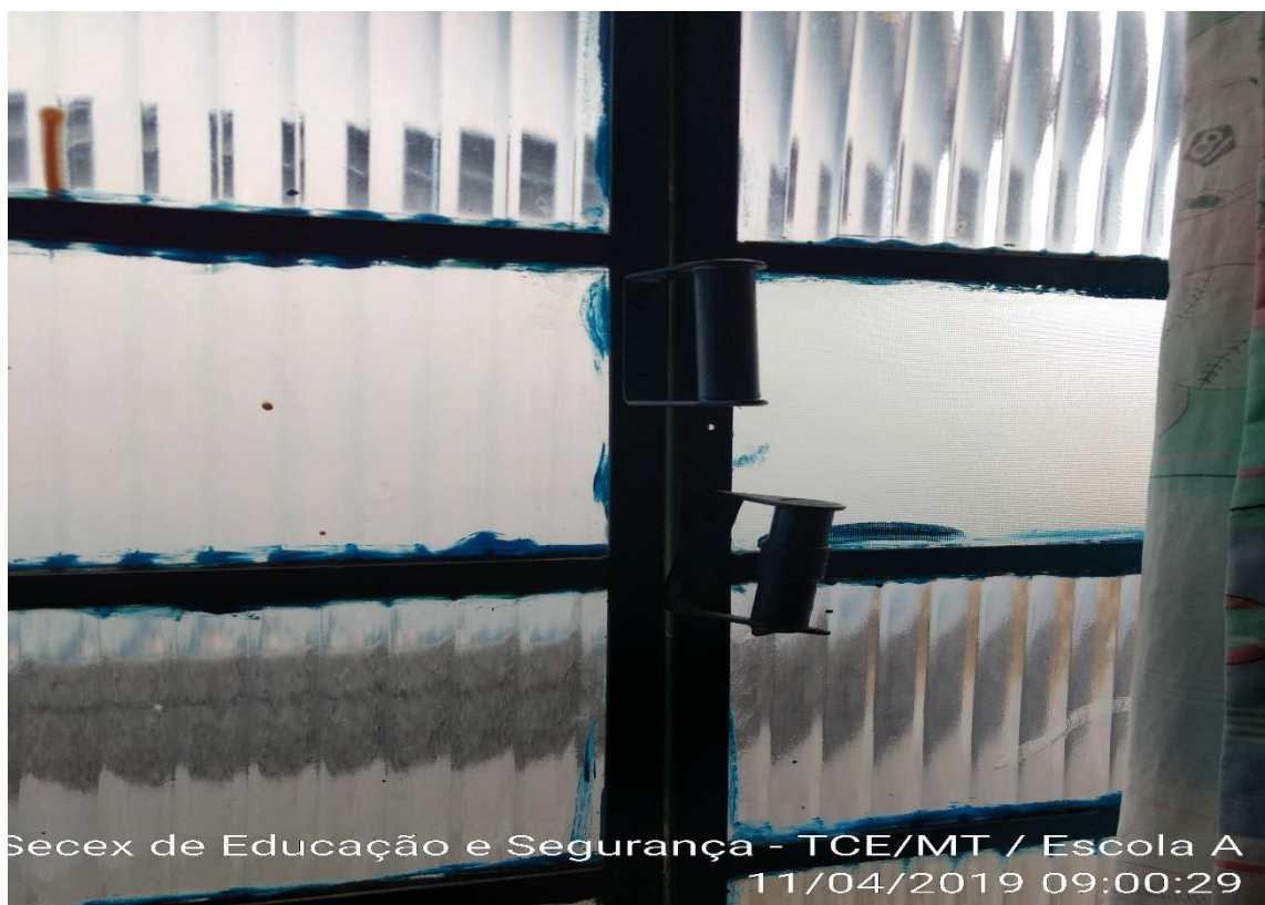
Foto 13: Janela com a fechadura danificada.
