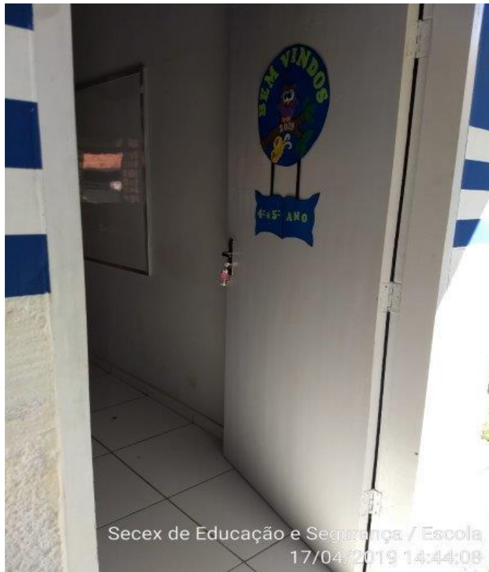
Foto 4: Porta da sala de aula.
