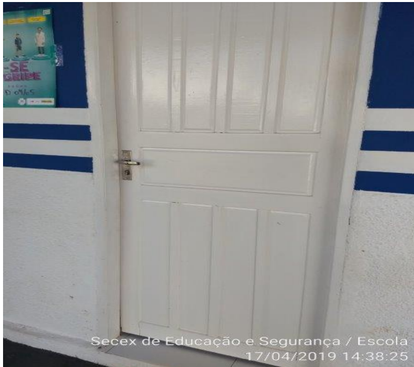
Foto 3: Porta da sala de aula.
