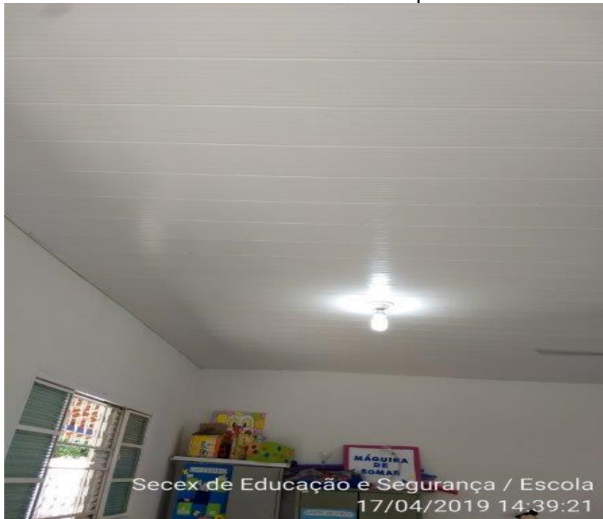
Foto 2: Forro da sala de aula foi trocado por forro de PVC.
