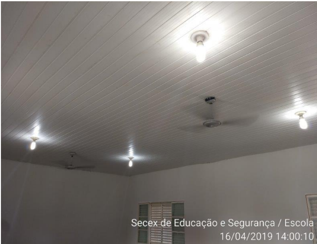
Foto 34: Sala de aula.
