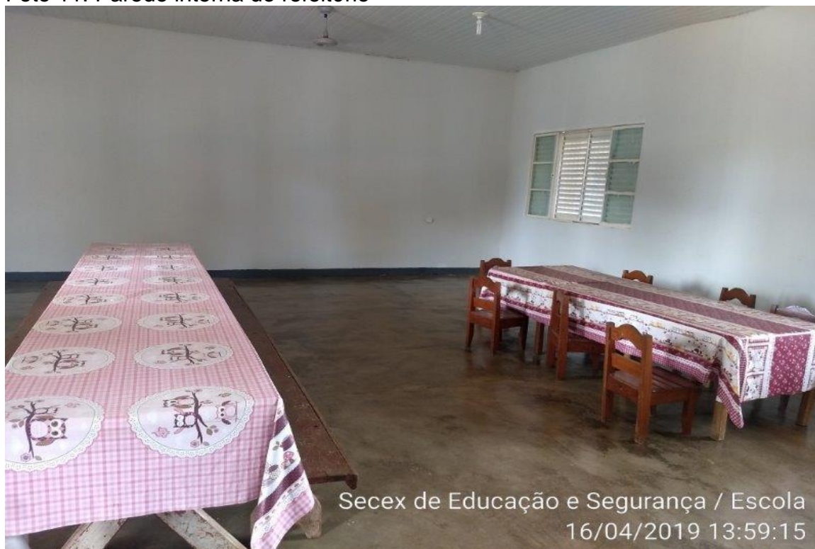
Foto 11: Parede interna do refeitório
