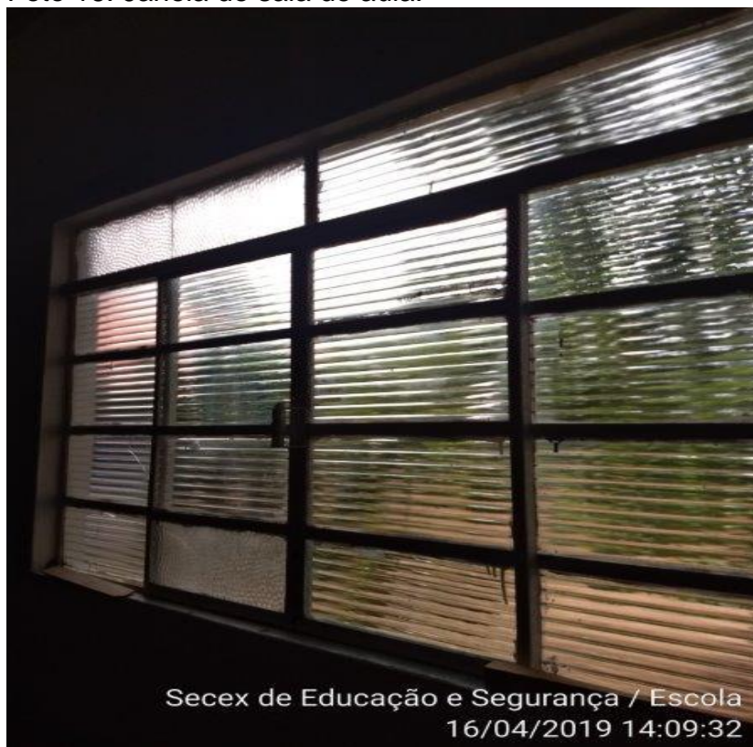
Foto 16: Janela de sala de aula.
