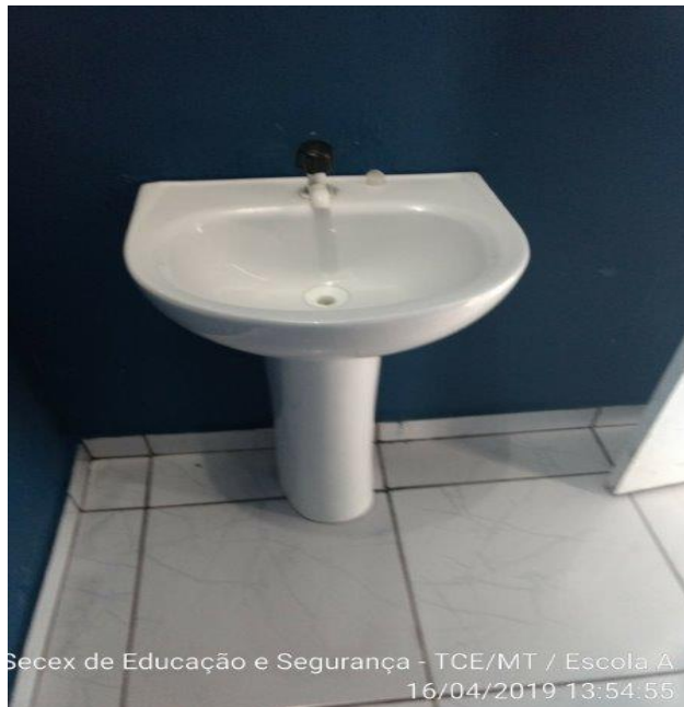
Foto 19: Pia do banheiro masculino.
