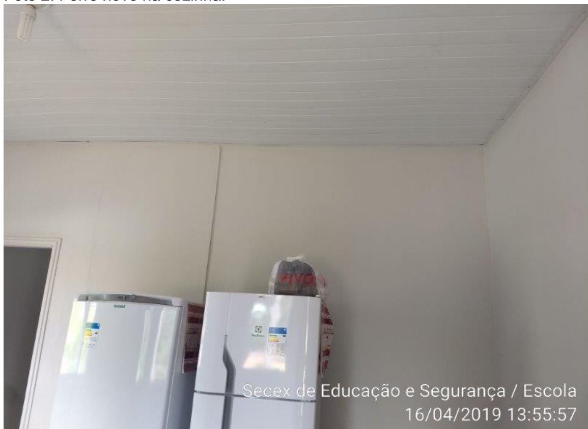
Foto 2: Forro novo na cozinha.
