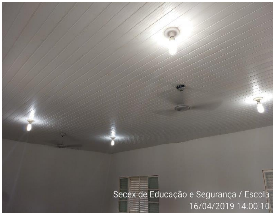
Foto 4: Forro da sala de aula.
