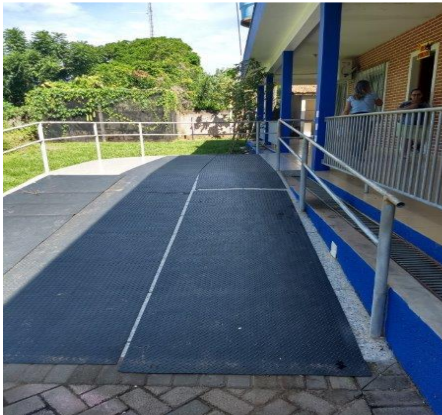
Foto 24: Rampa de acesso à escola.
