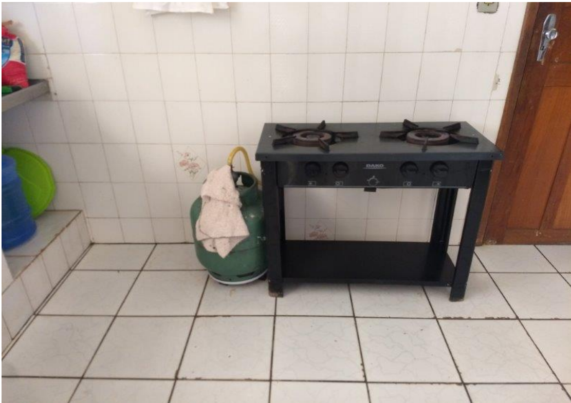
Foto 30: Botijão de gás dentro da cozinha.
