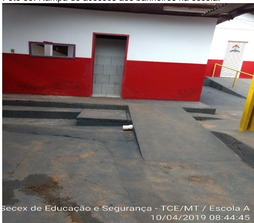
Foto 39: Rampa de acessos aos banheiros na escola.
