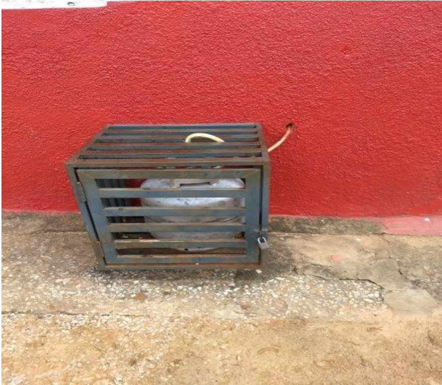
Foto 43: Botijão de gás instalado fora da cozinha.
