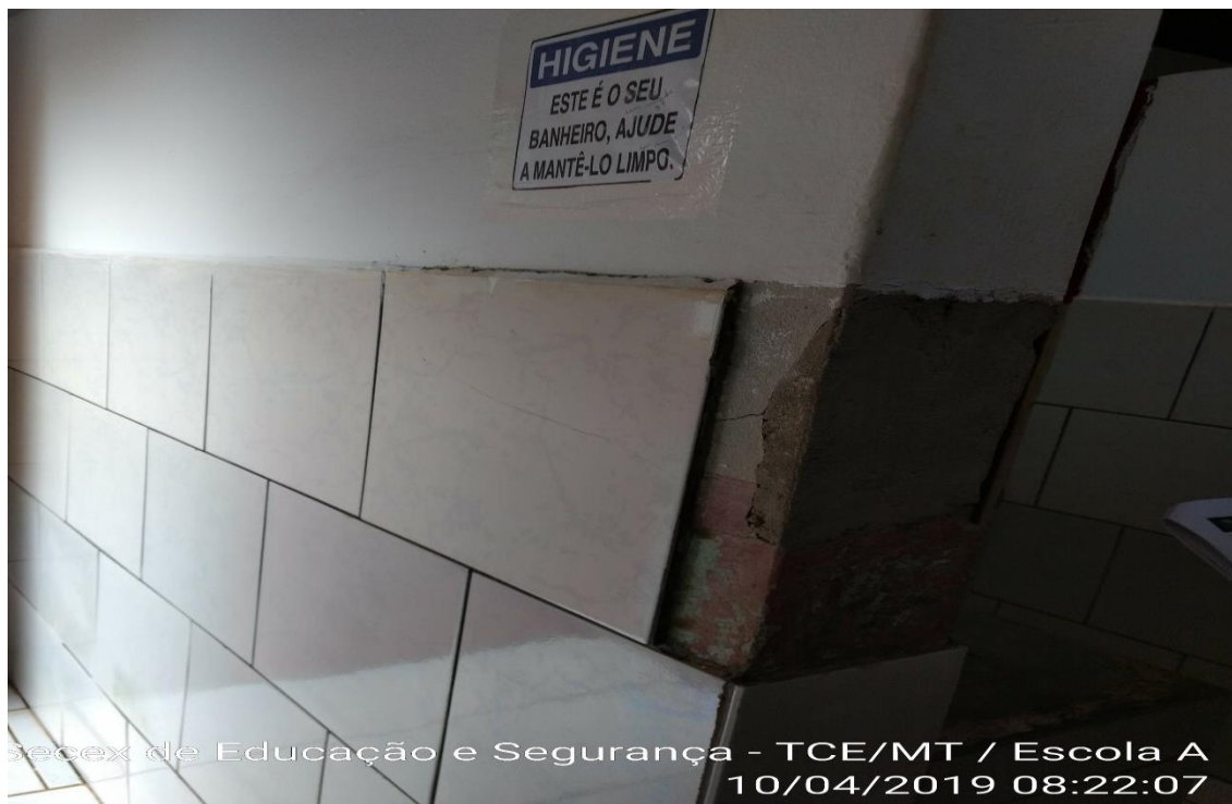
Foto 6: Azulejo faltando/trincado – sanitário masculino.
