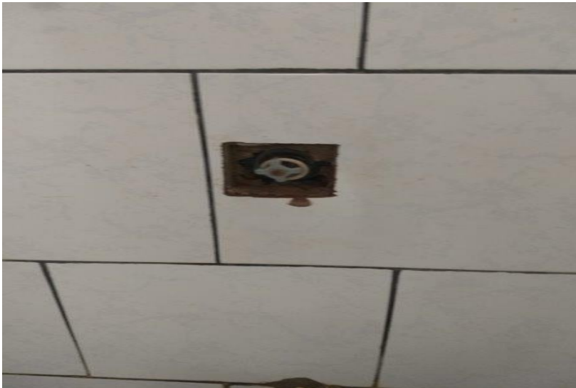
Foto 14: Acionador de descarga consertado - sanitário masculino.
