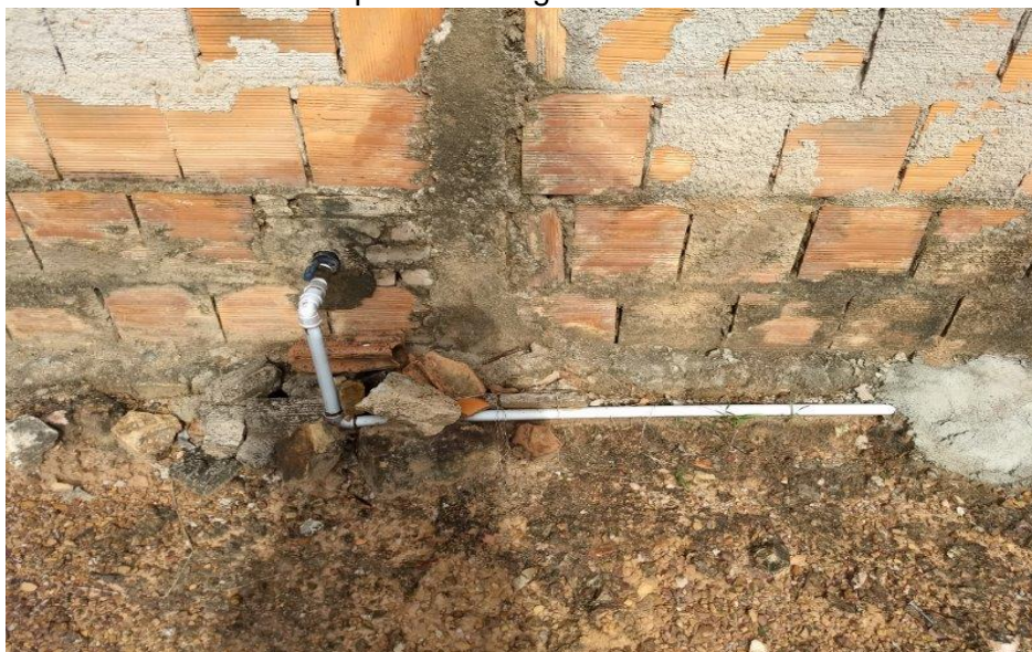
Foto 17: Encanamento que recebe água da rua consertado.
