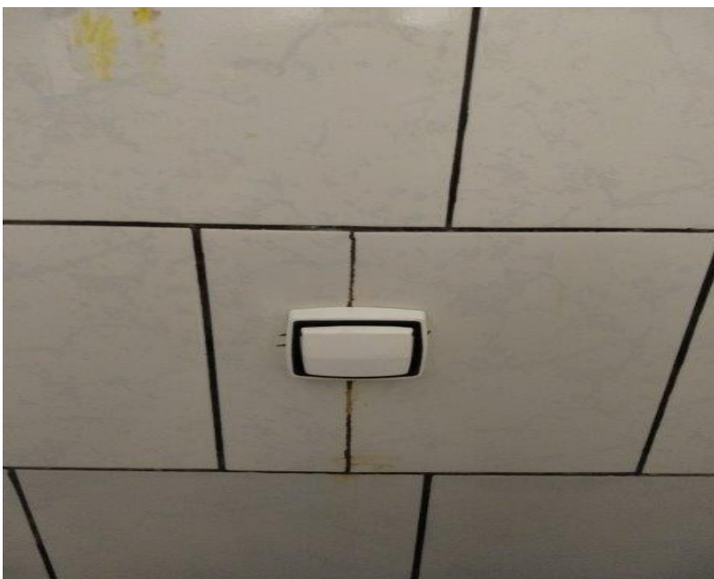
Foto 14: Acionador de descarga consertado - sanitário masculino.
