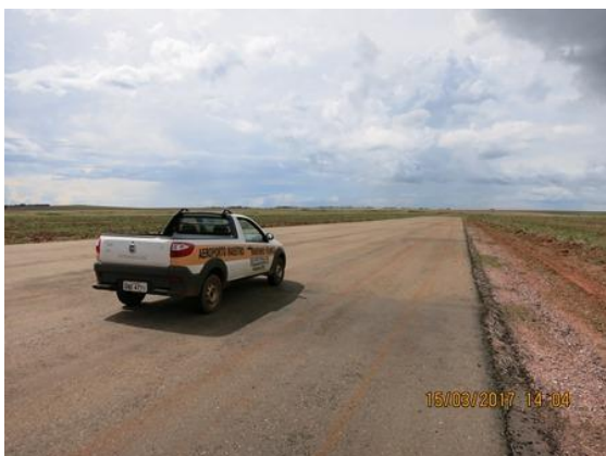
Foto 2: Pista de taxiamento do lado direito com sub base, base, imprimação e 1ª camada de CBUQ executados (faltando a 2ª e 3ª camadas).
