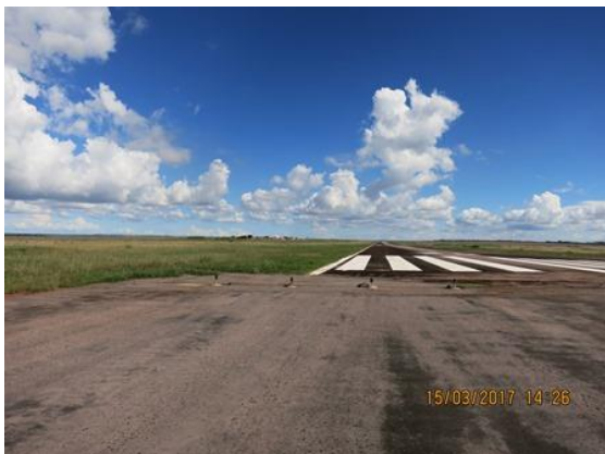
Foto 4: Ampliação da cabeceira da pista (lado direito), mostrando a pista antiga ao fundo a ser ampliada 7,50m de cada lado.
