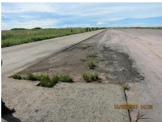
Foto 5: Ampliação da cabeceira da pista (lado direito), mostrando à esquerda trecho com CBUQ e à direita trecho imprimado, e ao centro a presença de vegetação comprometendo a serviço já executado.
