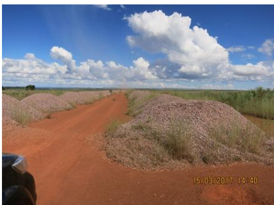
Foto 3: Brita estocada ao lado da pista de taxiamento do lado direito, setor Norte, com a sub base executada.
