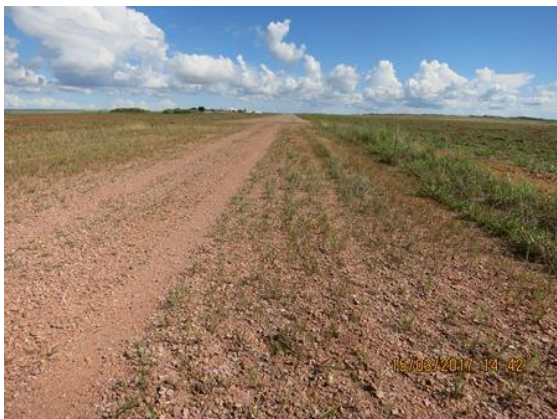
Foto 1: Pista de taxiamento do lado direito, setor Norte, com sub base e base executados, faltando imprimação e CBUQ.
