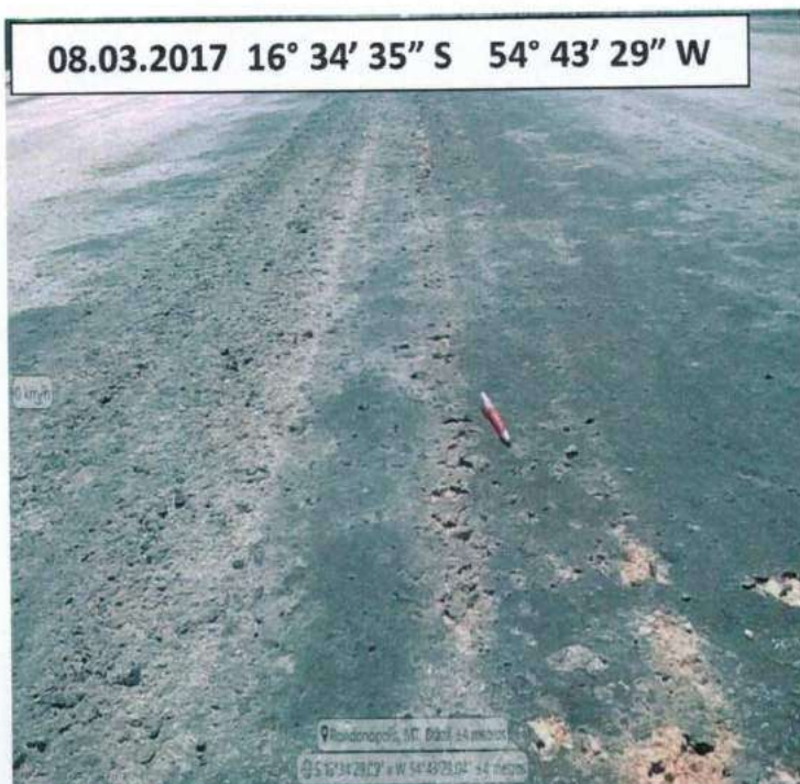
FOTO 47: BASE BGS DEGRADADA PELA PERCOLAÇÃO DE ÁGUA.
