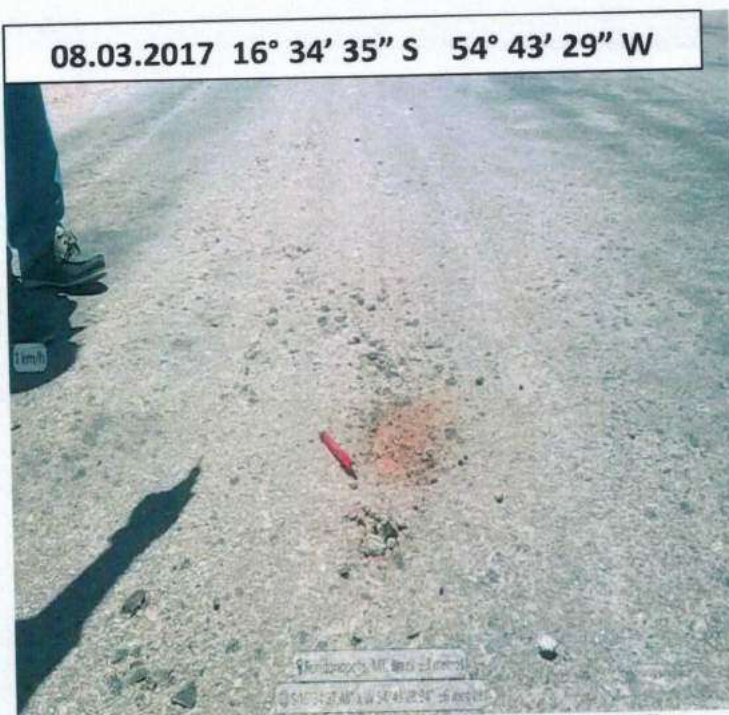
FOTO 44: BASE BGS COM PONTO DE DEGRADAÇÃO.
