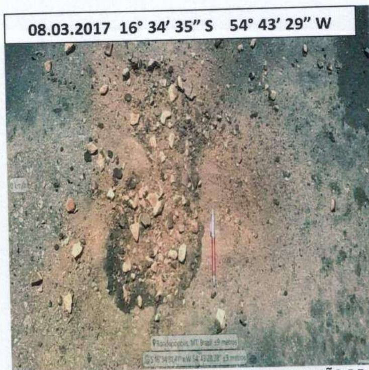
FOTO 46: BASE BGS DEGRADADA PELA PERCOLAÇÃO DE ÁGUA.
