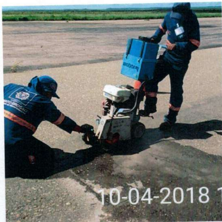
FOTO 1: EXECUÇÃO DE JANELA DE INSPEÇÃO NO PÁTIO DE AERONAVES
