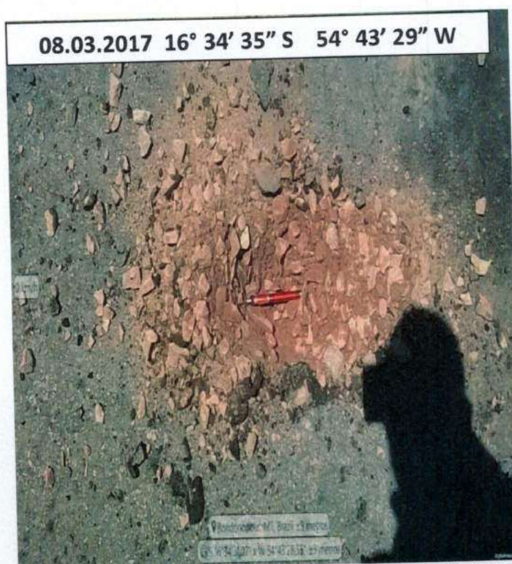
FOTO 45: BASE BGS DEGRADADA PELA PERCOLAÇÃO DE ÁGUA, SENSIBILIZANDO A ESTRUTURA DO MATERIAL.
