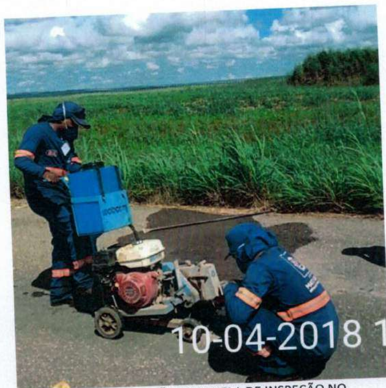
FOTO 3: EXECUÇÃO DE JANELA DE INSPEÇÃO NO PROLONGAMENTO DA PISTA DE POUSO E DECOLAGEM
