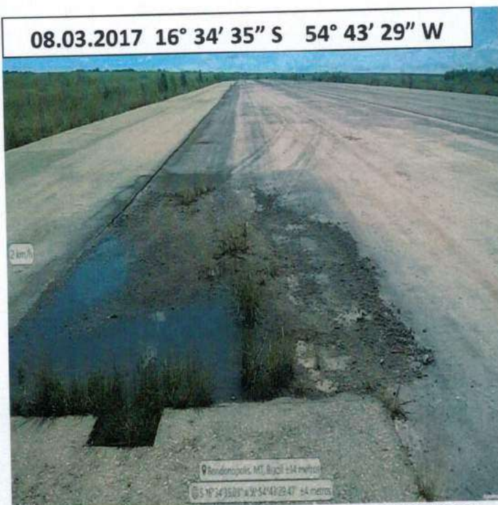
FOTO 49: BASE BGS DEGRADADA PELO ACUMULO DE ÁGUA.
