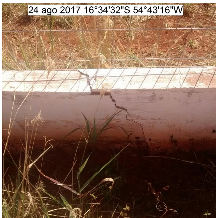
FOTO 5: MURETA DO ALAMBRADO QUEBRADA
