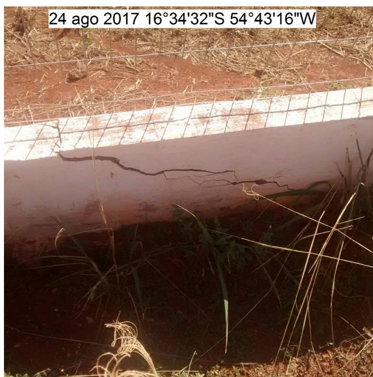
FOTO 6: MURETA DO ALAMBRADO QUEBRADA
