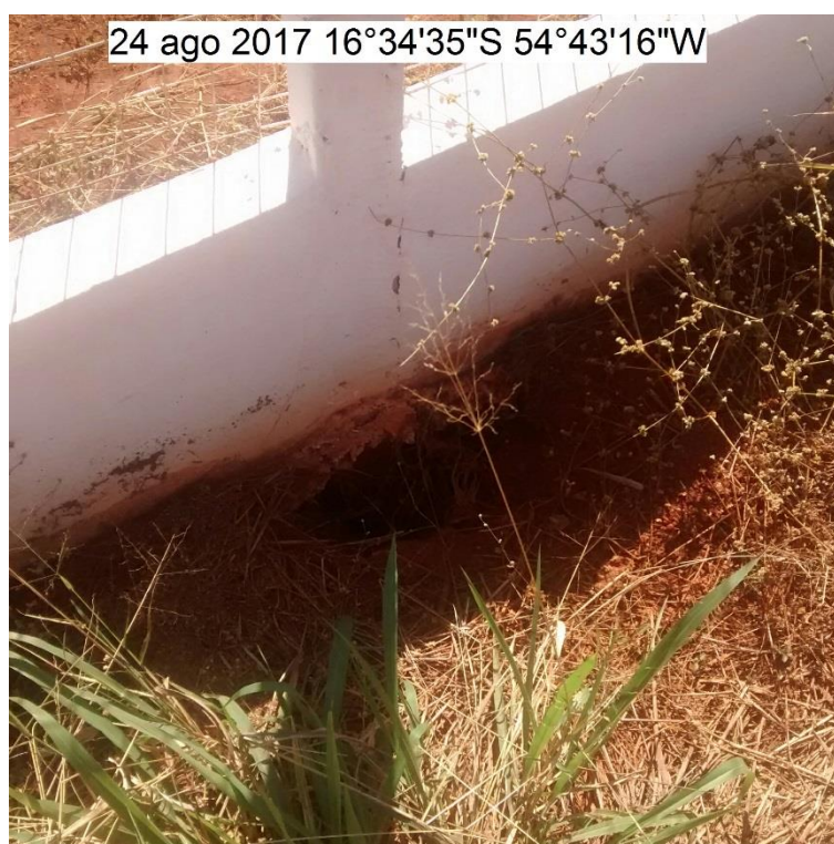
FOTO 22: RACHADURAS NA MURETA E EROSÃO NA BASE DO POSTE
