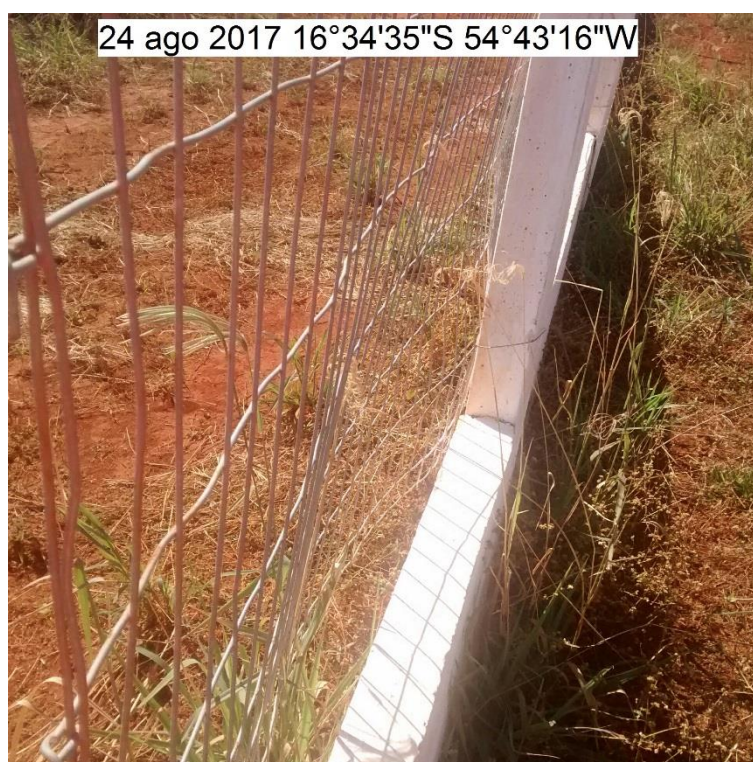
FOTO 24: ALAMBRADO CORTADO E EMENDADO
