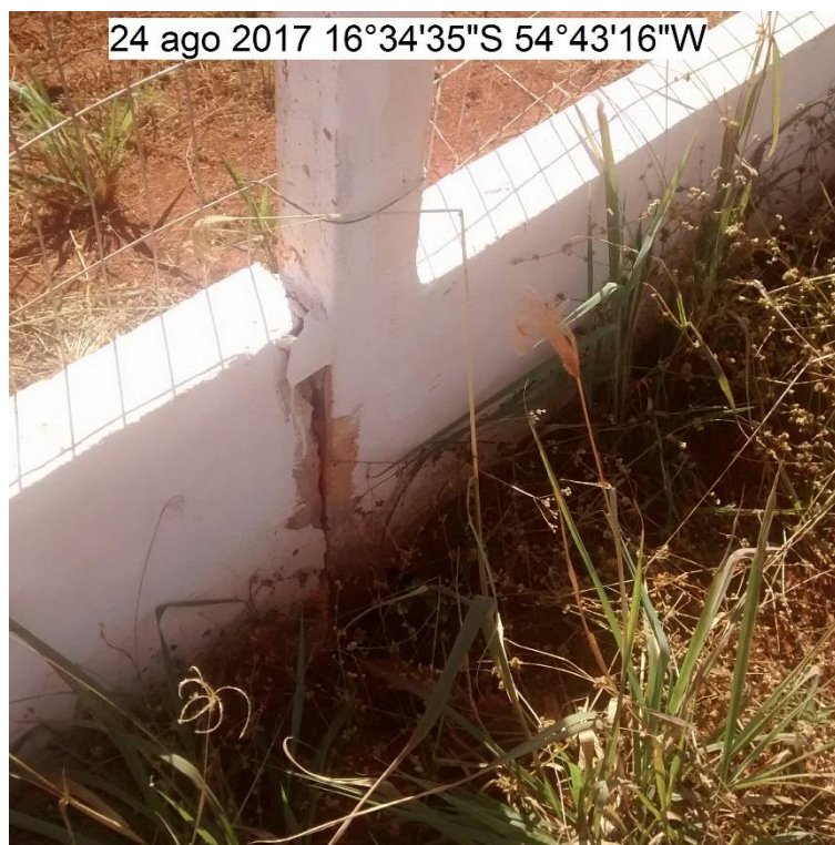
FOTO 23: RACHADURAS NA MURETA E EROSÃO NA BASE DO POSTE
