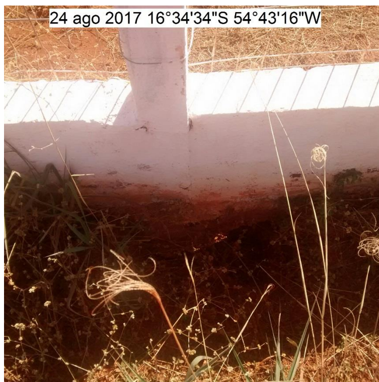
FOTO 16: EROSÃO POR BAIXO DA MURETA DO ALAMBRADO
