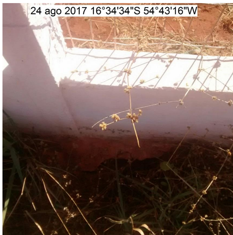
FOTO 17: EROSÃO NA BASE DO POSTE DO ALAMBRADO
