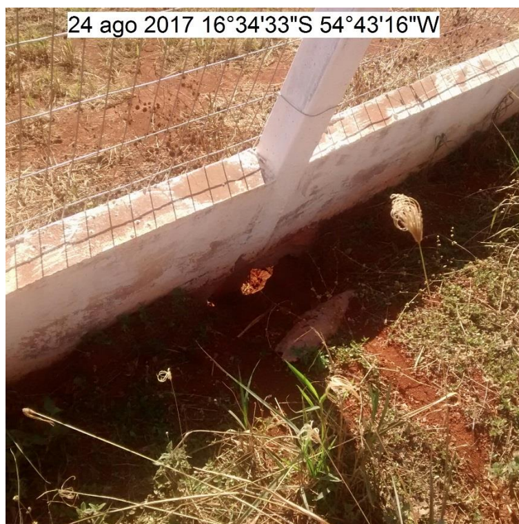
FOTO 8: RACHADURAS NA MURETA E EROSIÃO NA BASE DO POSTE
