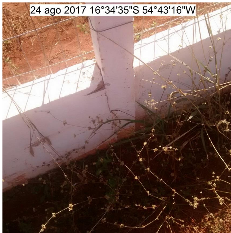
FOTO 19: RACHADURAS NA MURETA E EROSÃO NA BASE DO POSTE
