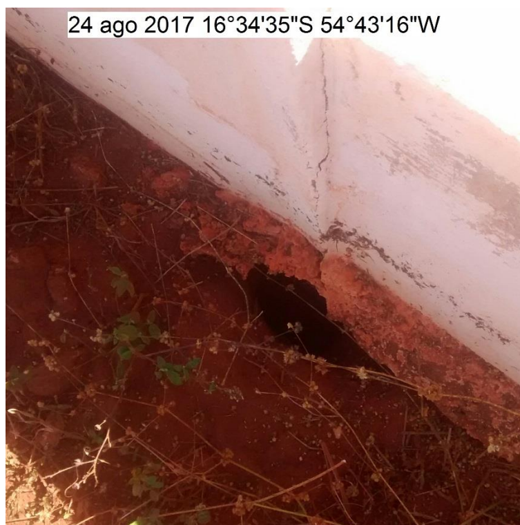
FOTO 20: RACHADURAS NA MURETA E EROSÃO NA BASE DO POSTE
