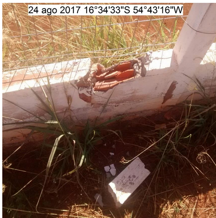
FOTO 11: MURETA DO ALAMBRADO QUEBRADA
