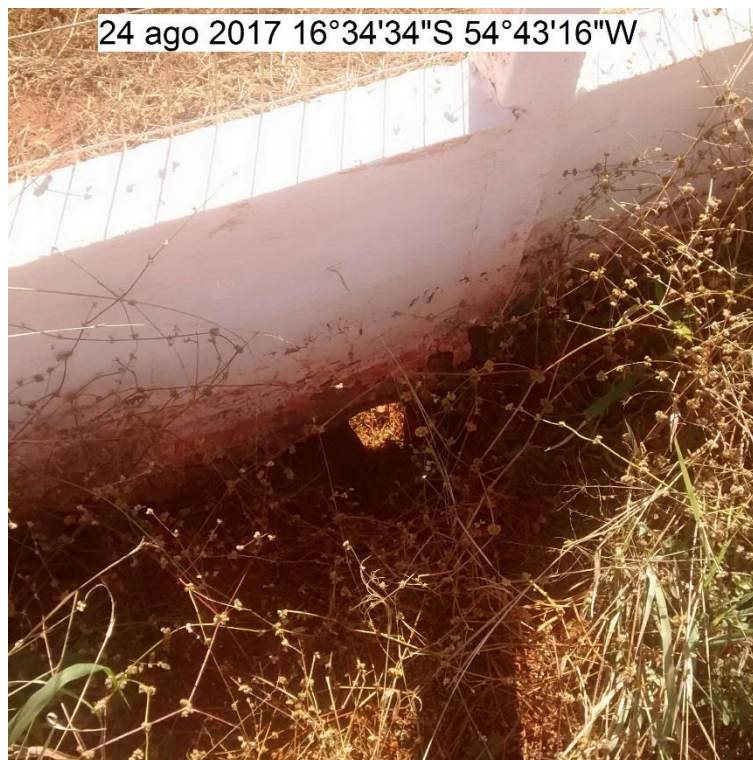
FOTO 15: EROSÃO POR BAIXO DA MURETA DO ALAMBRADO
