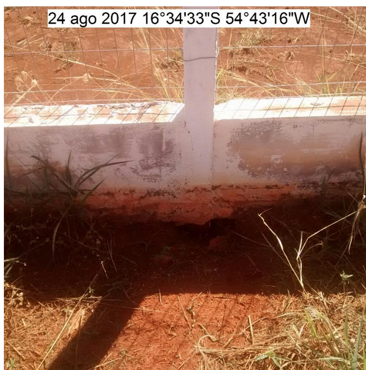
FOTO 12: RACHADURAS NA MURETA E EROSÃO NA BASE DO POSTE
