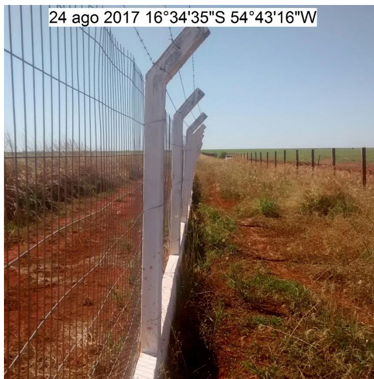
FOTO 25: ALAMBRADO TORTO POR CAUSA DAS EROSÕES NAS BASES DOS POSTES
