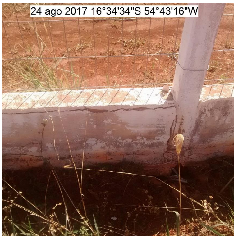
FOTO 14: RACHADURAS NA MURETA E EROSÃO NA BASE DO POSTE
