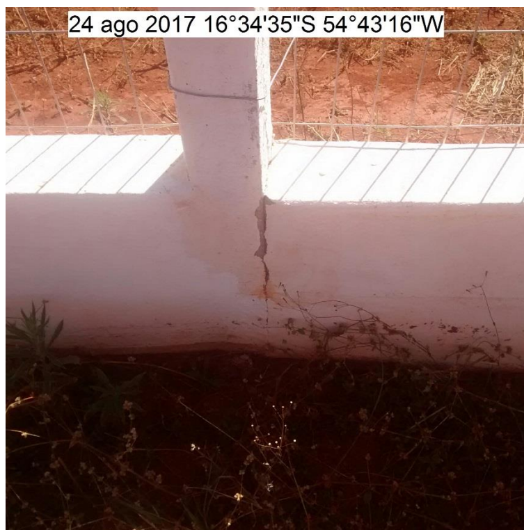
FOTO 21: RACHADURAS NA MURETA E EROSÃO NA BASE DO POSTE
