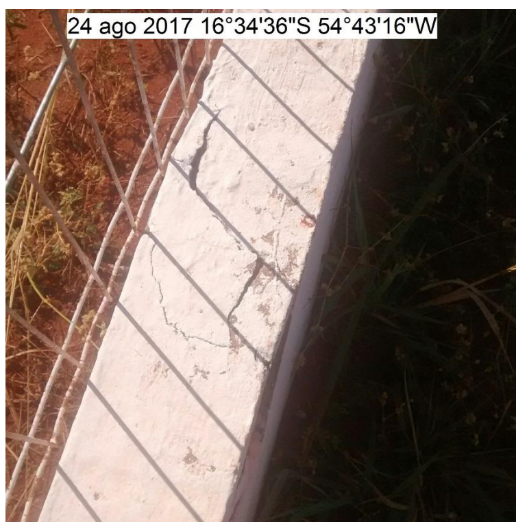
FOTO 26: MURETA DO ALAMBRADO QUEBRADA
