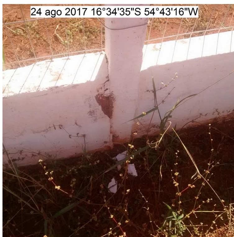
FOTO 18: RACHADURAS NA MURETA E EROSÃO NA BASE DO POSTE
