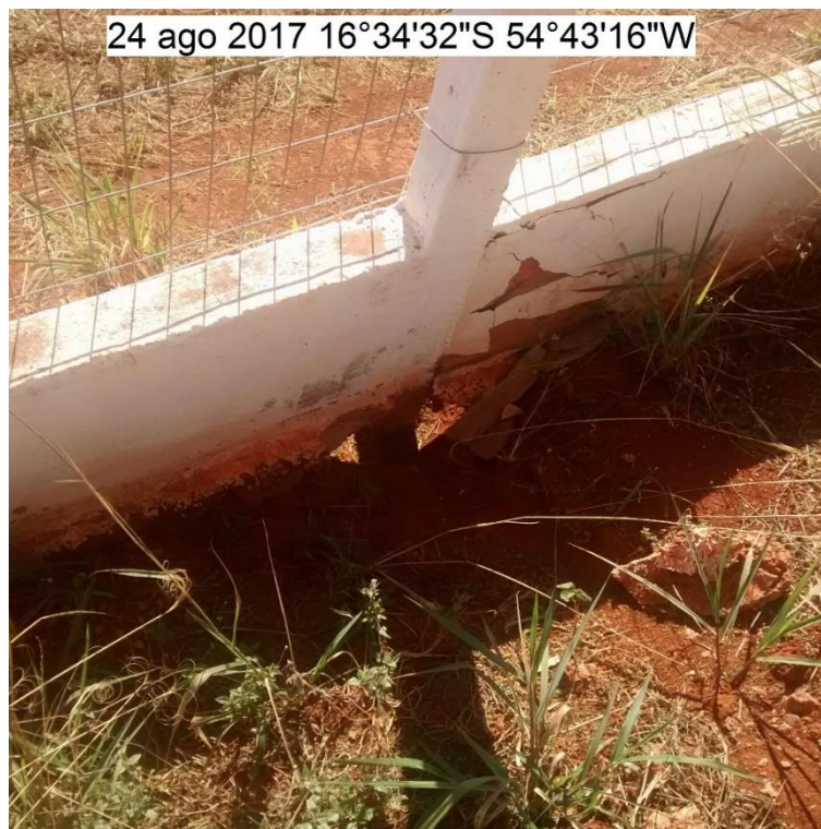
FOTO 7: RACHADURAS NA MURETA E EROSIÃO NA BASE DO POSTE
