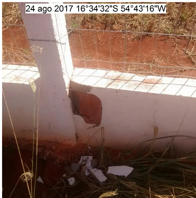
FOTO 3: MURETA DO ALAMBRADO QUEBRADA
