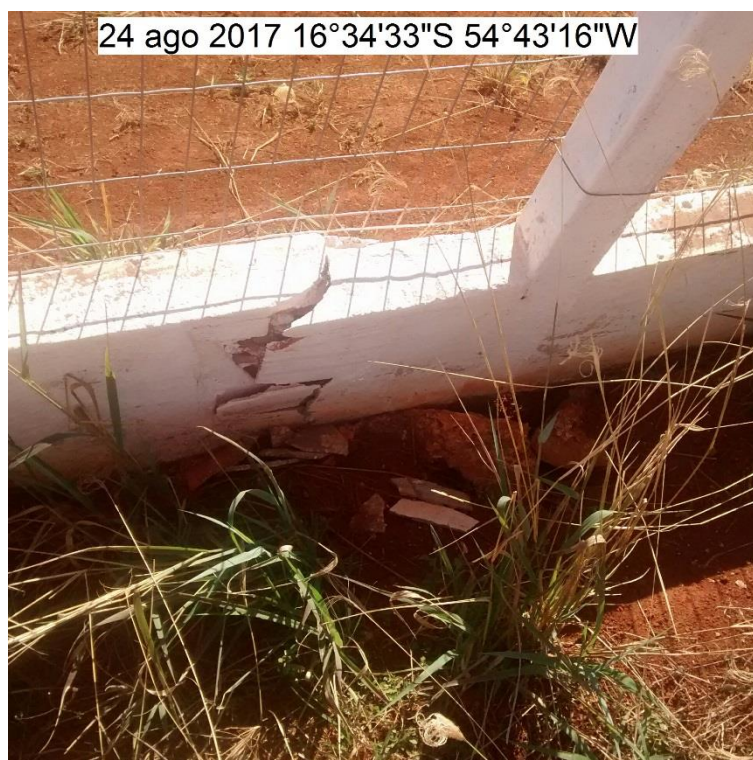
FOTO 10: RACHADURAS NA MURETA E EROSÃO NA BASE DO POSTE
