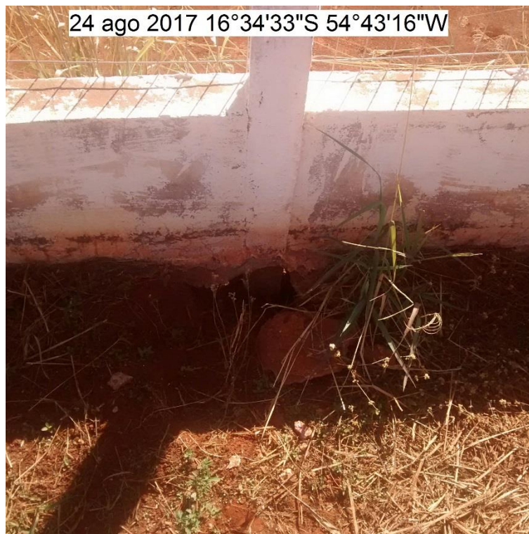
FOTO 13: RACHADURAS NA MURETA E EROSÃO NA BASE DO POSTE
