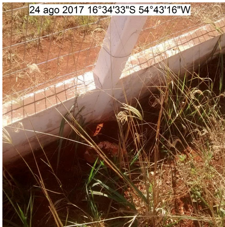
FOTO 9: RACHADURAS NA MURETA E EROSÃO NA BASE DO POSTE
