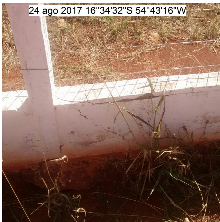
FOTO 4: MURETA TRINCADA E EROSÃO NA BASE DO POSTE
