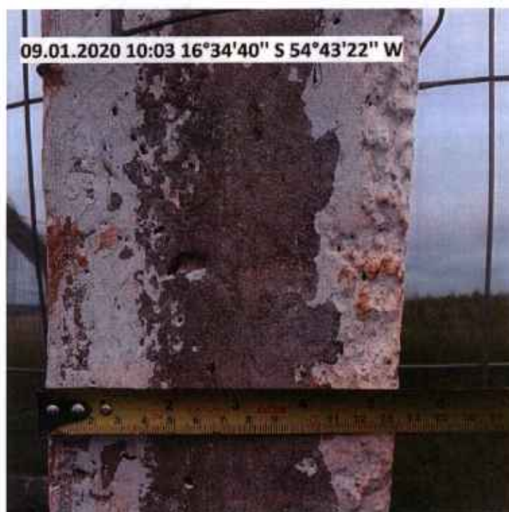
FOTO 24: ESPESSURA DO PILAR
