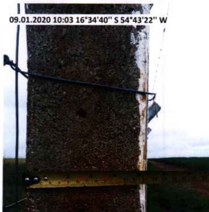
FOTO 25: ESPESSURA DO PILAR
