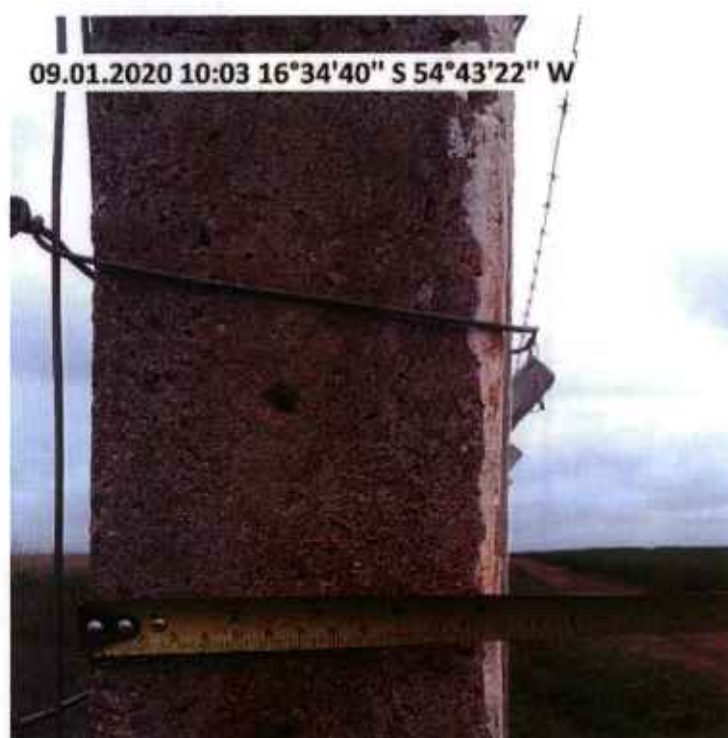
FOTO 23: ESPESSURA DO PILAR
