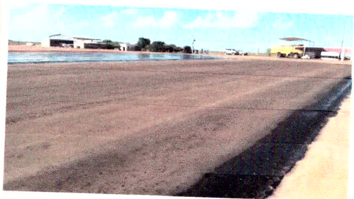
Execução de Imprimação
