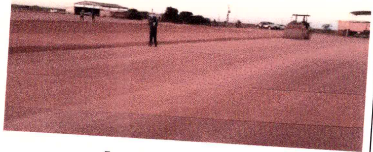
Execução de B.G.S.
