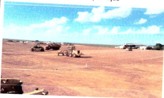
Execução de Base de B.G.S e imprimação
