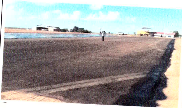
Execução de Imprimação
