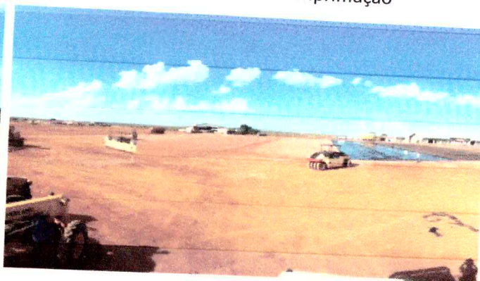
Execução de Base de B.G.S e imprimação
