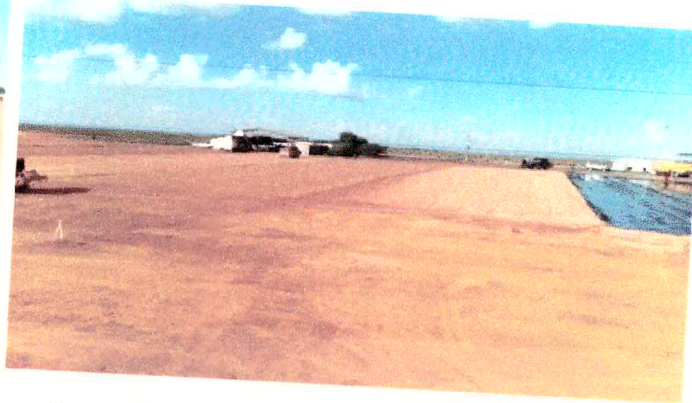
Execução de Base de B.G.S e imprimação
