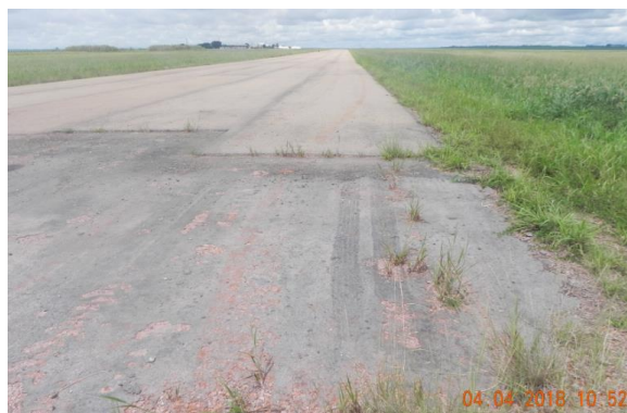
Pista de taxi parcialmente executada (752m x 19m)
