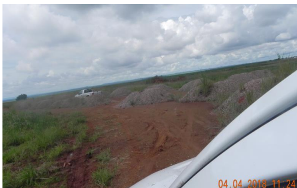
Trecho com material lançado na pista
