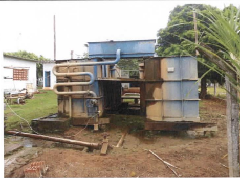
Ponto de aplicação de sulfato de alumínio na adutora de água bruta
