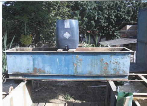
Vista externa da caixa de chegada de água bruta e internamente possui 2 vertedores.
