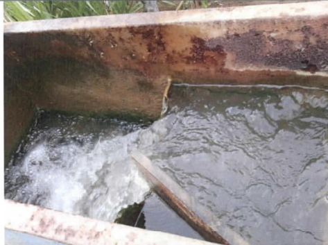
Ponto de aplicação de sulfato de alumínio na adutora de água bruta
