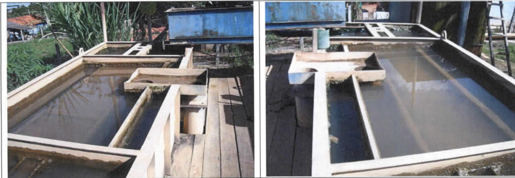
Vista parcial externa dos decantadores e ao fundo os floculadores sem a presença dos motores e paletas de floculação .
