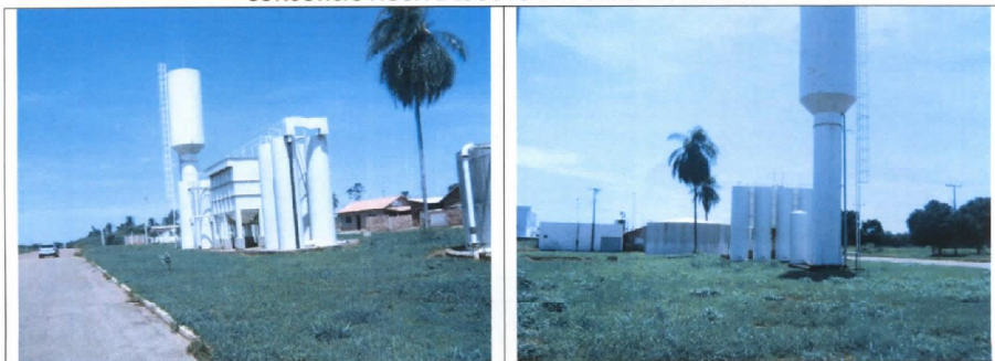
Foto do Reservatório Elevado Metálico 50m 3
