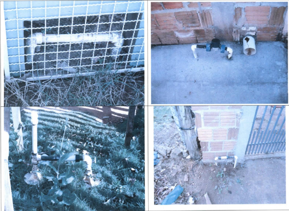
Ligações domiciliares com e sem hidrômetro.
