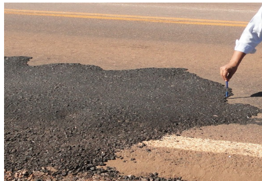
Foto 5: Remendo inadequado.
