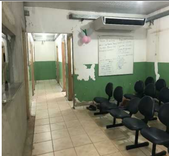
Foto 8 – Parede danificada e com infiltração
