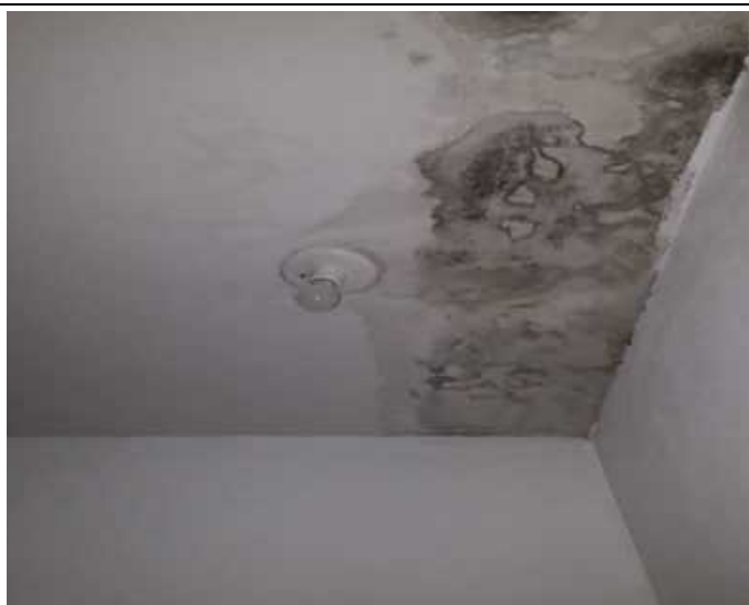
Foto 6 – Teto com infiltração
