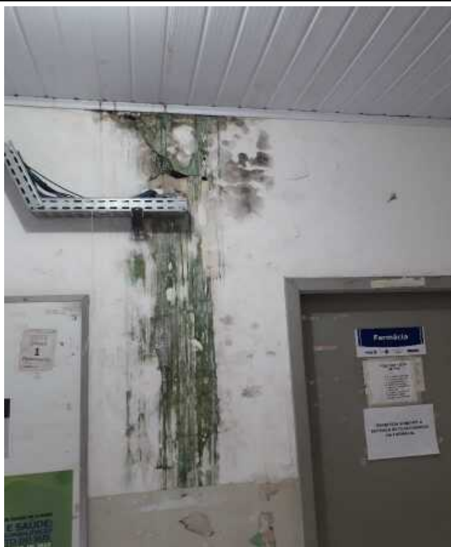
Foto 3 – Parede com infiltração e mofo
