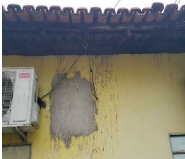
Foto 10 – Instalação de ar condicionado inadequada
