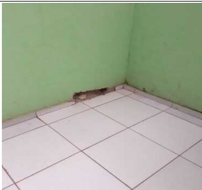
Foto 5 – Rodapé e parede danificados
