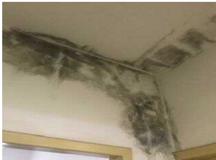
Foto 6 – Parede com infiltração
