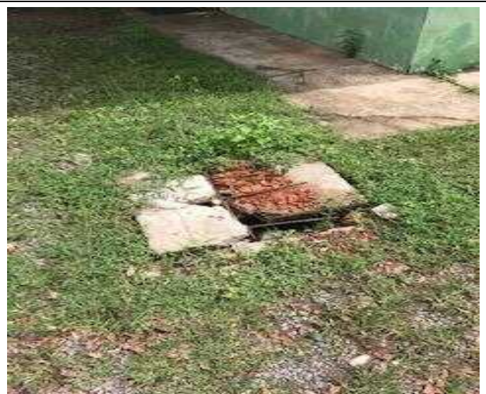
Foto 12 – Área externa com buraco sem tampa adequada na fossa
