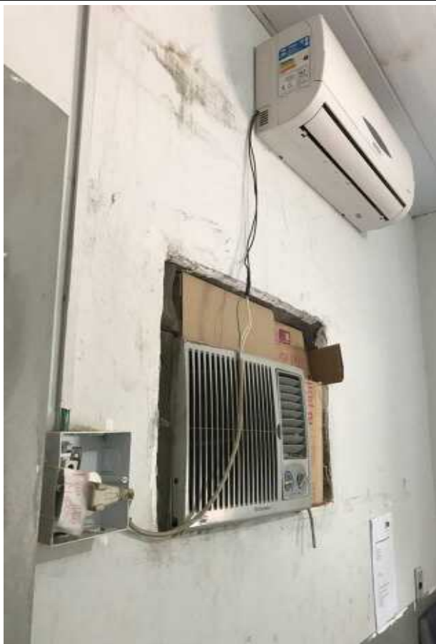
Foto 3 – Fiação exposta e infiltração
