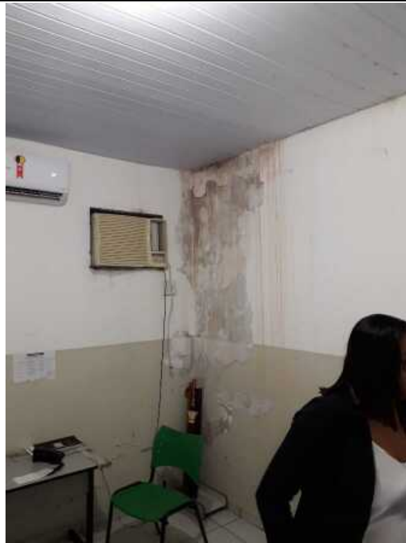
Foto 4 – Parede com infiltração
