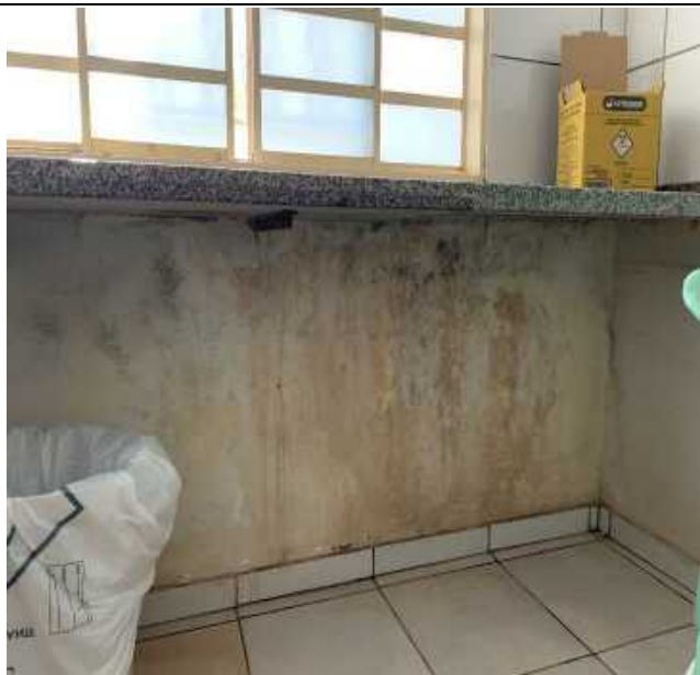
Foto 5 – Sala com infiltração
