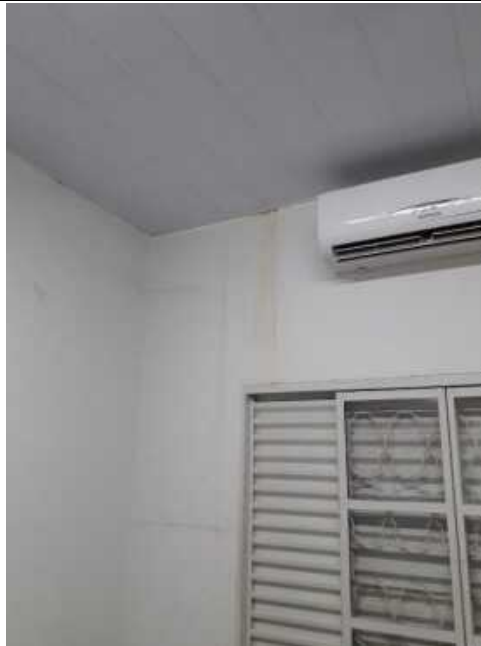
Foto 6 – Parede com infiltração de água da chuva
