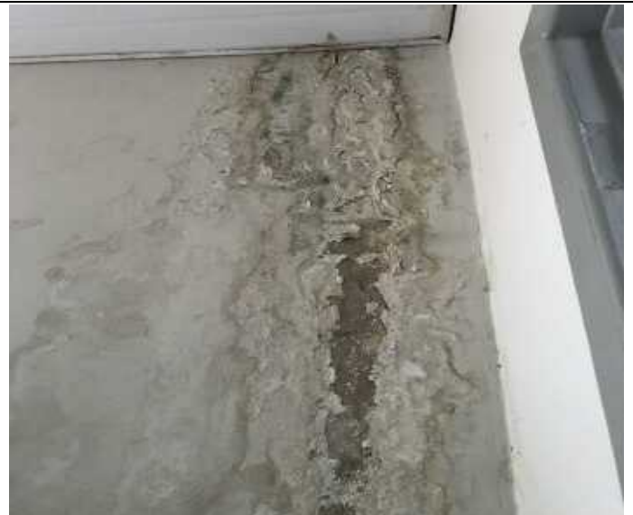
Foto 6 – Infiltração na parede
