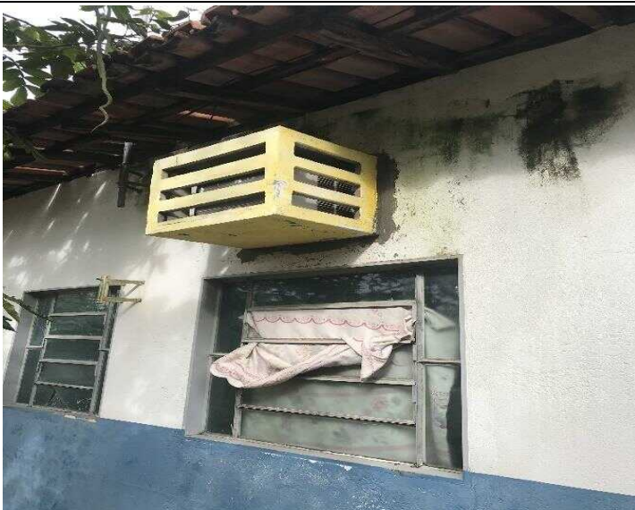
Foto 5 – Janela com vidro quebrado e parede danificada
