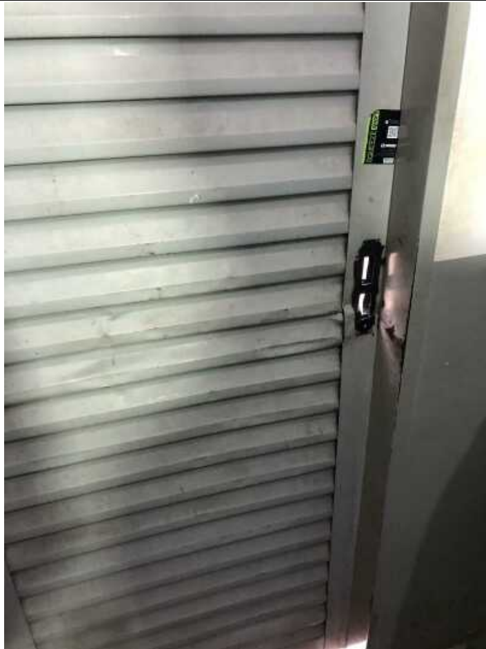
Foto 10 – Porta externa com fechadura arrombada
