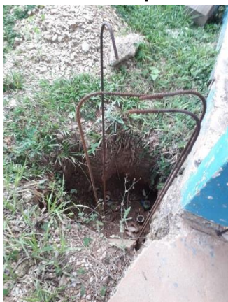
Foto 53 – Reforma inacabada, materiais de construção se deteriorando ao relento – PSF Ribeirão do Lipa
