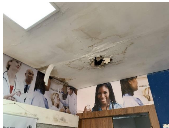
Foto 14 – infiltração e goteira na sala de espera – Clínica de Saúde da Família CPA I
