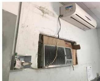
Foto 24 – Fiação exposta e infiltração – PSF Novo Mato Grosso
