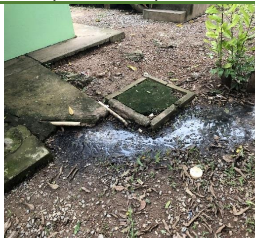
Foto 40 – Vazamento de esgoto perto da cozinha no pátio – PSF Despraiado I e II
