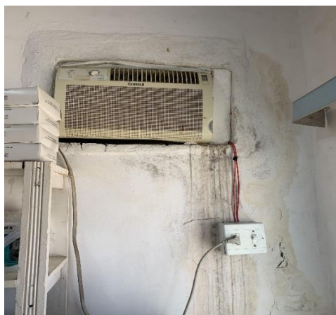
Foto 14 – infiltração e goteira na sala de espera – Clínica de Saúde da Família CPA I
