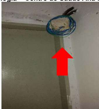
Foto 22 – Falta de lâmpada na sala de esterilização – Centro de Saúde Dom Aquino
