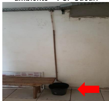
Foto 29 - Sala de espera - Balde que coleta água de ar condicionado de outro ambiente – PSF Sucuri
