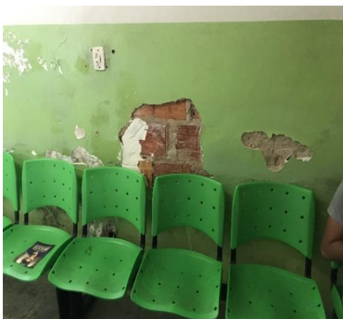
Foto 7 – Infiltração em parede – Centro de Saúde Grande Terceiro
