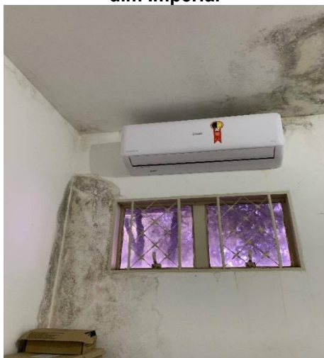
Foto 5 – Parede com reboco soltando – Centro de Saúde Grande Terceiro
