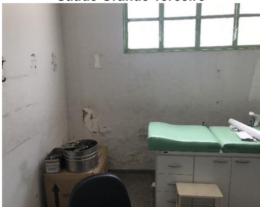
Foto 9 – Infiltração na sala de coleta e curativo – PSF Residencial Coxipó I e II
