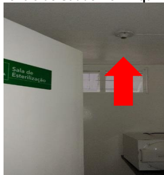
Foto 24 – Fiação exposta e infiltração – PSF Novo Mato Grosso
