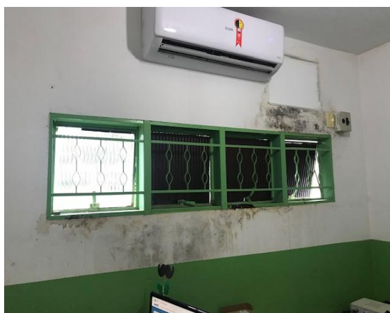
Foto 8 – Infiltração na sala de curativos – PSF Nova Esperança II
