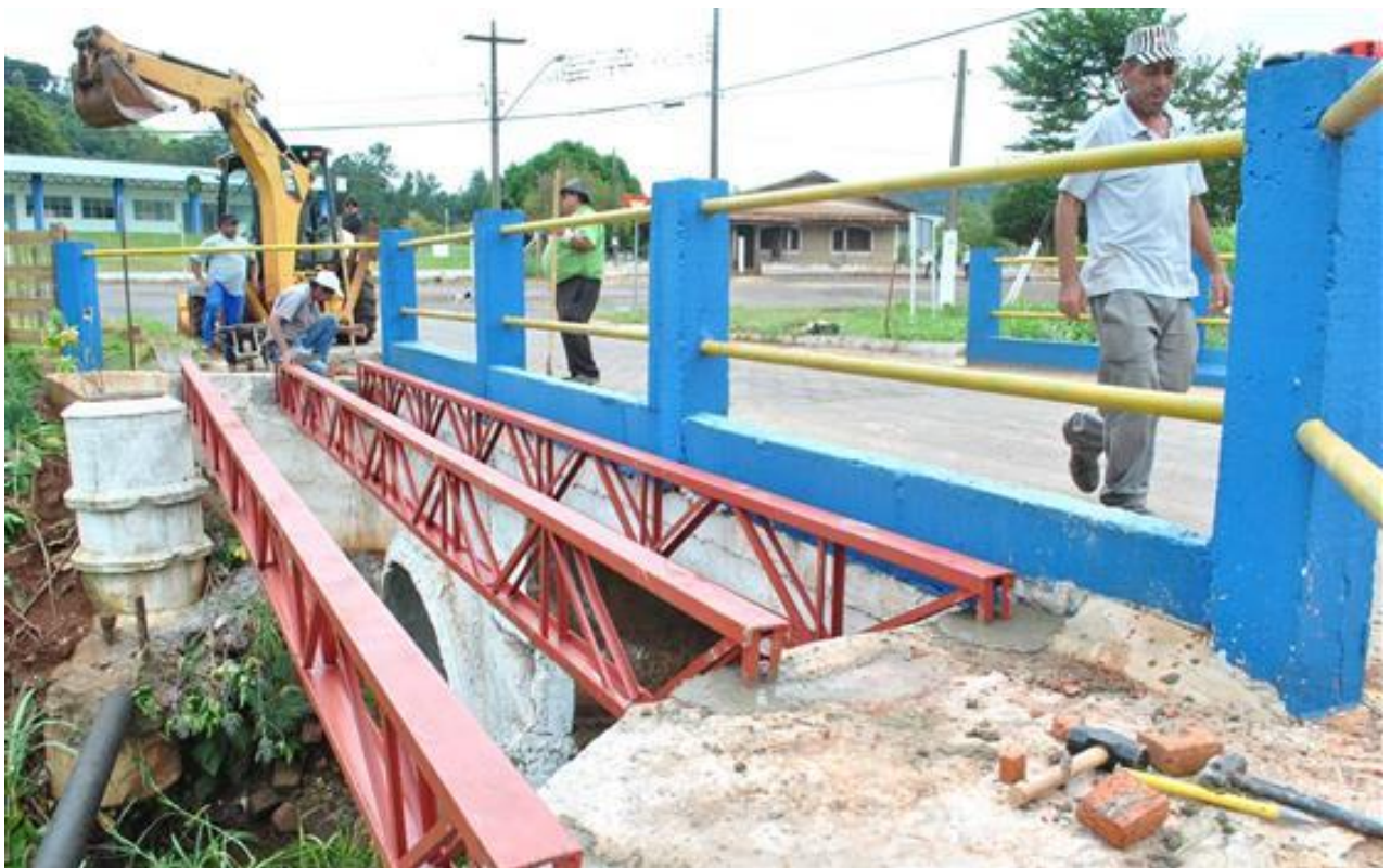
Figura 11: Ponte Rua Rosário Agostinho em Santo Antônio da Platina
