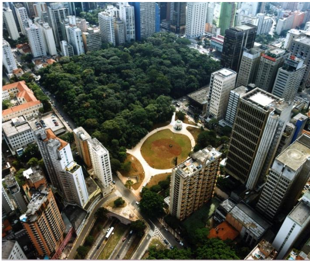
Figura 13: Garagem Subterrânea Trianon
