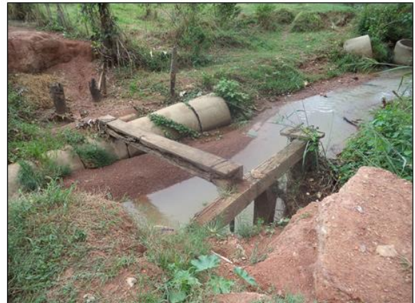
Figura 2 – Não existe ponte, somente uma “pinguela” de madeira. As manilhas estão todas soltas dentro do canal do córrego, e até mesmo enterradas no seu leito. É impossível atravessar de bicicleta, moto ou carro. Ou seja, não há acesso algum de um lado ao outro do córrego neste ponto da via.
