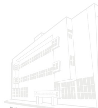
Edifício Marechal Rondon - Sede atual 2013
