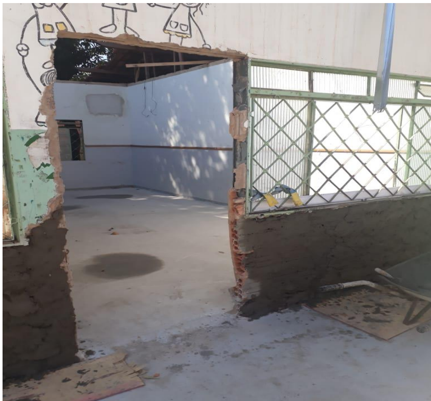
Foto 13 – Piso danificado da entrada da sala de aula em reforma
