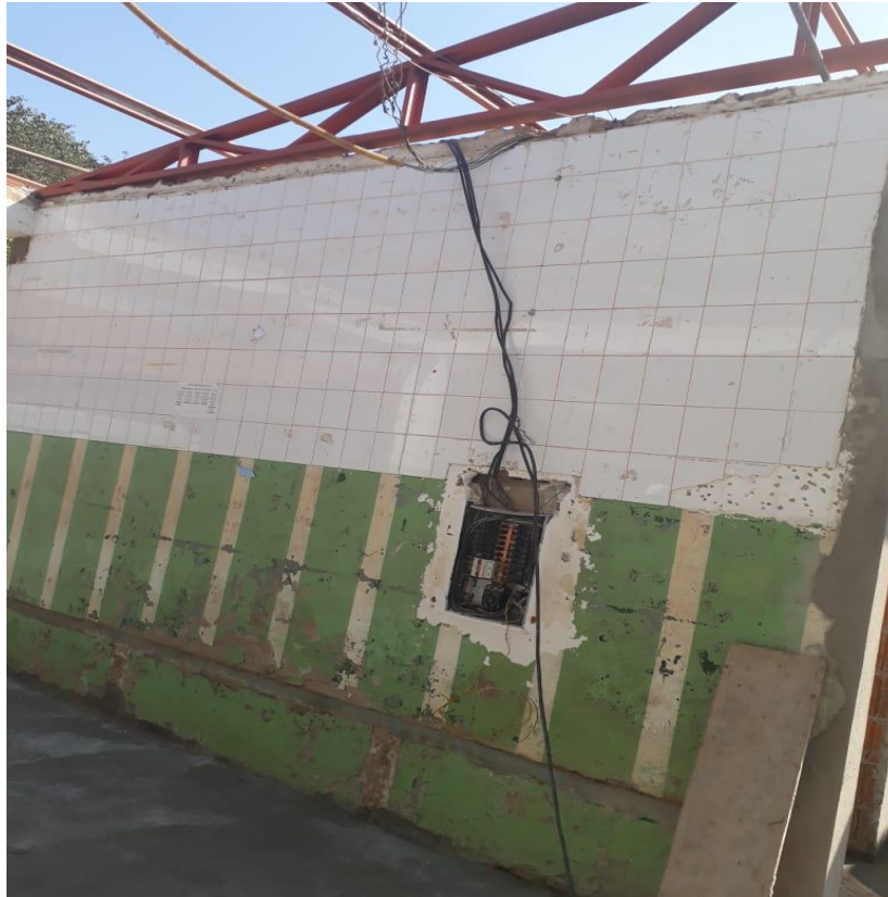
Foto 32 – Instalação elétrica em reforma
