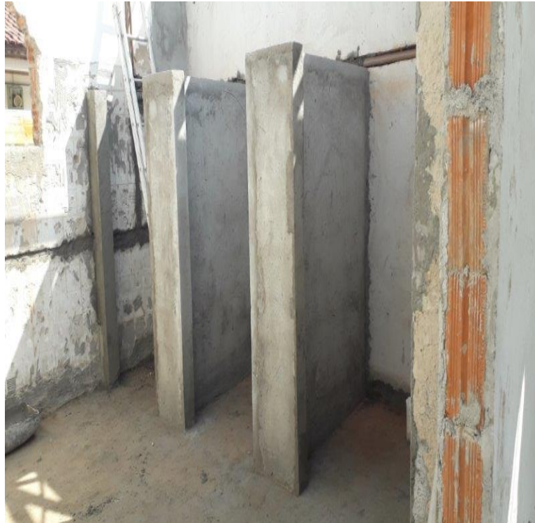
Foto 26 – Banheiro em reforma
