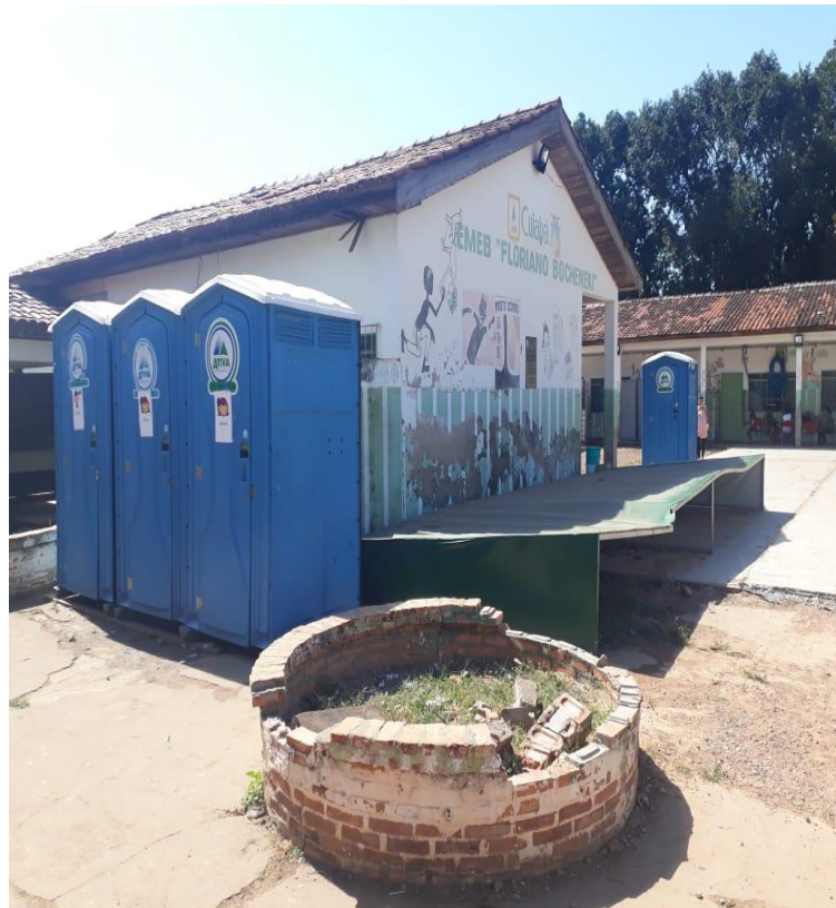
Foto 21 – Banheiros químicos instalados
