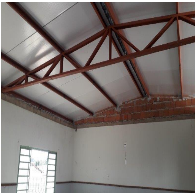
Foto 09 – Salas de aula em reforma
