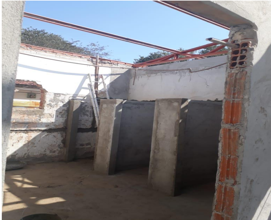
Foto 20 – Banheiro em reforma
