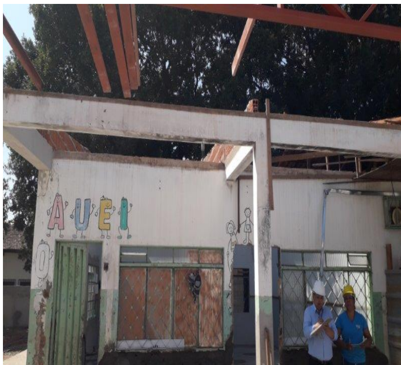
Foto 03 – Telhado/forro em reforma
