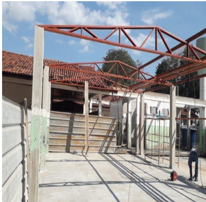
Foto 46 – Instalação do refeitório
