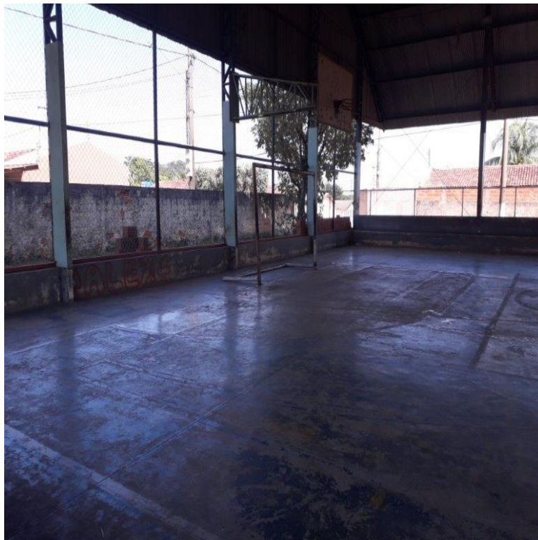
Foto 15 – Piso danificado da quadra de esportes
