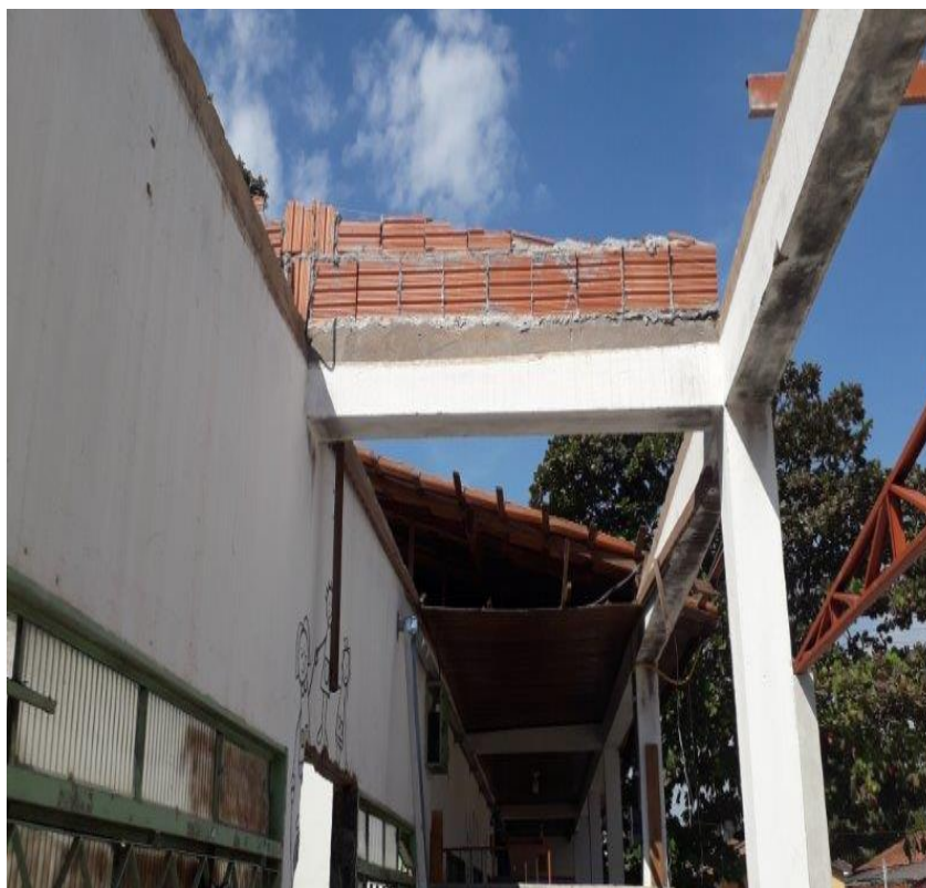
Foto 04 – Telhado/forro do pátio em reforma
