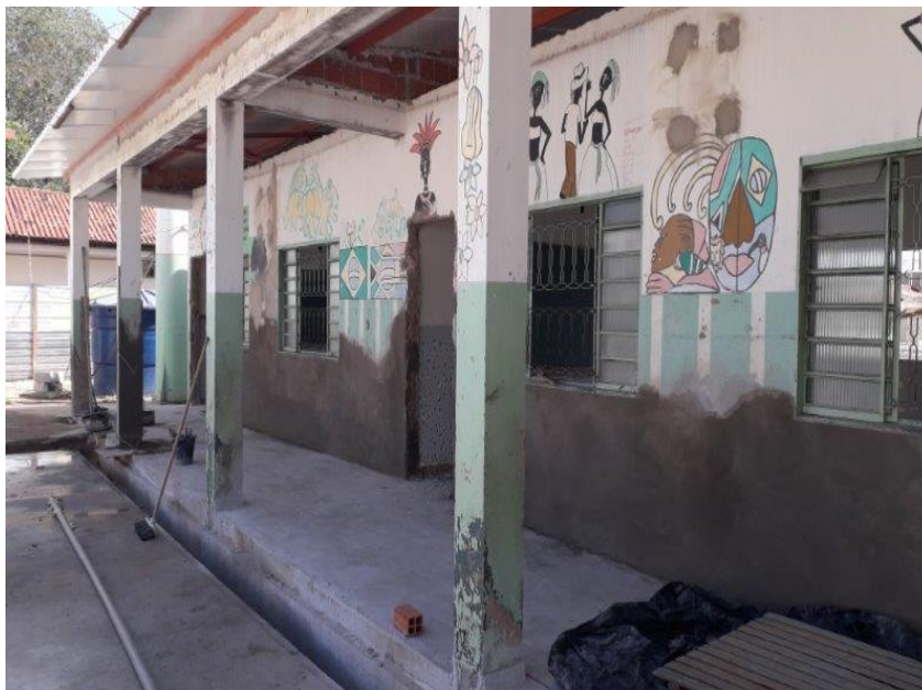
Foto 13 – Piso danificado da entrada da sala de aula em reforma
