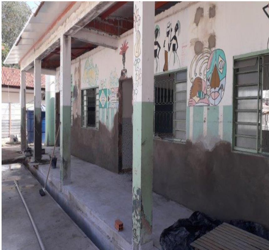
Foto 22 – Parede da sala de aula em reforma
