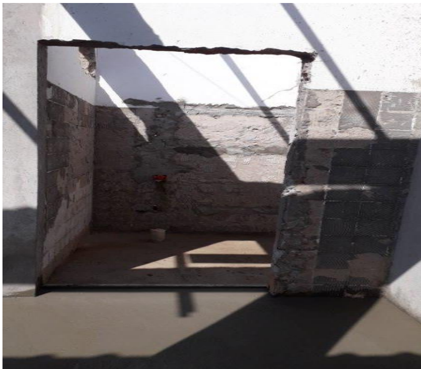
Foto 51 – Banheiro em reforma
