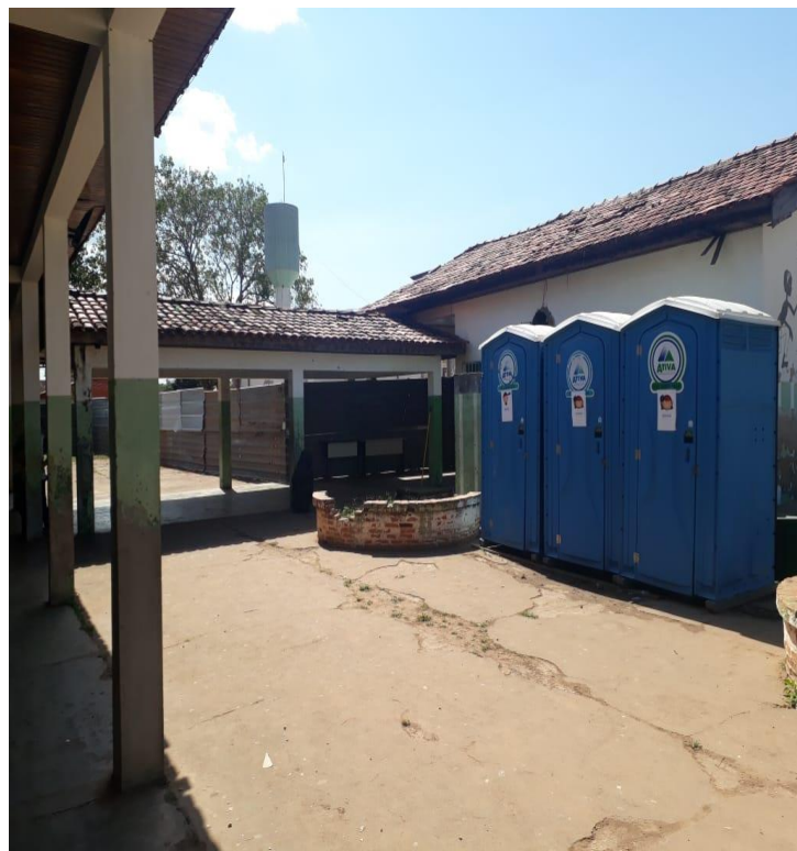
Foto 52 – Banheiros químicos foram instalados
