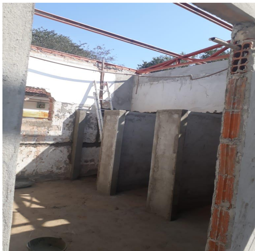
Foto 50 – Banheiro em reforma
