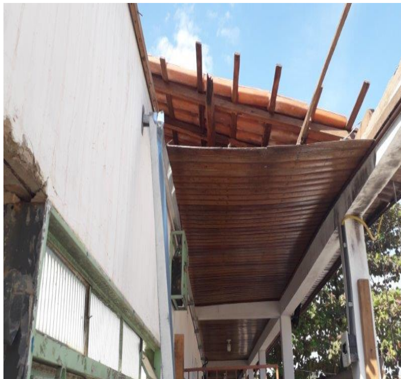
Foto 08 - Forro/telhado do corredor em reforma
