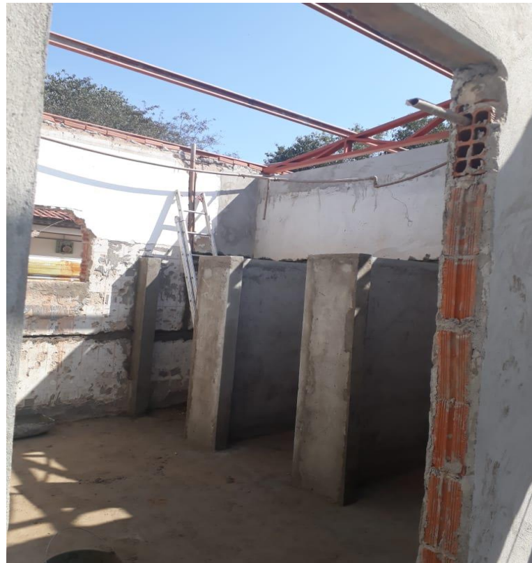
Foto 27 – Banheiro em reforma
