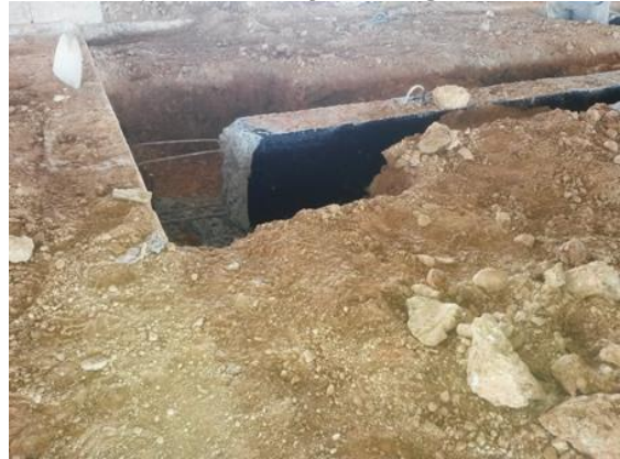
Foto 8: Impermeabilização de vigas baldrames.
