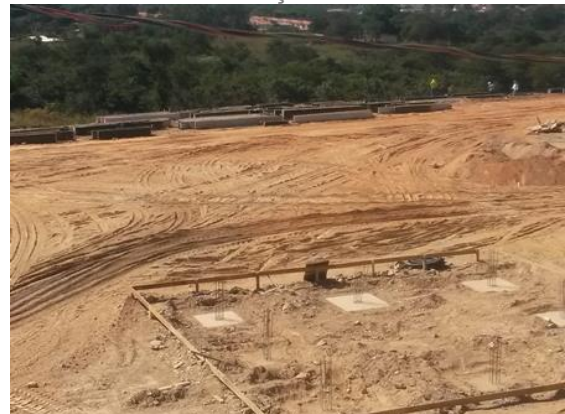
Foto 6: Fundação em estacas.
