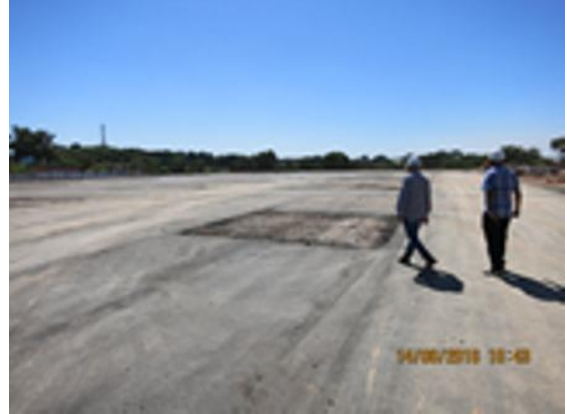
Foto 2: Pavimentação asfáltica do estacionamento sem aditivo para substituir o previsto em paver .
