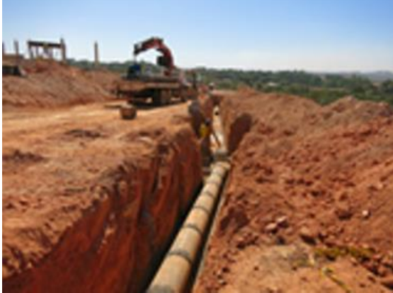
Foto 1: Drenagem profunda com manilhas de concreto
