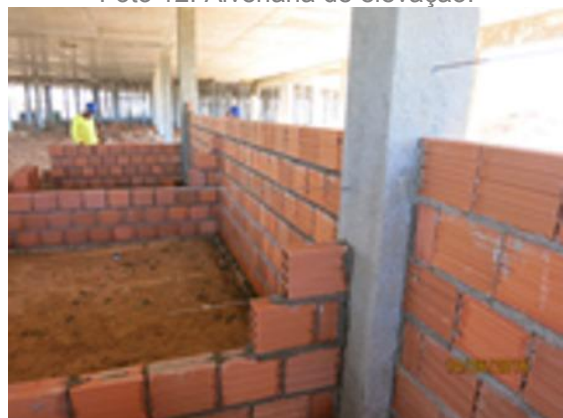
Foto 12: Alvenaria de elevação.
