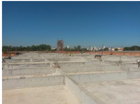
Foto 10: Estrutura de concreto-laje de cobertura.
