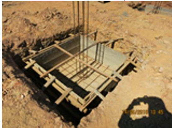
Foto 5: Fundação em sapata.
