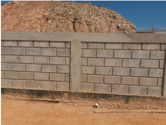
Foto 3: Fundações de elementos de urbanismo.
