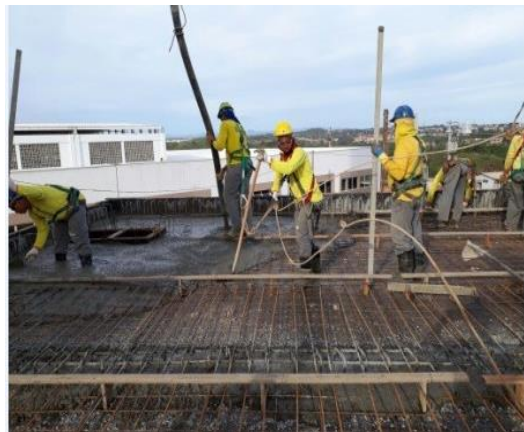
Foto 59: conclusão do reservatório inferior – concretagem final
