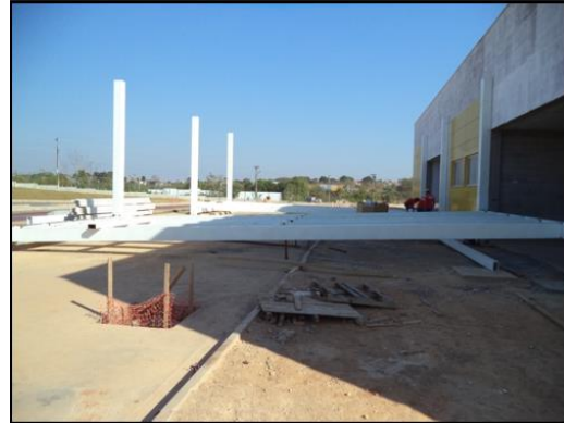
Foto 51: montagem de marquises metálicas – entrada do setor de emergência
