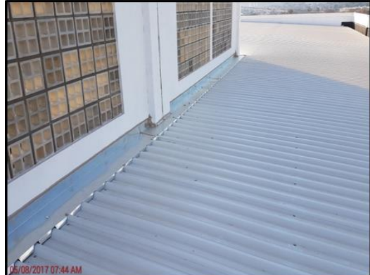
Foto 49: instalação de rufos metálicos – setor amaz. e estocagem
