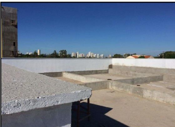
Foto 42: execução de chapim em concreto - Administração
