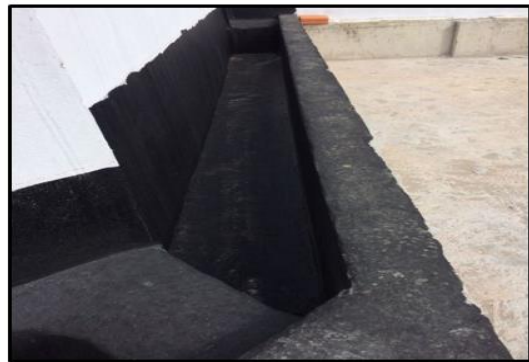
Foto 35: impermeabilização de calhas – laje técnica
