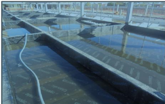
Foto 12: regularização de laje, aplicação e teste de manta impermeabilizante
