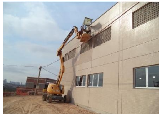
Foto 55: aplicação de cerâmica - externa e rejunte – fachadas principais
