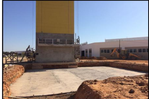
Foto 45: execução de lastro – reservatório inferior
