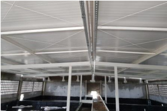
Foto 64: instalação de telhas termo acústicas – setor de internações
