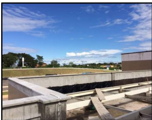
Foto 37: pingadeiras em concreto – fachada principal
