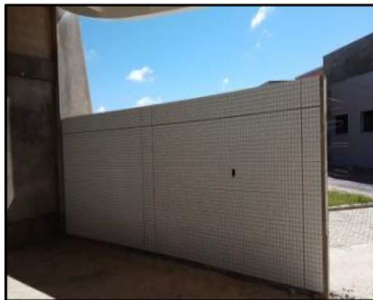
Foto 30: aplicação de cerâmica externa (anexo capela)
