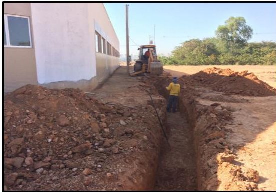
Foto 46: execução de valas para assentamentos de tubos – externo almoarifado
