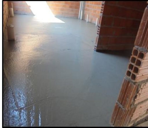
Foto 9: execução de contra piso
