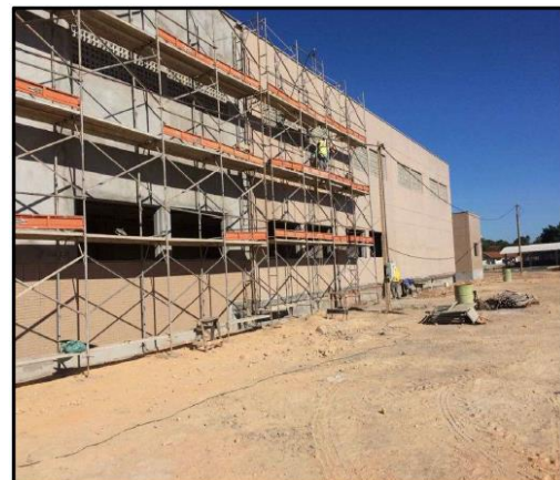
Foto 41: aplicação de cerâmica externa – setor de emergência
