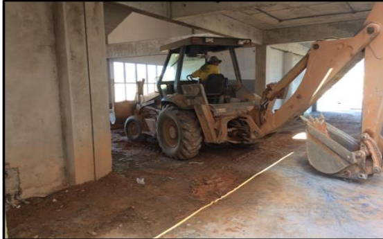
Foto 44: movimentação de terra e compactação de solo – setor de ambulatório e imagem
