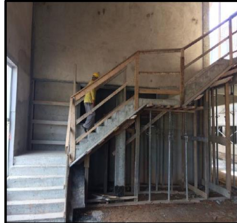
Foto 39: execução escada – Módulo Me.
