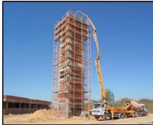
Foto 2: concretagem reservatório superior
