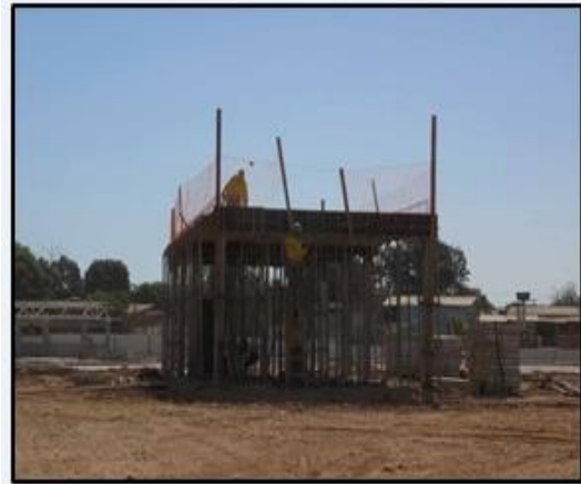
Foto 4: execução de subestação 03
