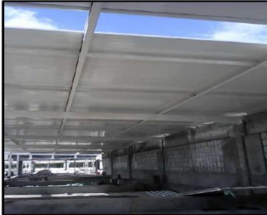
Foto 26: execução de cobertura (laje técnica)
