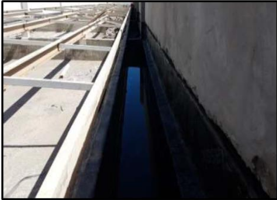
Foto 32: impermeabilização de calhas – laje técnica
