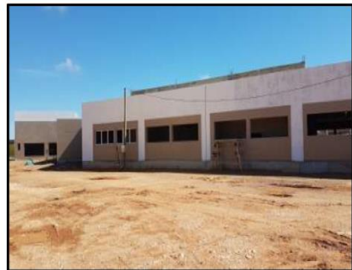
Foto 33: aplicação de selador – fachada principal
