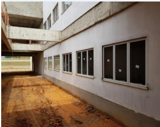
Foto 58: instalação de vidros – área externa do prédio principal
