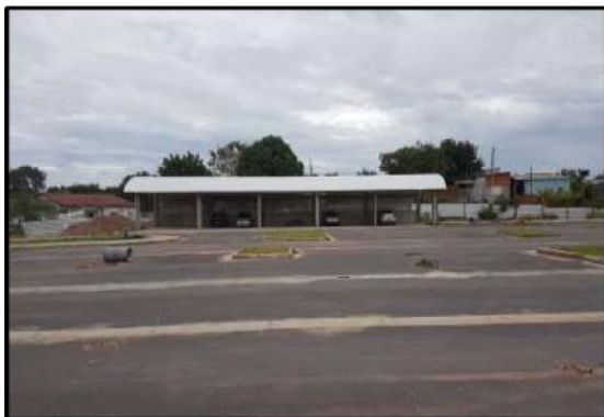
Foto 24: execução de cobertura (anexo garagem de ambulância)
