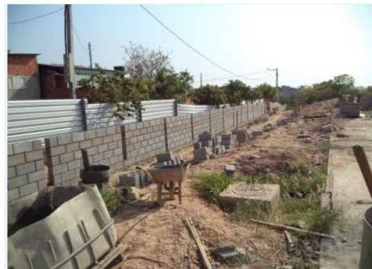
Foto 54: baldrame, pilares e bloco estruturais – muro limítrofe
