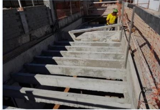
Foto 63: pergolados em concreto armado (setor de emergência)
