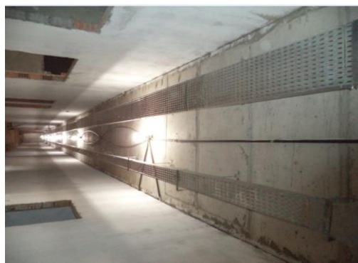
Foto 61: instalação de eletrocalhas – área técnica e prédio principal
