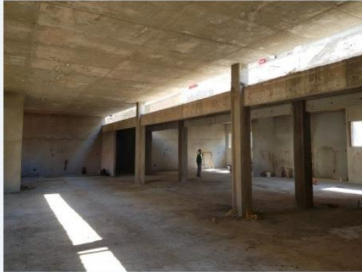
Foto 56: execução de reboco e emboço -prédio principal
