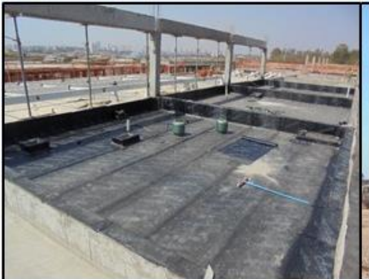
Foto 5: regularização de laje e aplicação de manta impermeabilizante
