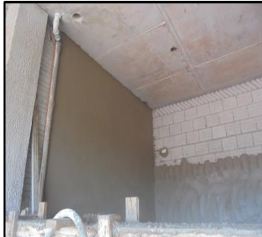
Foto 11: execução de reboco
