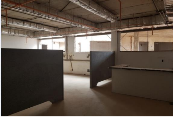
Foto 62: instalação de divisórias em granito – setor de emergência
