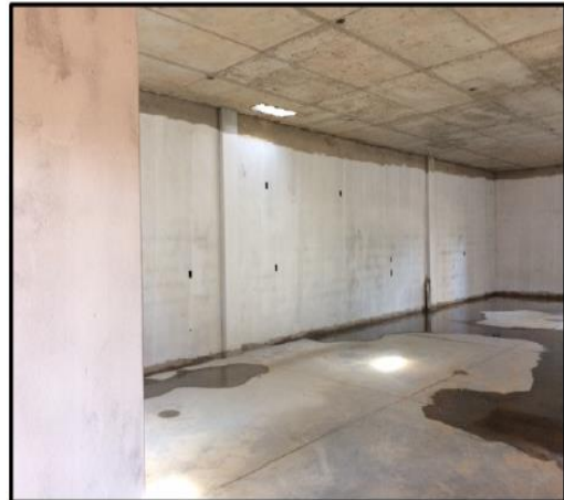
Foto 19: aplicação de selador para pintura
