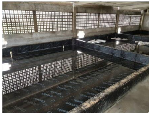
Foto 67: impermeabilização de lajes - internações
