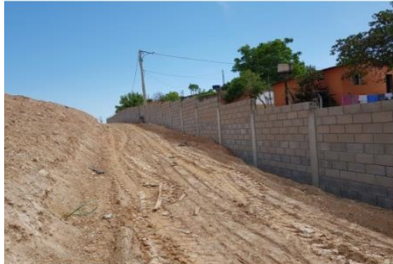
Foto 57: baldrame, pilares e bloco estruturais – muro limítrofe
