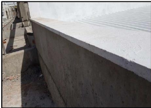
Foto 28: execução de pingadeira em concreto (laje técnica)
