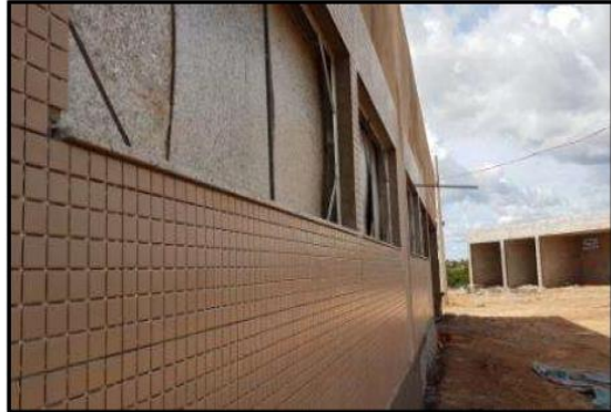
Foto 27: execução de peitoril em granito (fachadas prédio principal)
