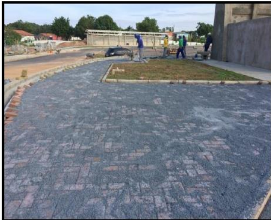
Foto 22: execução do piso intertravado
