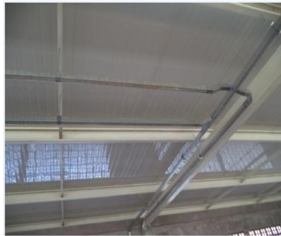
Foto 53: instalação de eletrocalhas – área técnica
