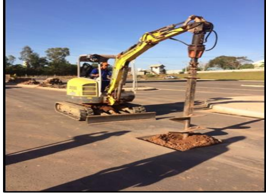
Foto 47: execução do “pescoço” dos poços de visita- estacionamento
