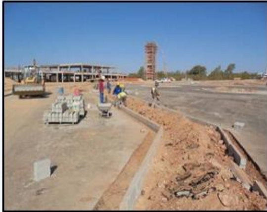
Foto 3: execução de meio fio e calçada
