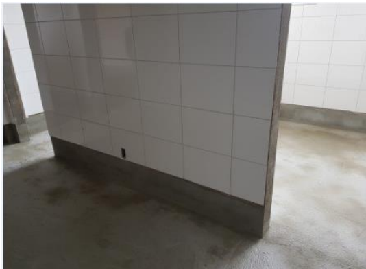
Foto 66: impermeabilização de áreas molhadas – setor de emergência
