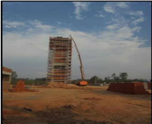
Foto 10: conclusão de alvenaria e estrutura do reservatório
