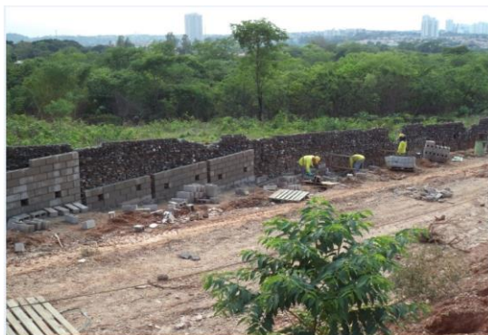
Foto 60: baldrame, pilares e bloco estruturais – muro limítrofe
