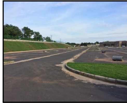
Foto 21: colocação de grama nos taludes e canteiros
