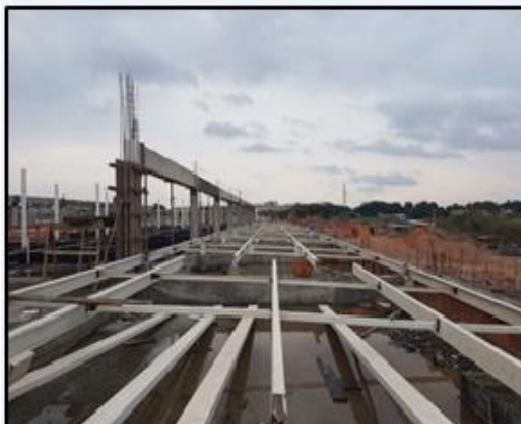
Foto 6: execução de cobertura em estrutura metálica
