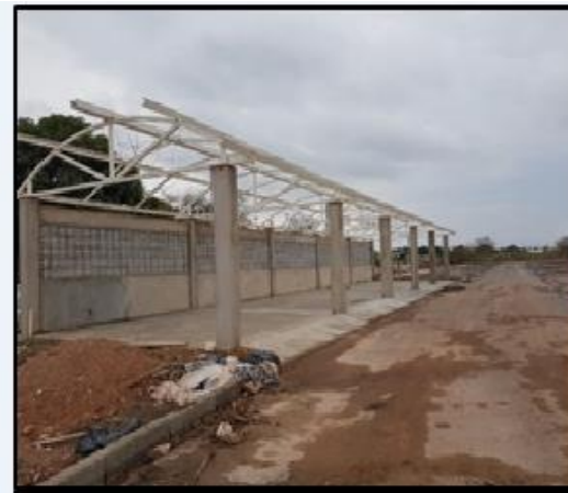
Foto 7: execução de elemento vazado
