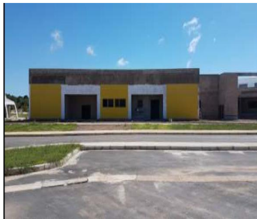
Foto 31: aplicação de cerâmica externa – prédio principal (setor de emergência)
