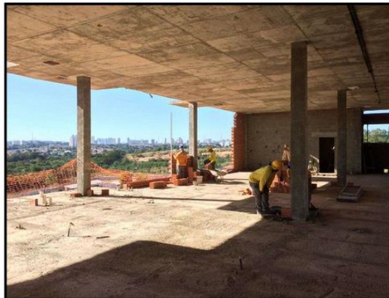
Foto 40: execução de alvenaria e encunhamento – internações nível térreo
