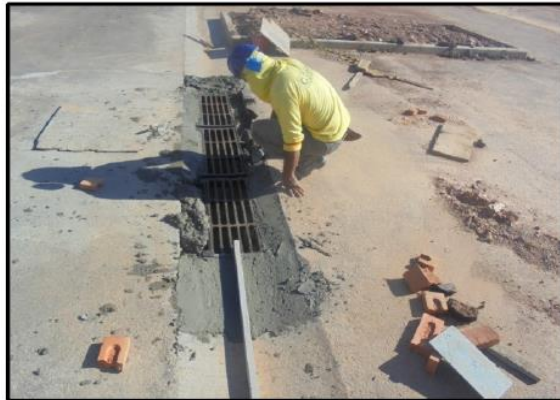
Foto 16: execução de sarjetas e grelhas
