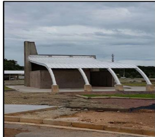
Foto 23: execução de cobertura capela
