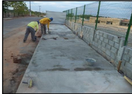
Foto 15: execução de gradil e calçada externa
