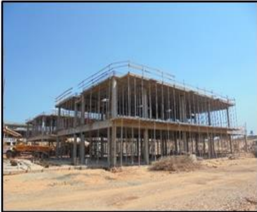
Foto 1: concretagem de lajes e pilares
