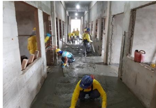
Foto 65: execução de contrapiso – prédio principal
