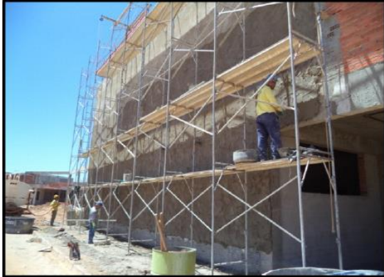
Foto 14: execução de reboco (fachada externa)
