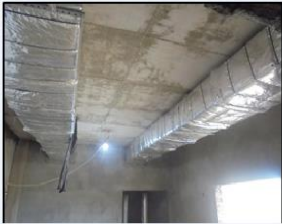
Foto 8: execução de dutos de climatização
