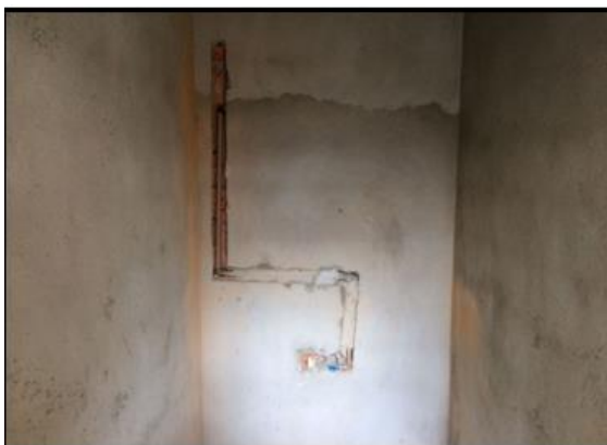
Foto 36: instalação de tubulação hidráulica – sanitários de emergência
