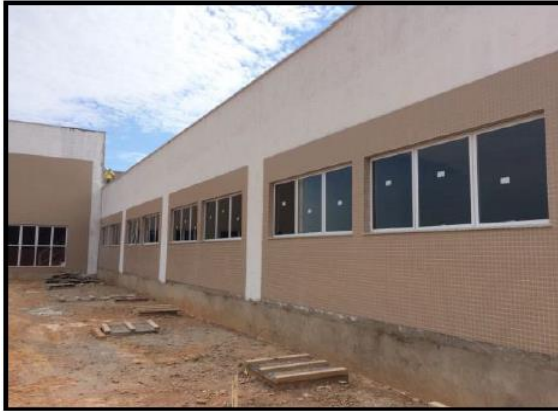
Foto 38: aplicação de cerâmica externa e janelas – fachada
