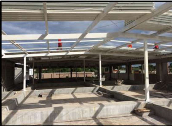
Foto 34: execução de cobertura – laje técnica
