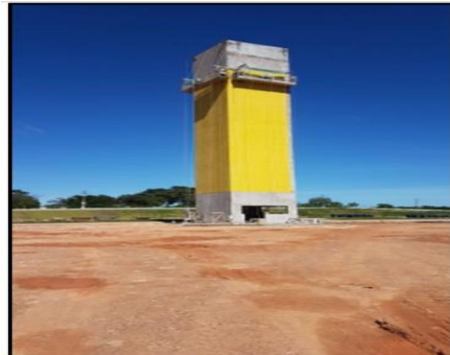
Foto 29: reservatório – aplicação de cerâmica externa
