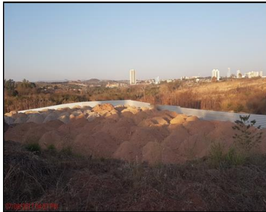
Foto 52: tapumes de cercamento do canteiro de obras
