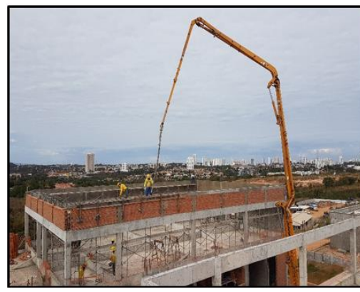
Foto 43: concretagem de cintas de amarração da alvenaria de platibanda – área técnica
