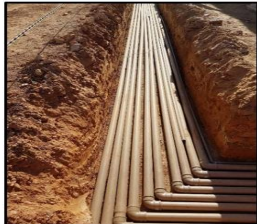
Foto 6: instalação de águas pluviais
