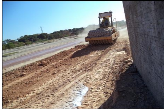
Foto 50: serviços de terraplenagem para a 2ª fase de pavimentação – localizado ao fundo do hospital
