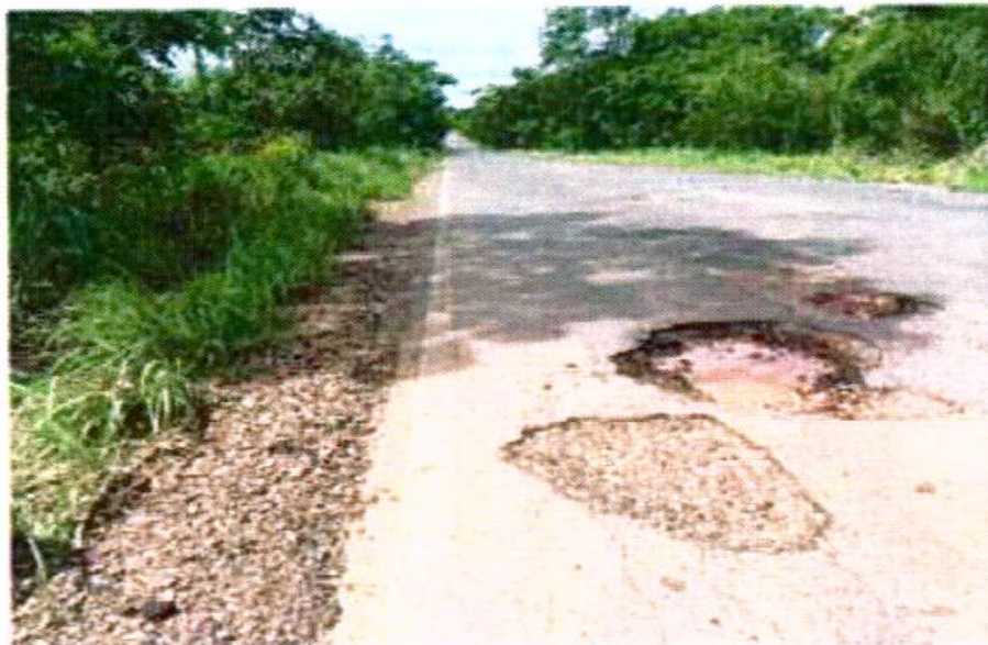
Estaca 326 - Painelas que requer remendo profundo e necessita de recomposição do acostamento
