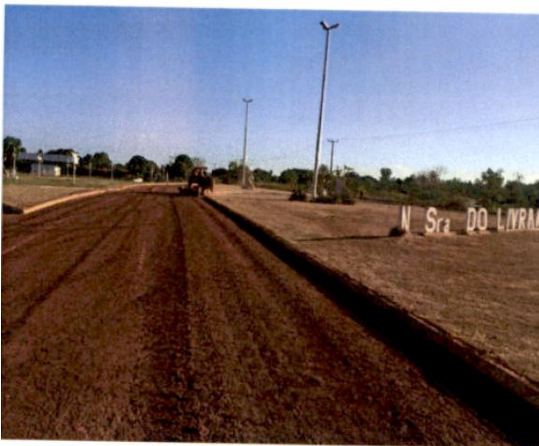
RECICLAGEM TREVO DE LIVRAMENTO
