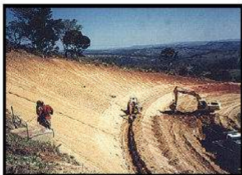
Foto 10 - Taludes e drenagem em construção, sendo o material do talude de grande suscetibilidade à erosão, por isso deverá ser protegido com segurança e rapidez
