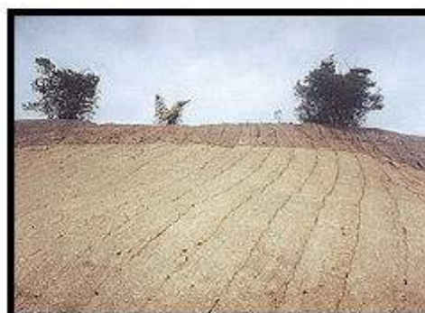
Foto 09 - Mesmo local imediatamente após a execução dos serviços, mostrando o aspecto visual, a proteção total dos taludes cuja superfície será coberta pela vegetação posteriormente
