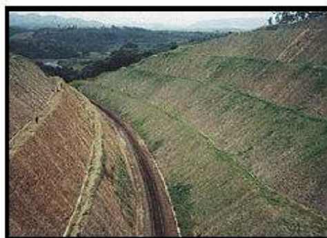
Foto 5 - Serviços de recuperação já adiantados, com drenagem superficial e profunda executada, recuperação das erosões e aplicação de biomanta antierosiva
