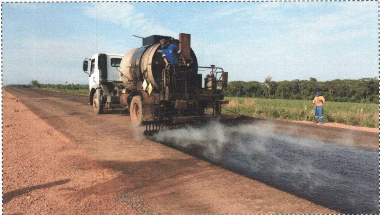
Execução de Tratamento Superficial Duplo – E4005
