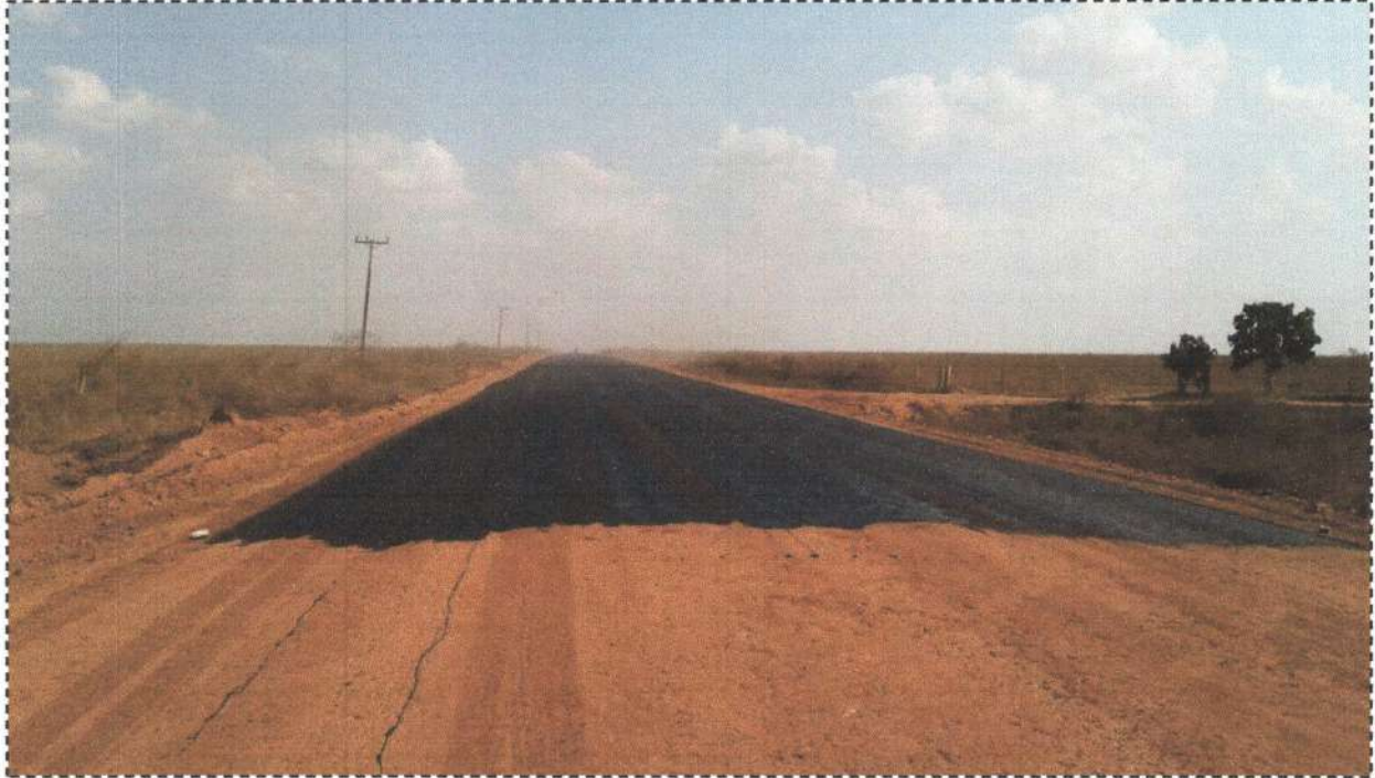
Execução de Imprimação – E3862 Coord. geog.: 12° 15'36.54"S / 58°38'04"O
