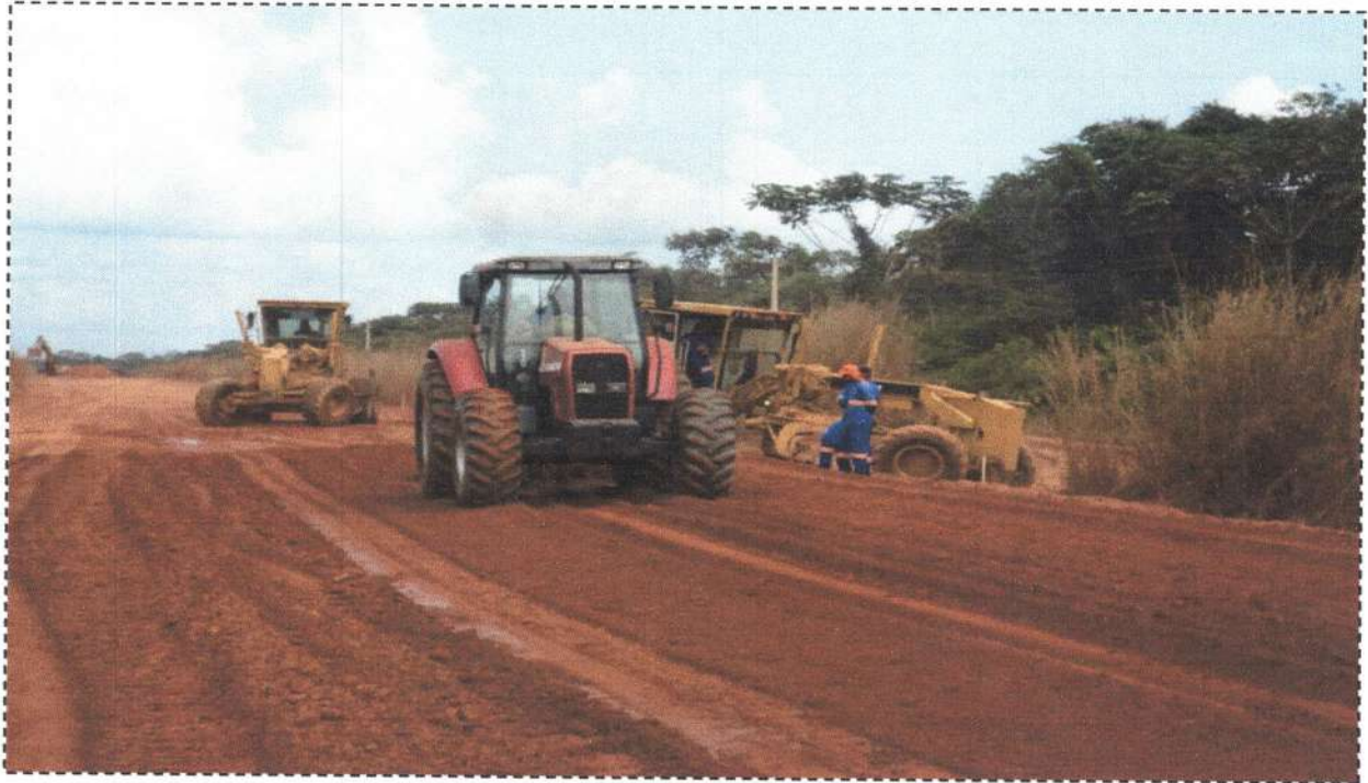
Execução de Base – E3515
