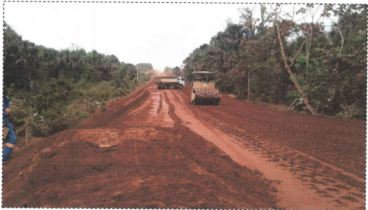
Execução da compactação da Base – E3612
