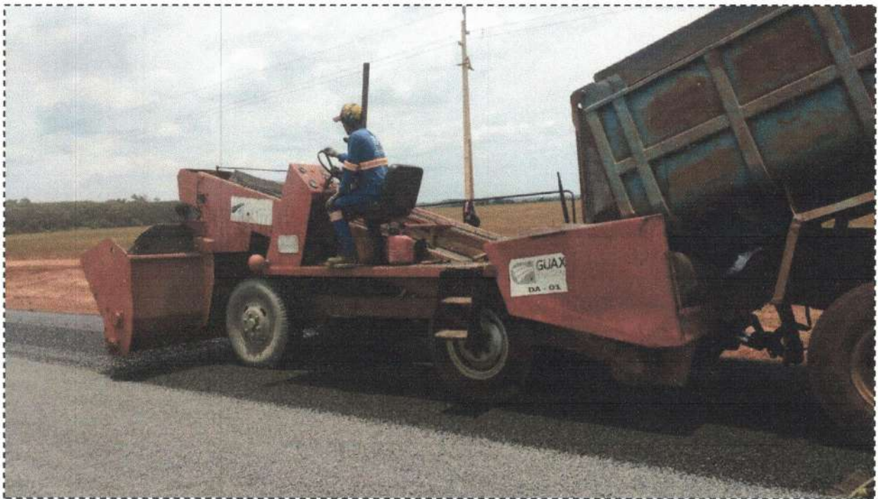
Execução de Tratamento Superficial Duplo – E4052 Coord. geog.: 12° 15'36.54"S / 56°38'02.54"O
