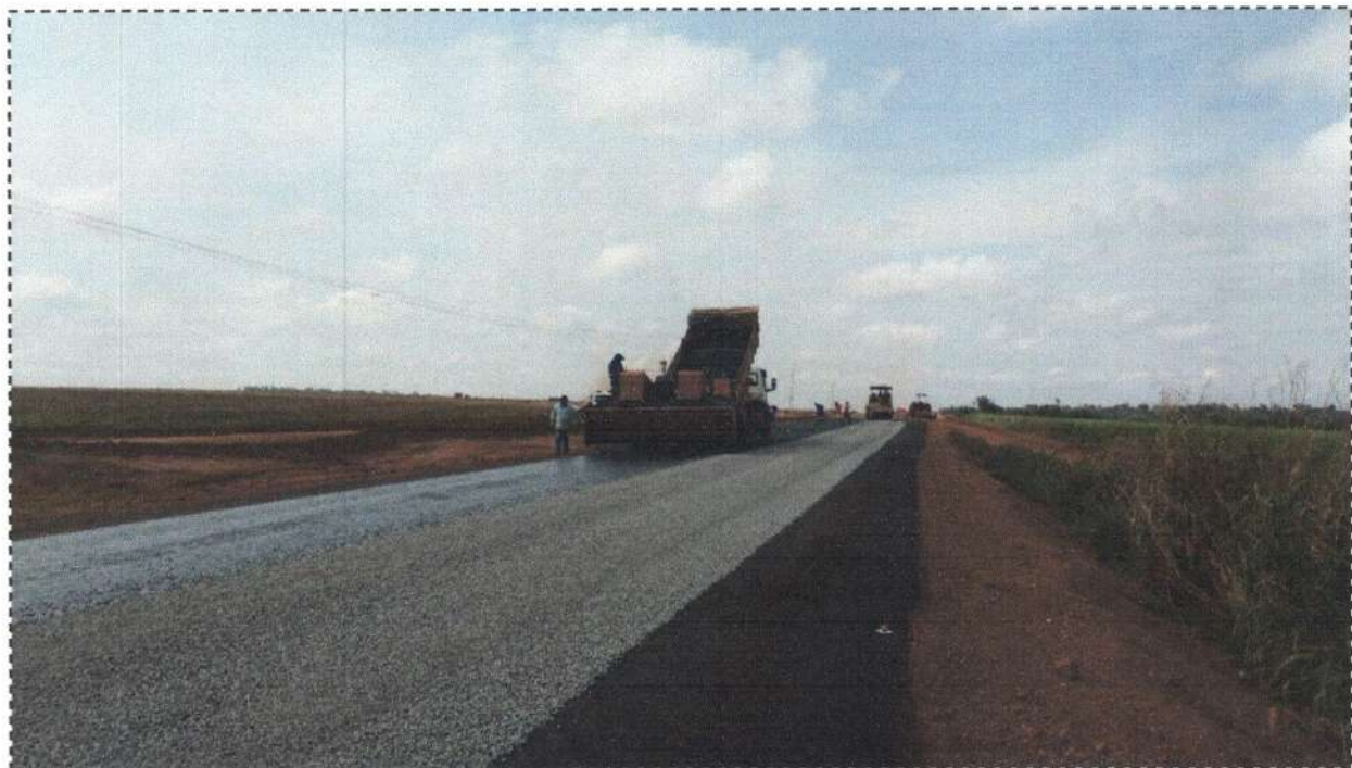
Execução de Tratamento Superficial Duplo – E3947
