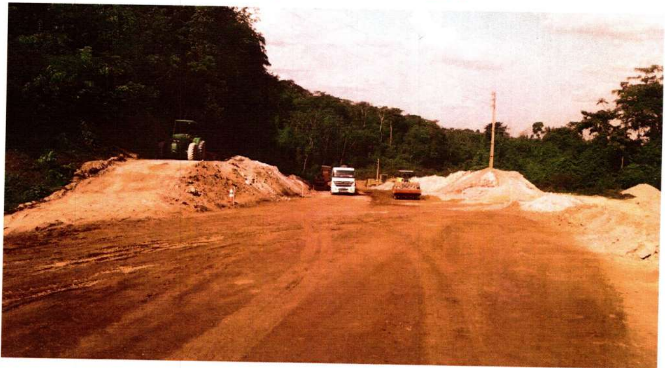
Execução de Subleito – E3712
