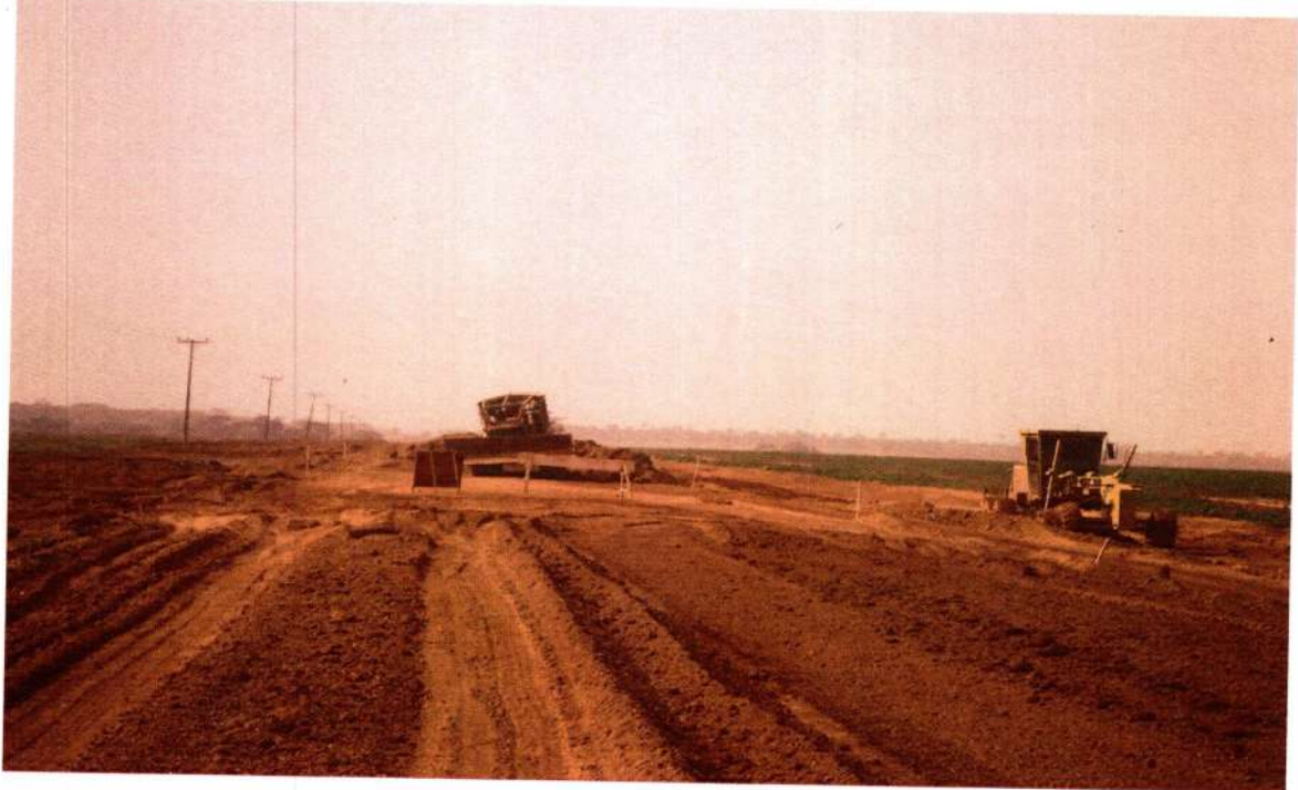
Execução de Sub-base – E3562
