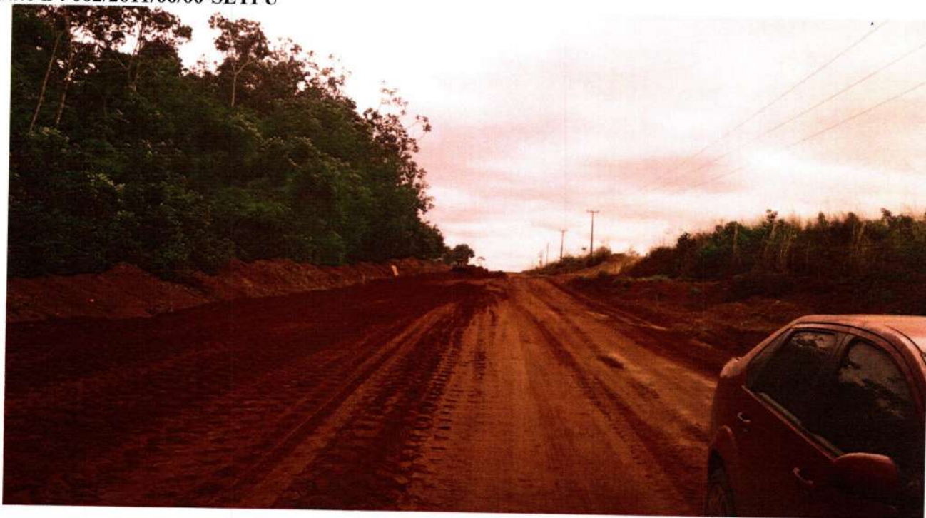
Execução de Sub-base – E3362
