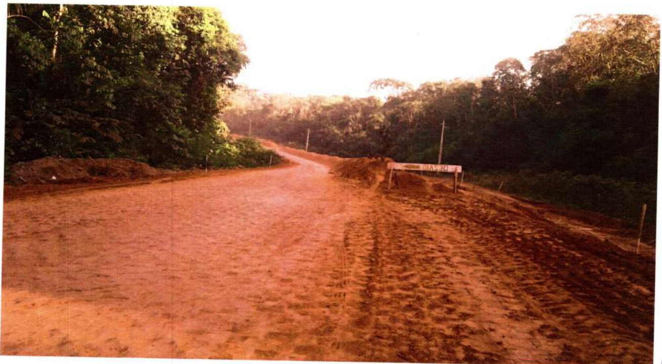
Execução de Sub-base – E2762
