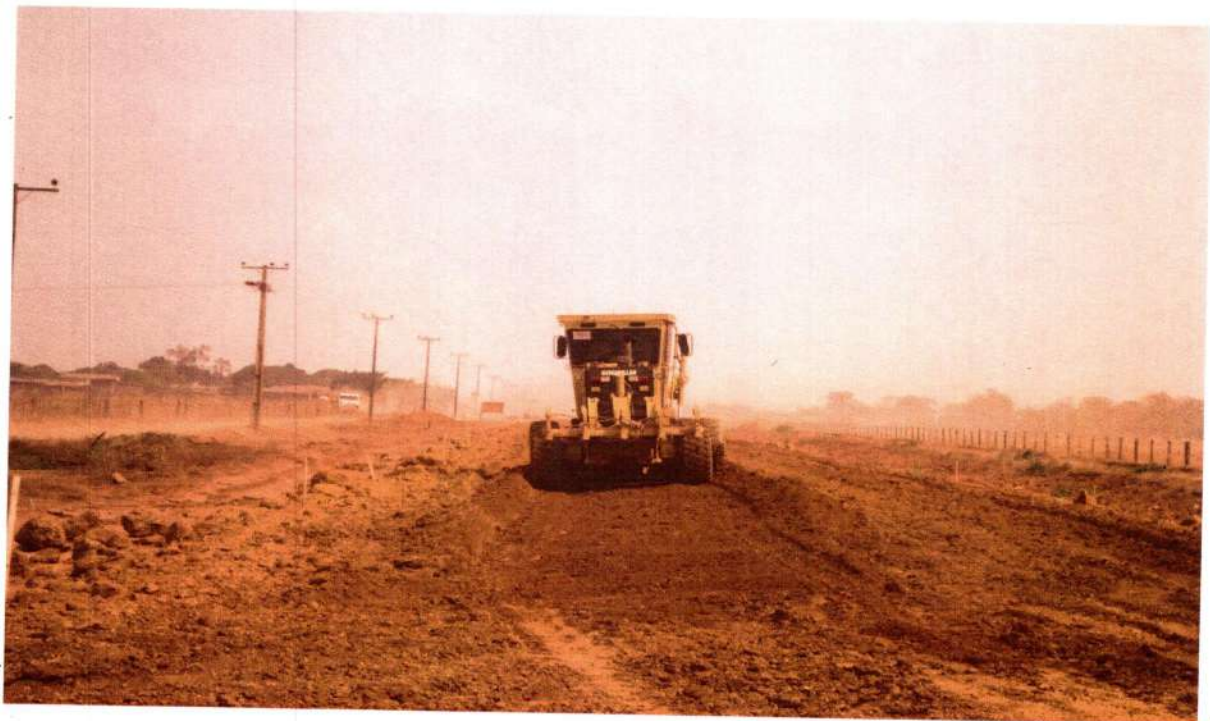
Execução de Subleito – E3612 Coord. geog.: 12° 27'26.08"S / 57°45'41.18"O
