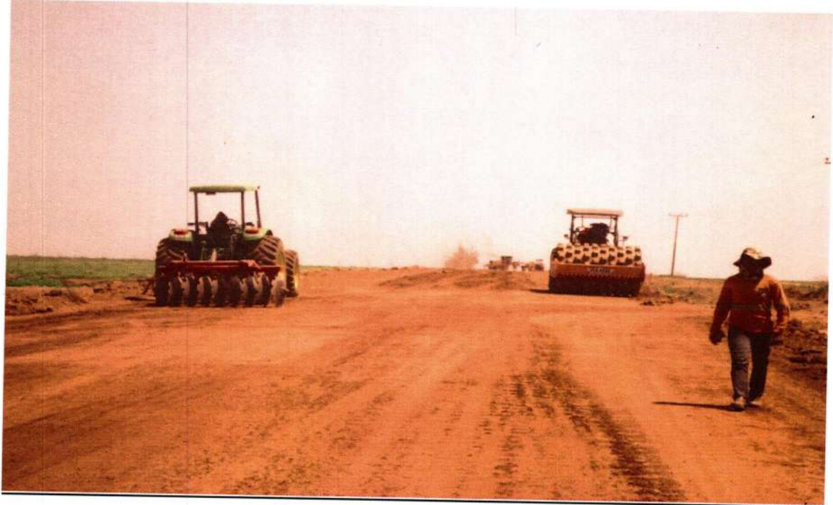
Regularização de Subleito – E3515 Coord. geog.: 12° 27'26.08"S / 57°38'42.18"O
