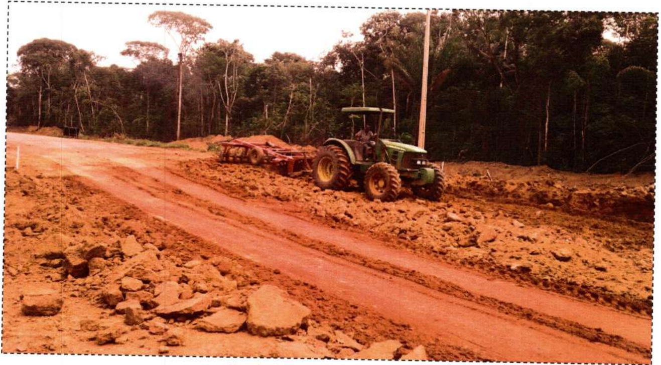
Regularização de Subleito – E2679
