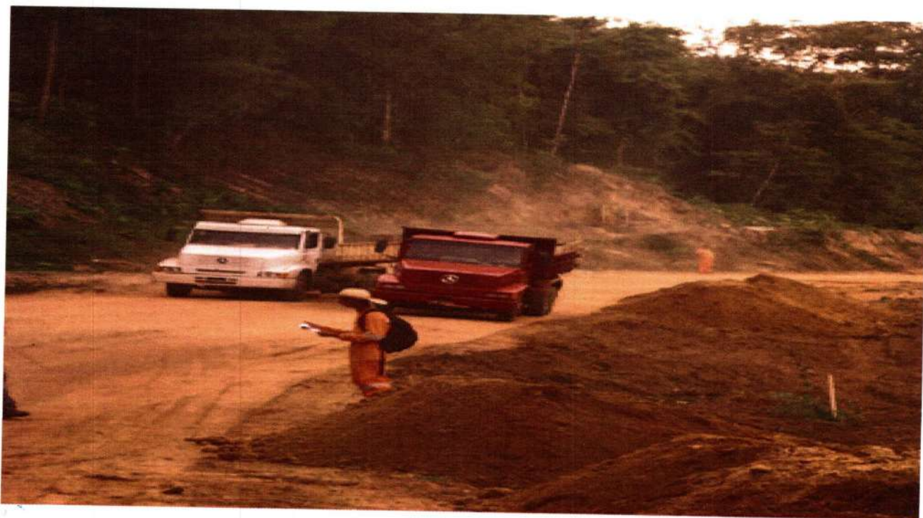
Regularização de Subleito – E3515 Coord. geog.: 12° 27'26.08"S / 57°38'42.18"O
