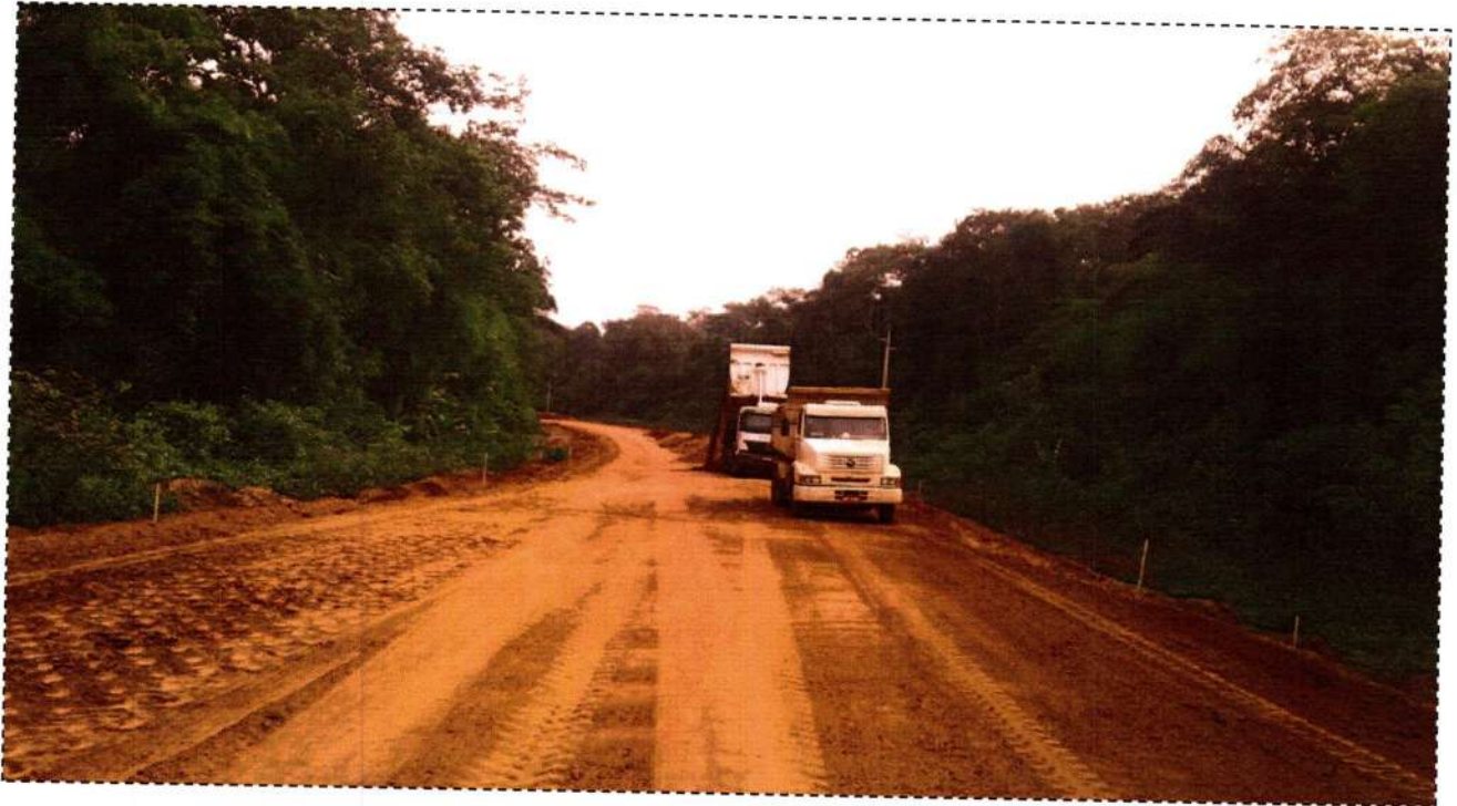
Execução de Sub-base – E2712
