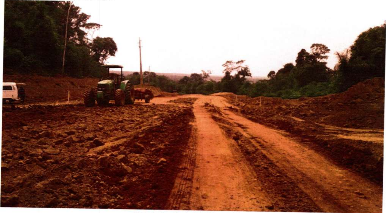
Regularização de Subleito – E3315
