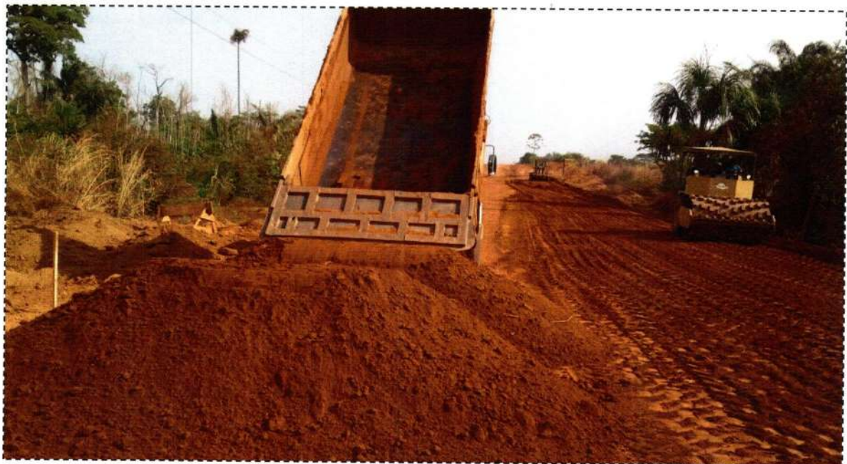
Execução de Base – E3850
