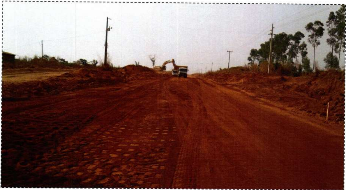
Execução de Base – E3830
