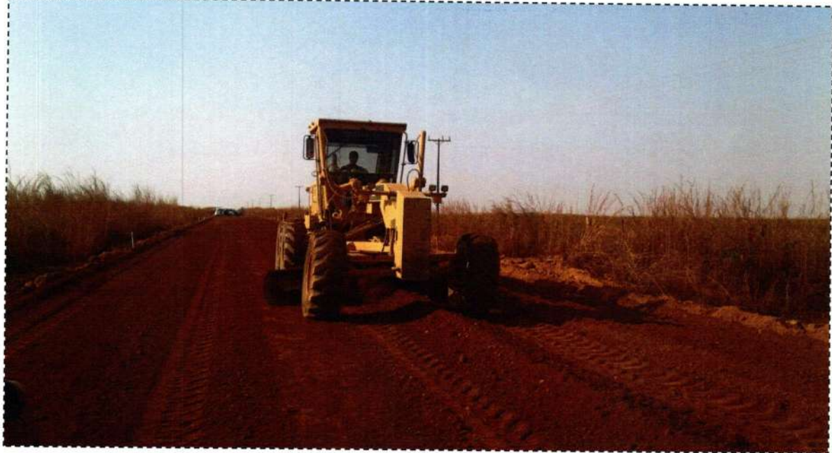
Execução de Base – E3950
