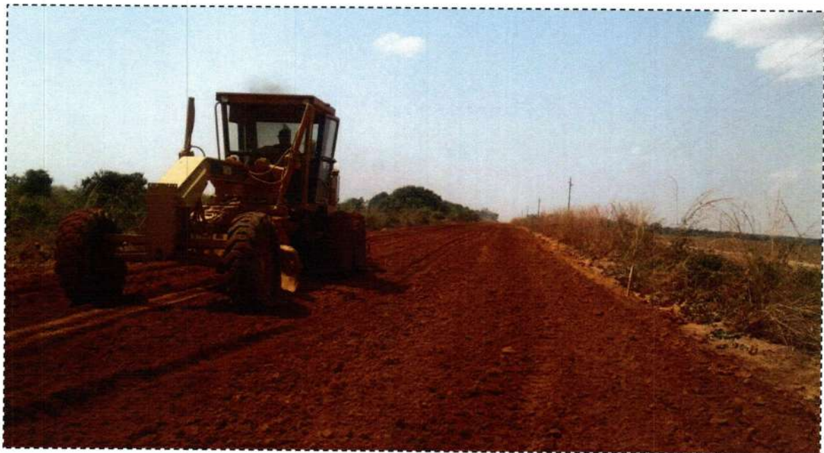
Execução de Sub-base – E3860
