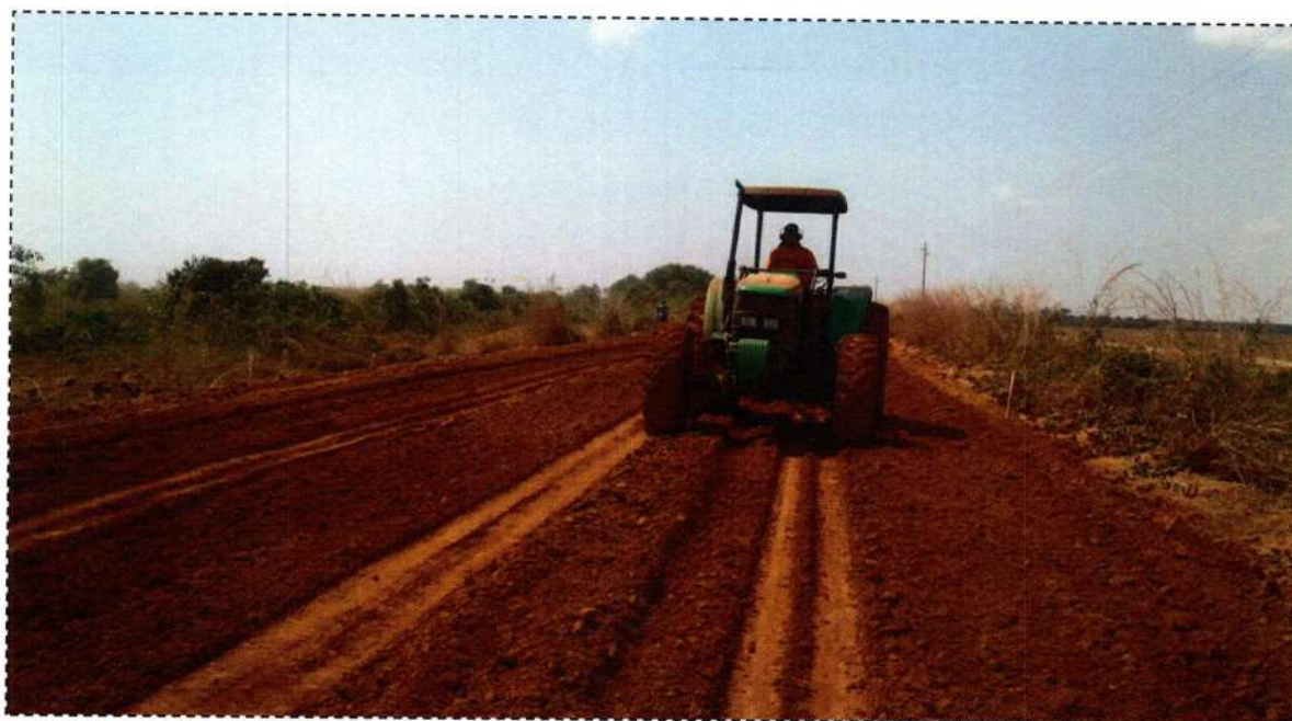
Execução de Sub-base – E3860
