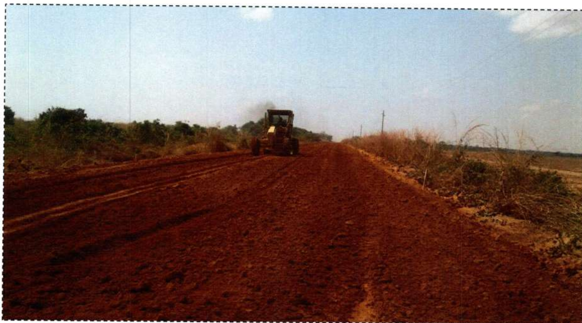
Execução de Sub-base – E3860
