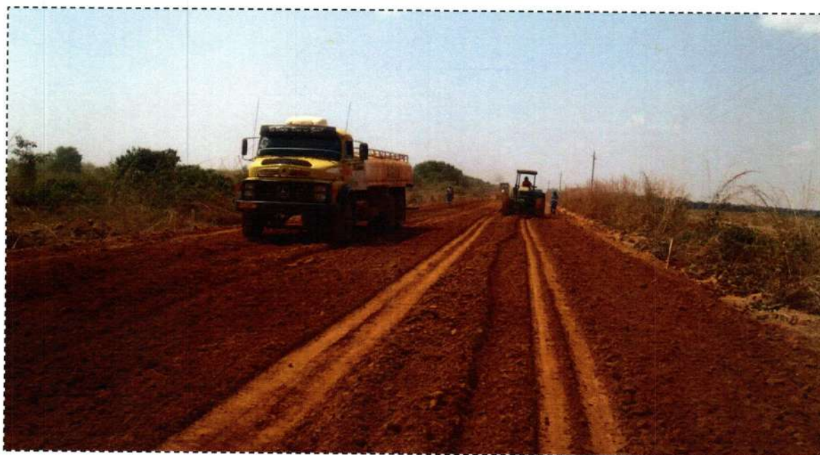
Execução de Sub-base – E3860
