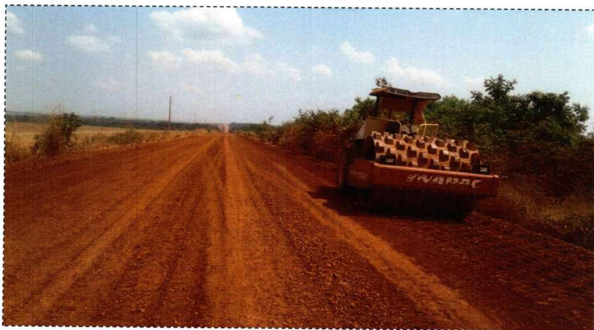
Execução de Sub-base – E3920
