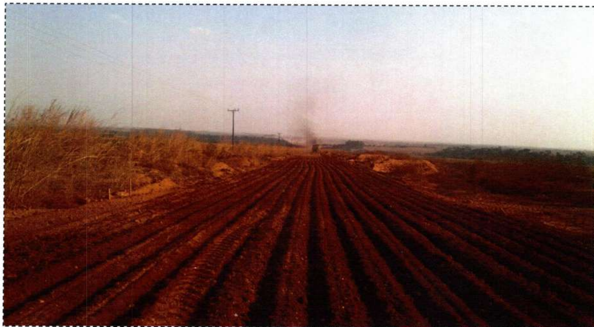
Execução de Base – E4045
