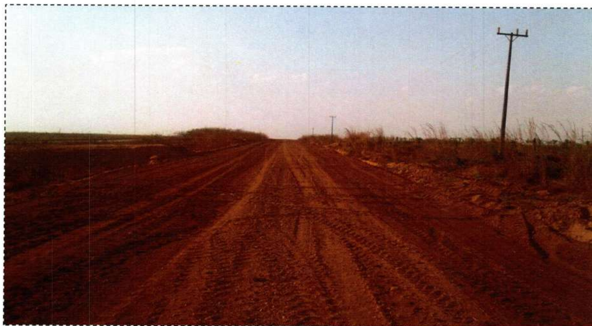
Execução de Base – E4045
