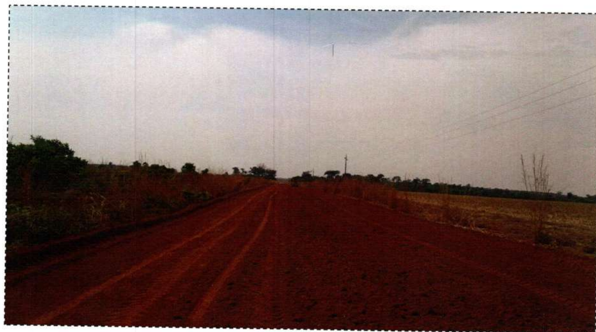
Execução de Base – E4055
