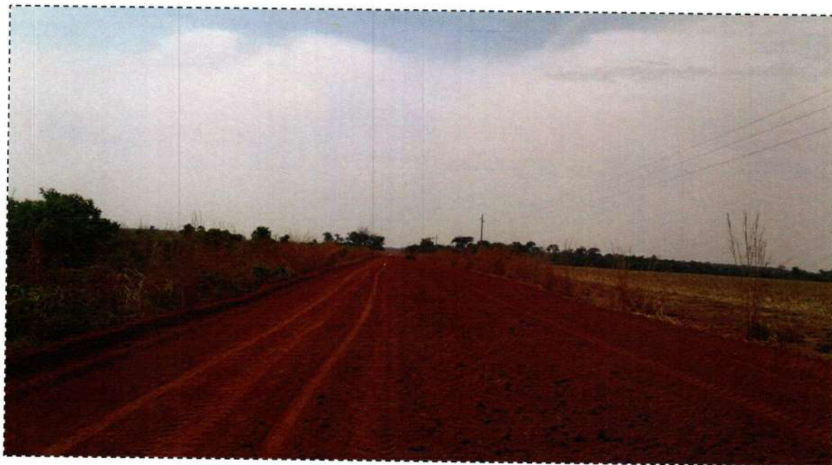
Execução de Base – E4055
