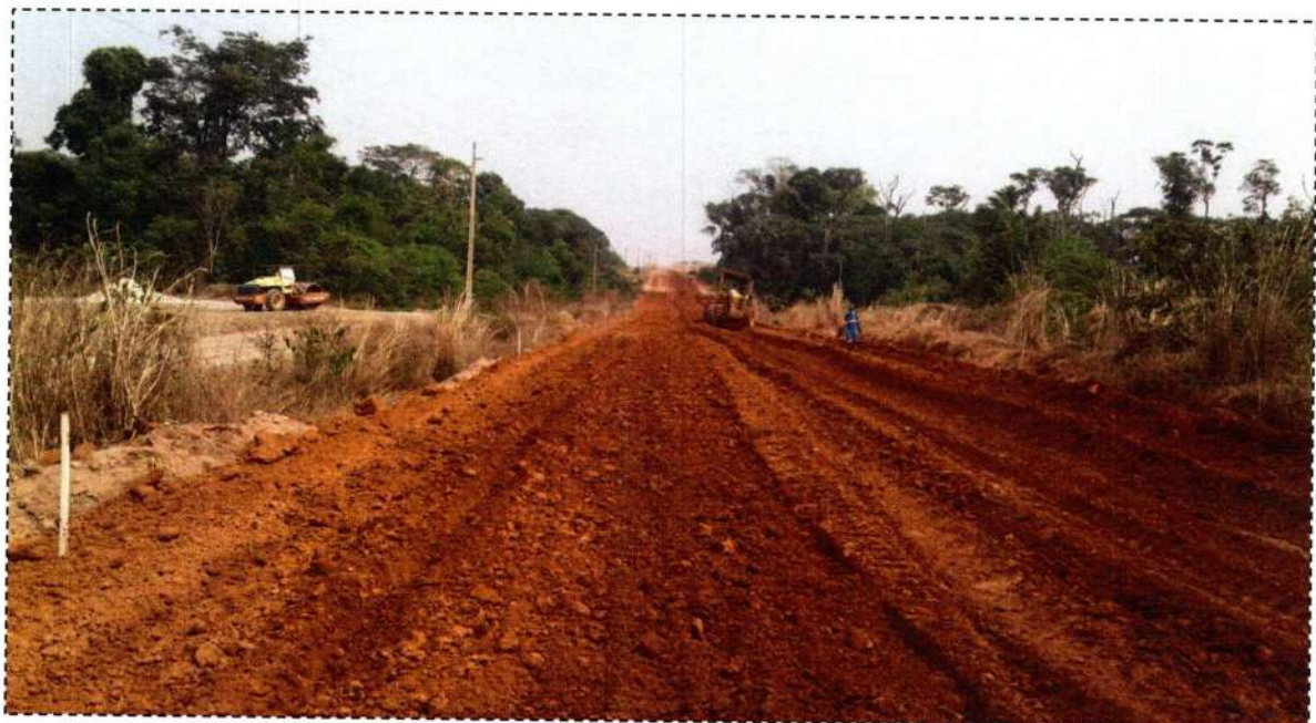
Execução de Base – E4080
