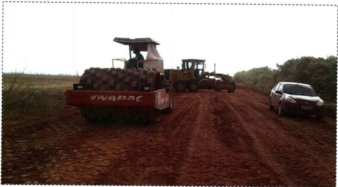
Execução de Base – E4070
