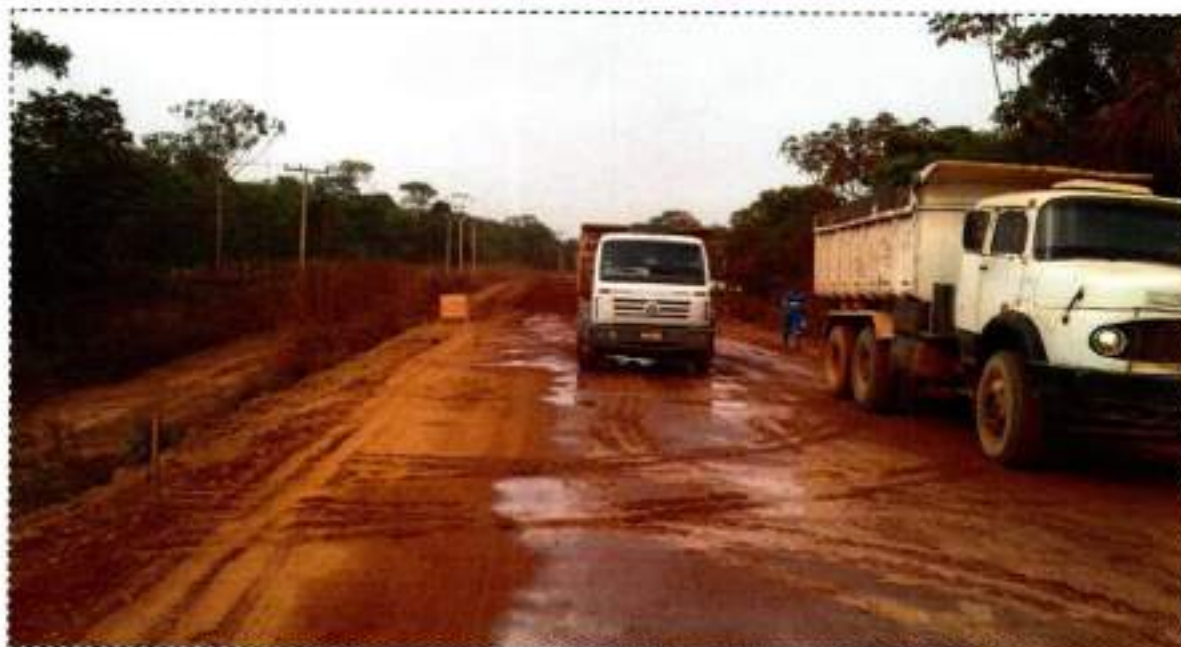
Execução de Base – E4090
