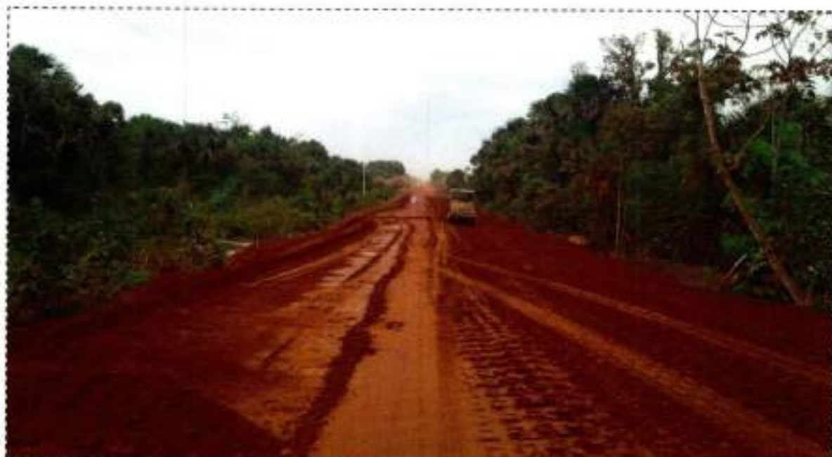
Execução de Base – E4085
