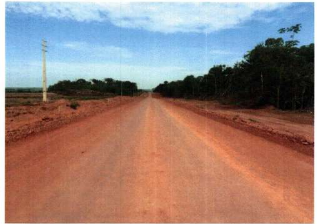
10 - Regularização E-3749 11°48'52"S - 056°40'35"W
