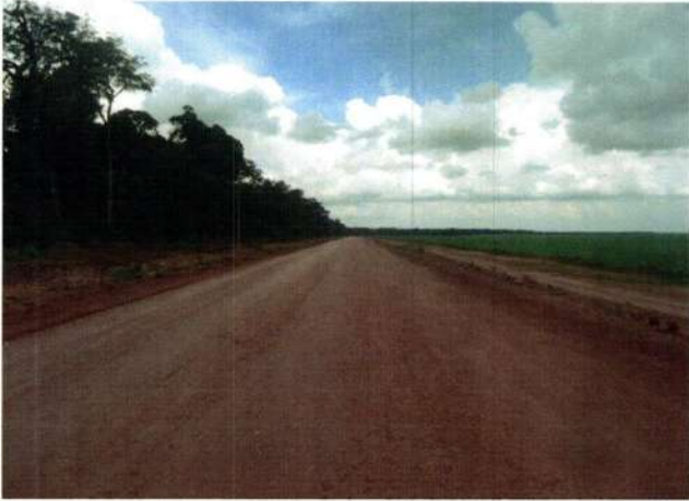
7 - Regularização E-3542 11°48'31"S - 056°41'37"W
