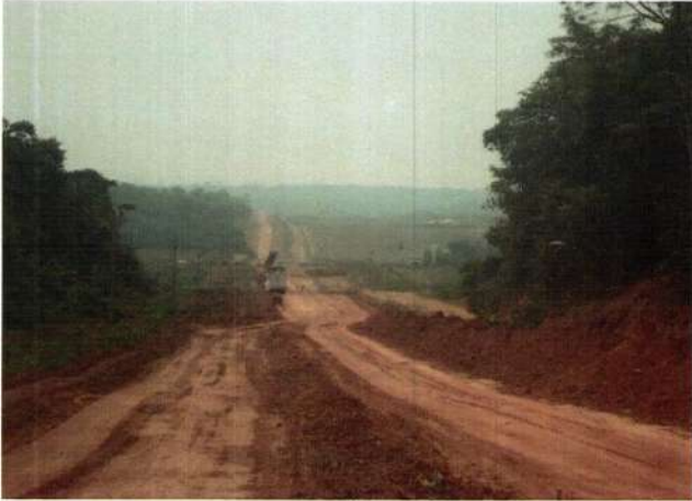
1 - Terraplenagem E-3472 11°47'43"S - 056°43'58"W
