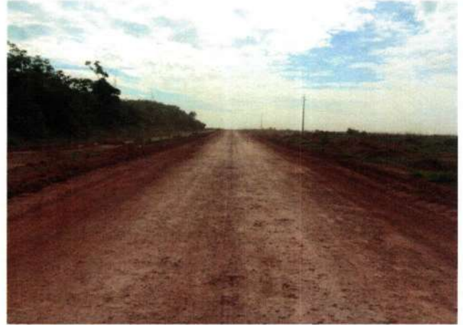
16 - Sub-Base Lançada E-3538 11°49'09"S - 056°39'47"W
