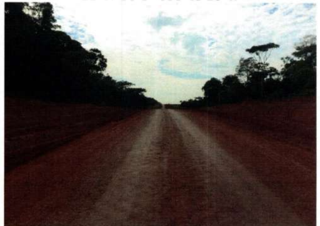
5 - Terraplenagem E-3345 11°48'04"S - 056°42'57"W
