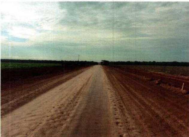
8 - Regularização E-3671 11°48'38"S - 056°41'16"W
