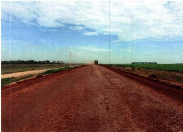
14 - Sub-Base Lançada E-3467 11°49'01"S - 056°40'10"W
