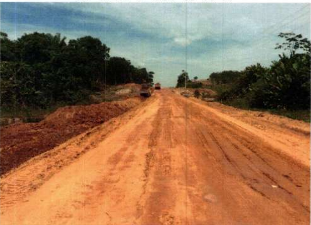
3 - Terraplenagem E-3382 11°47'51"S - 056°43'34"W
