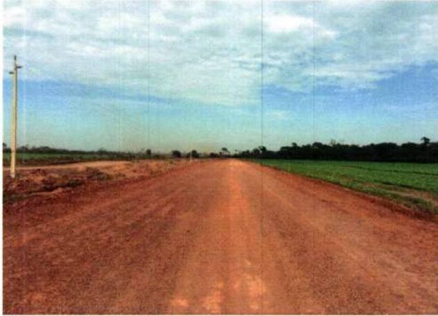
13 - Sub-Base Lançada E-3421 11°49'00"S - 056°40'13"W
