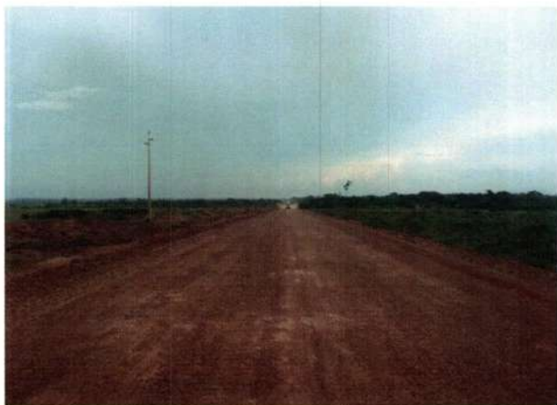
19 - Sub-Base Lançada E-3727 11°49'16"S - 056°39'26"W
