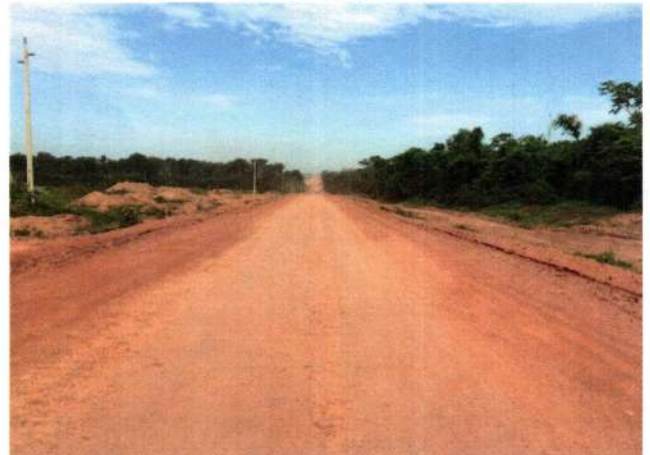
17 - Sub-Base Lançada E-3581 11°49'10"S - 056°39'43"W
