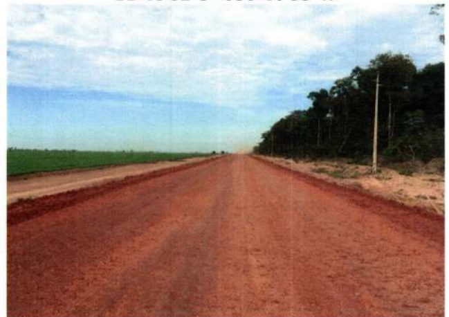
11 - Sub-Base Lançada E-3344 11°48'54"S - 056°40'29"W
