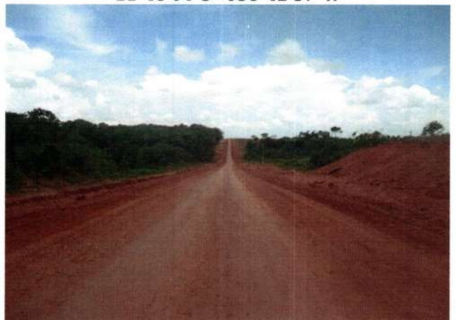
6 - Regularização E-3494 11°48'20"S - 056°42'11"W
