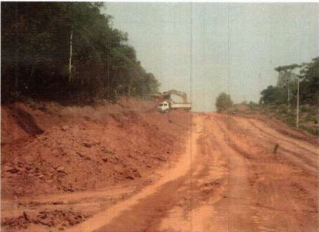
2 - Terraplenagem E-3444 11°47'47"S - 056°43'46"W
