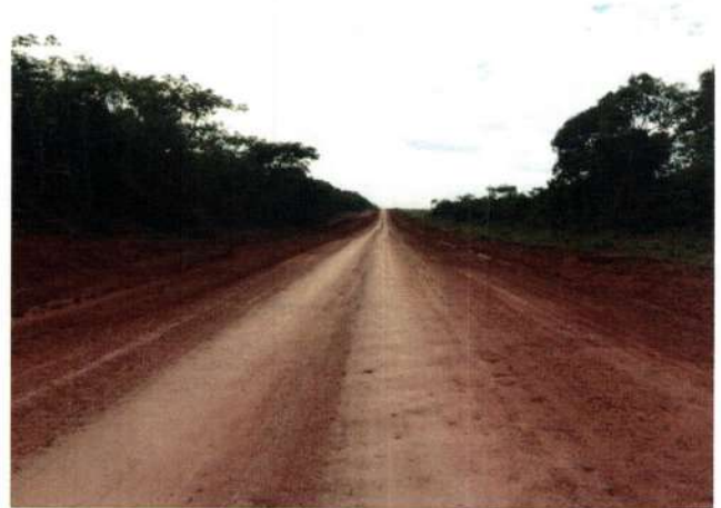
4 - Terraplenagem E-3330 11°47'58"S - 056°43'16"W
