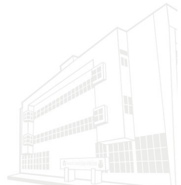
Edifício Marechal Rondon - Sede atual 2013
