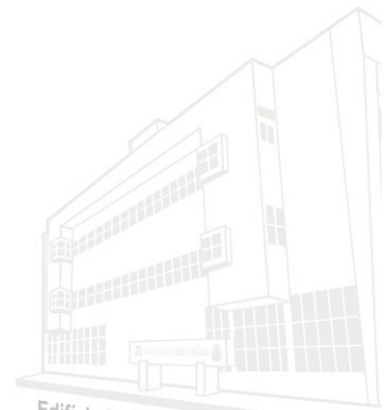
Edifício Marechal Rondon - Sede atual 2013
