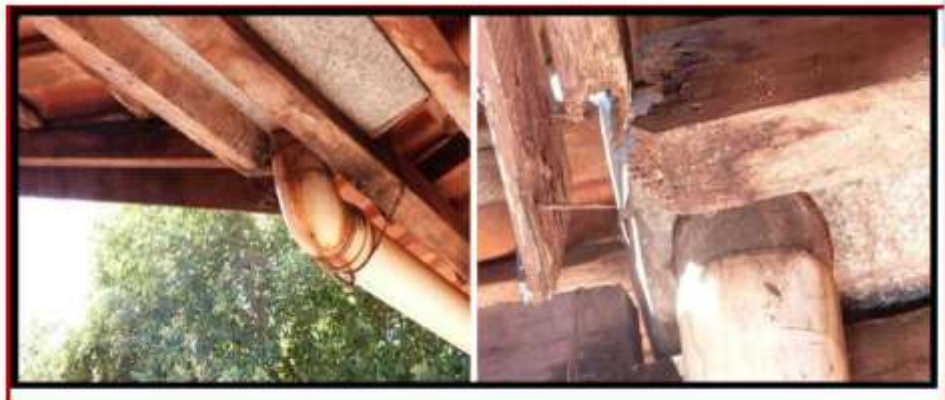
Figura 01: fotos do Telhado Existente para o contrato 344/2012
