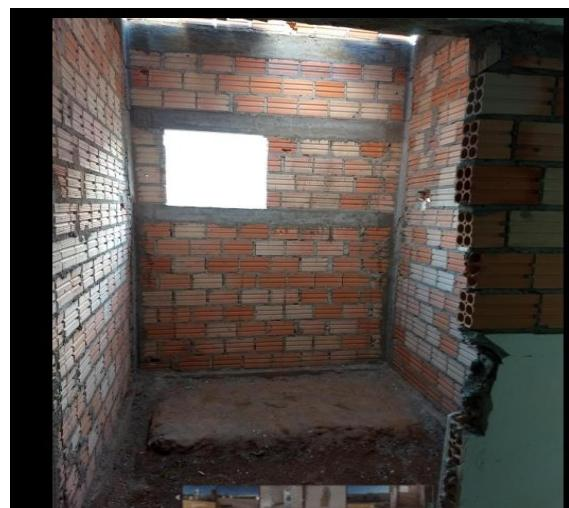
Na ocasião, a equipe técnica constatou que os serviços de pintura epóxi, que haviam sido executados e pagos à empresa CMN – Construtora e Incorporador Ltda-EPP, terão que ser executados novamente, tendo em vista que por falhas nos projetos elétricos, as paredes foram recortadas, conforme demonstradas pelas fotos que seguem:
