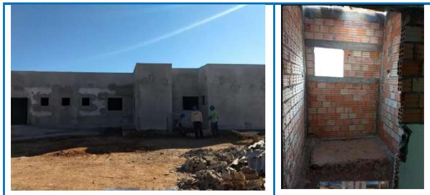
Durante a inspeção, a equipe técnica constatou que os serviços previstos nos novos projetos, alguns, já estavam em execução. Especificamente no projeto elétrico, houve a necessidade de recortar as paredes que já haviam sido pintadas. Assim, os serviços de pintura epóxi que haviam sido medidos e pagos à empresa CMM – Construtora e Incorporador Ltda-EPP, teriam que ser executados novamente, conforme demonstrado pelas fotos que seguem:
