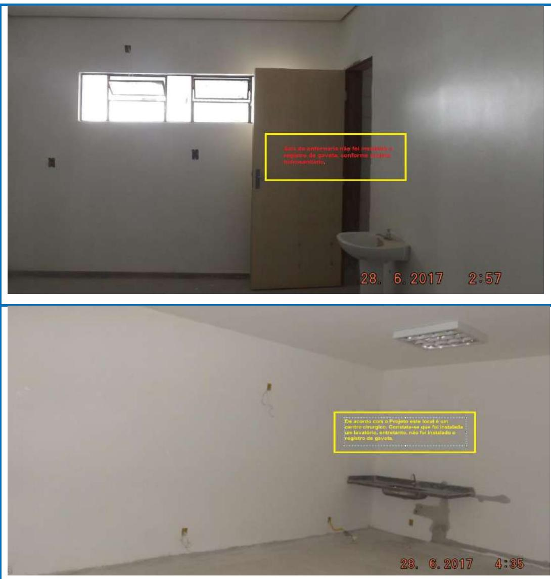
A não instalação de registros de gaveta comprometem o funcionamento dos locais, já que, no caso de uma simples troca de torneira, há risco de alagamento de todo o setor.
