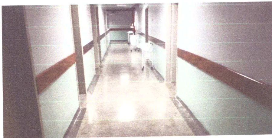
Foto detalhe de correção, local: Corredor bloco reforma (Piso refeito devido ao excesso de fissuras)
