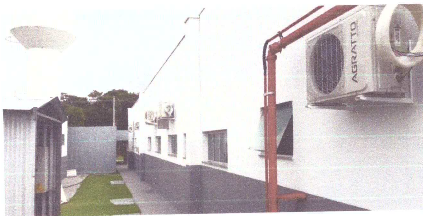
Detalhe fotos das Condensadoras instaladas em parede lateral da edificação.
