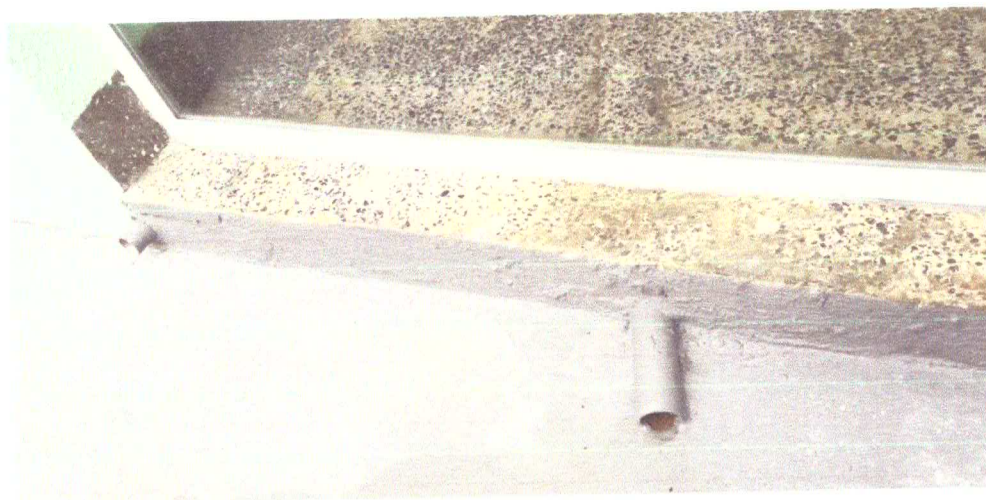
Foto detalhe dreno: Instalados os pontos de drenos para as evaporadoras de ar condicionado.
