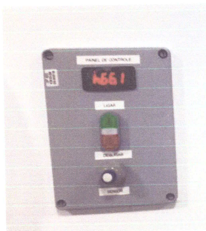
Foto detalhe: Optou-se por sistema com Pannel de controle climatização para o Sistema de Ar Condicionado e Ventilação do Centro Cirúrgico.
