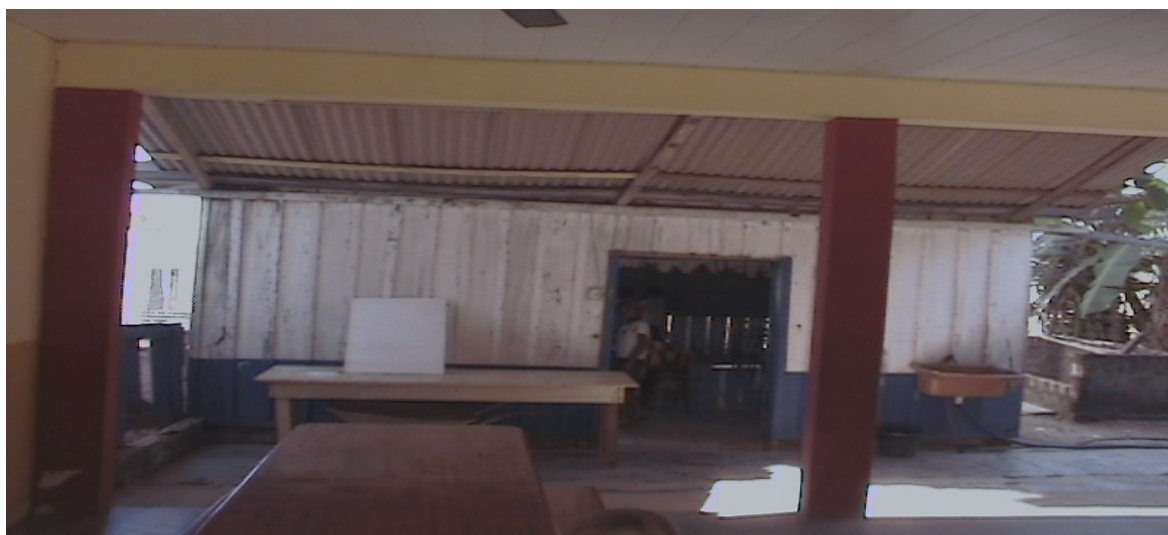
Foto – 006 – Frente da Sala de Aula – BARRACO DE TÁBUA
