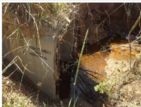
Inspeção realizada em 02.07.2015
