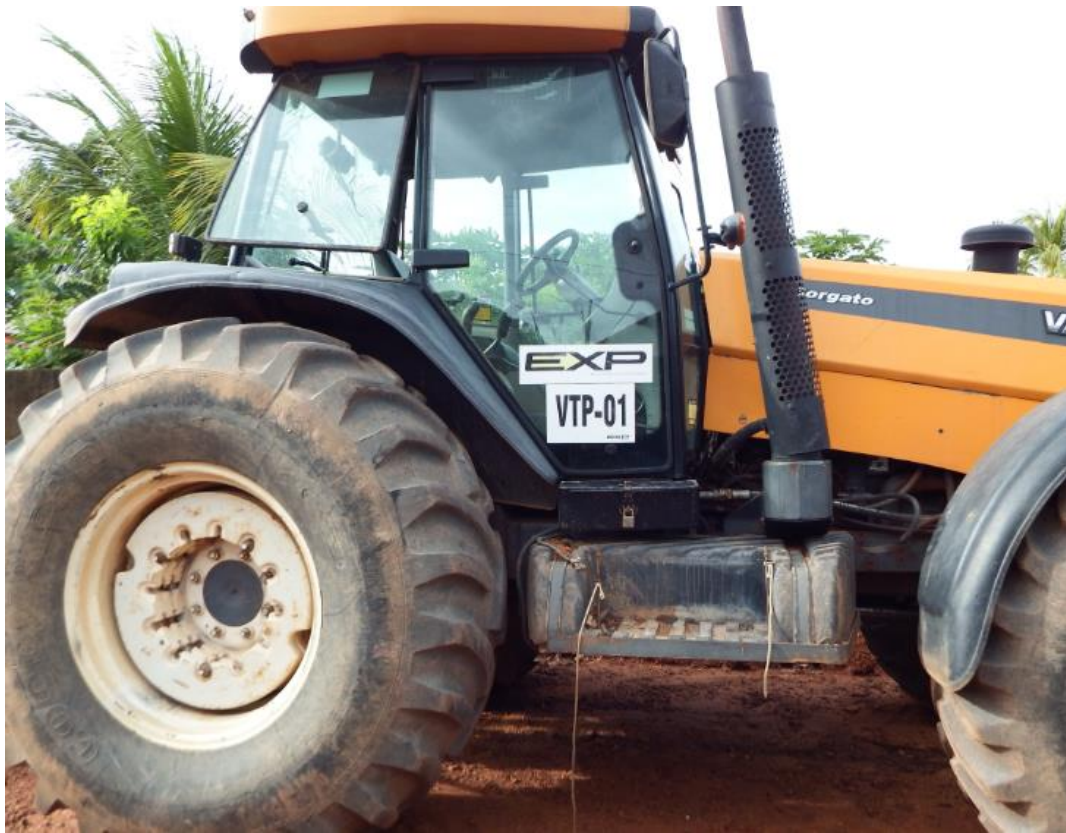
Figura 40 - Equipamento encontrado no local da obra (Rua Dona Eugênia) com etiqueta em nome da empresa EXP ENGENHARIA LTDA-ME.
